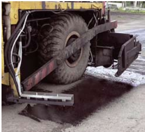
Укладка асфальта по технологии «Новачип»
