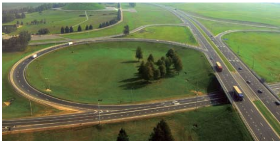
Автомобильная дорога М-2 с путепроводом у Кургана Славы
