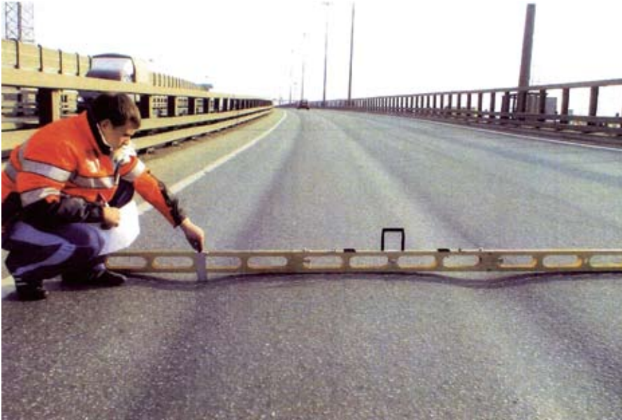
Рис. 2. Глубокая колея износа в асфальтобетонном покрытии на левой полосе КАД СПб
