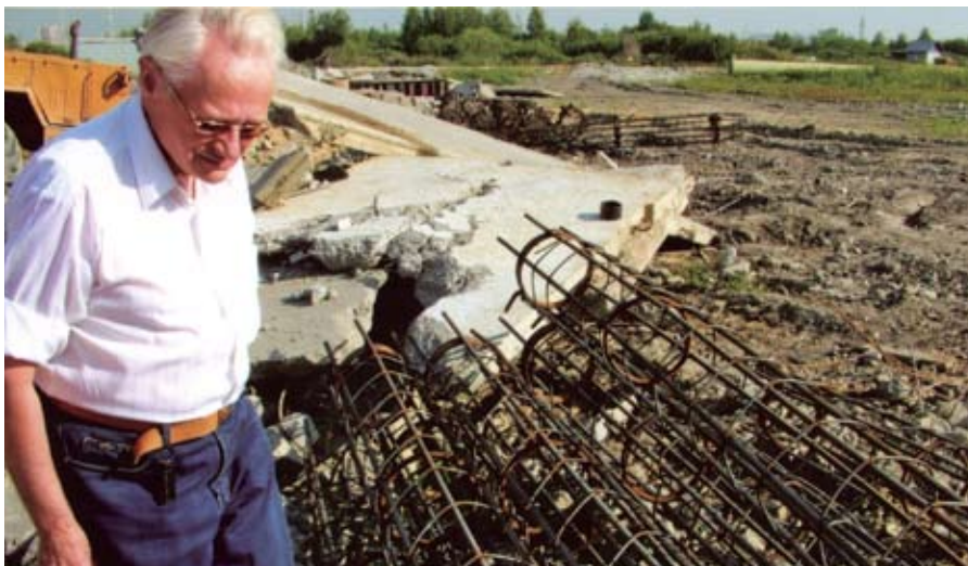
На строительстве опоры №17 путепровода Пулковской развязки КАД Санкт-Петербурга (лето 2006 г.)
