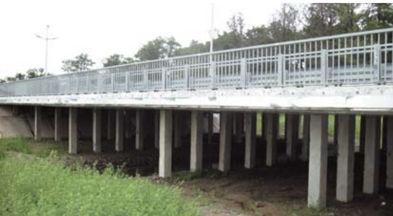
Свайноплитная мостовая конструкция
