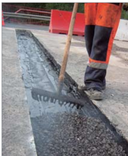
Рис. 5. Распределение вяжущего и каменного материала
