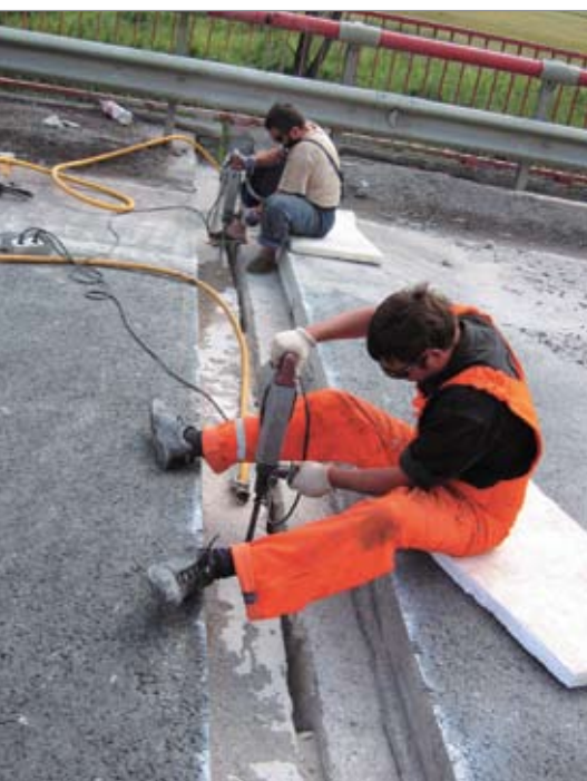
Рис. 3. Подготовка поверхности штрабы
