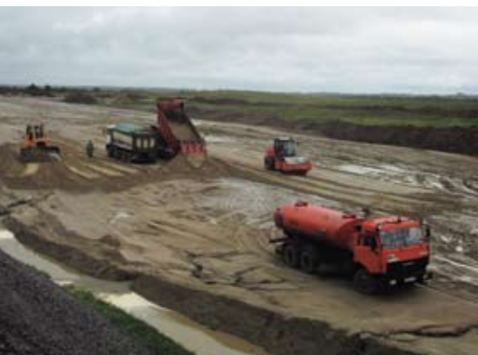
На строительстве 4-й очереди
