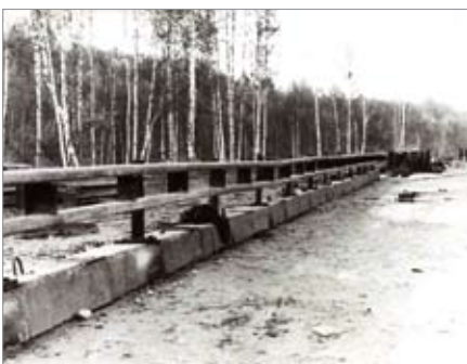
Рис. 1. Барьерные ограждения во время испытаний
