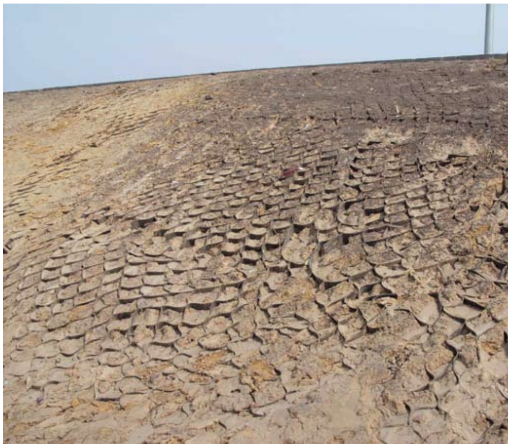
Рис. 3. Результат применения контрафактной георешетки в течение одного летнего сезона
