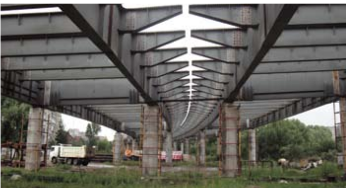
Строительство моста через реки Старая и Новая Преголя
