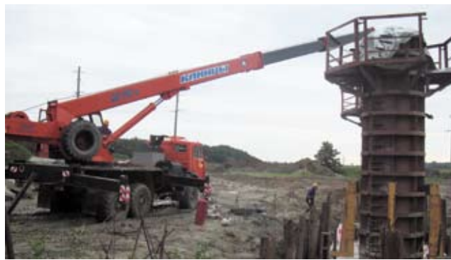
На строительной площадке
