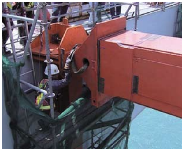
Рис. 5. Монтаж замыкающих блоков центрального пролета моста Камнерзов.
