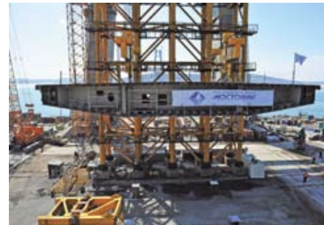
Рис. 4. Подъем монтажной панели
