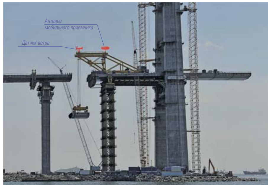
Рис. 7. Монтаж панели металлической балки жесткости
