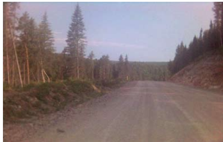
Автомобильная дорога на трассе Белорецк – Учалы (26-36 км). Построена на неокисленном компаундированном битуме (технология 2) в июне 1994 г. Снимки — июль 2009 г.
