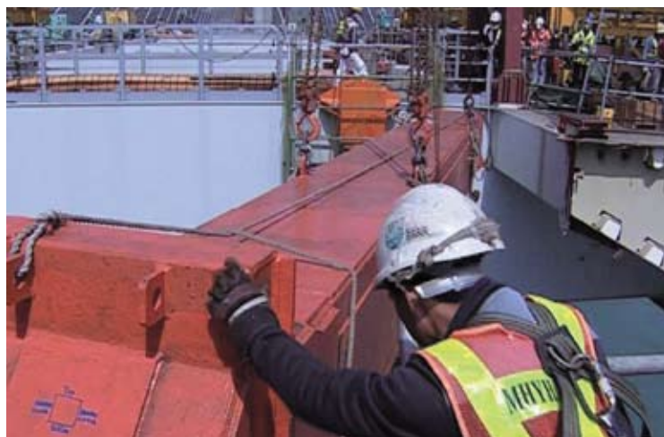
Рис. 5. Монтаж замыкающих блоков центрального пролета моста Камнерзов.
