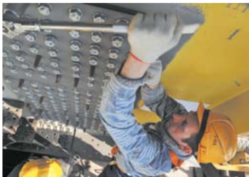
Рис. 6. Установка и затяжка высокопрочных болтов по узлу стыковки
