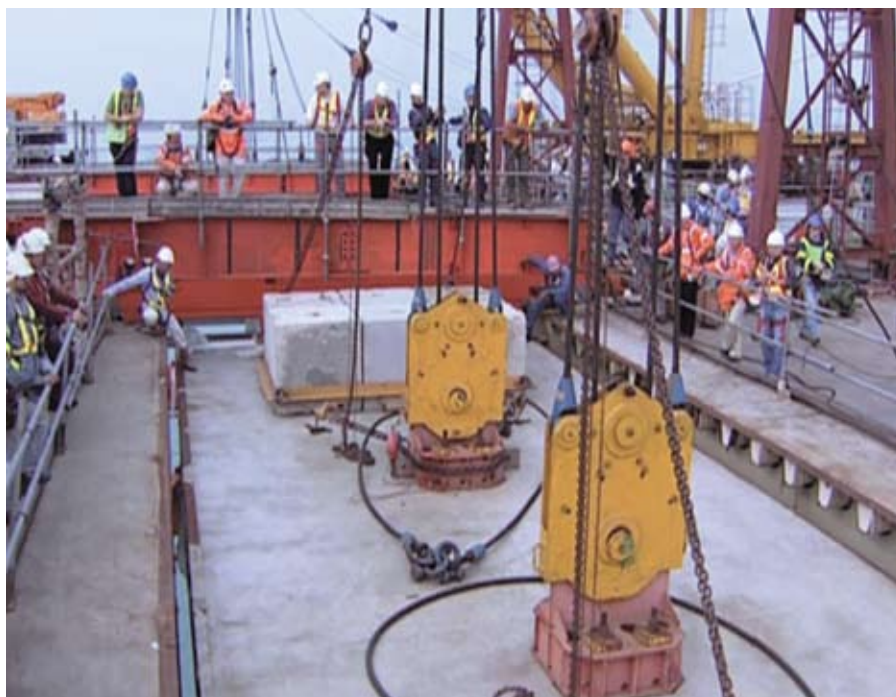
Рис. 6. Замыкание центрального пролета моста Камнерзов.
