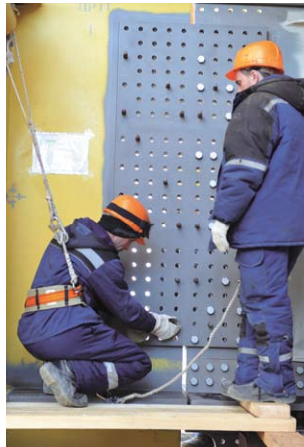
Рис. 5. Пристыковка монтажной панели
