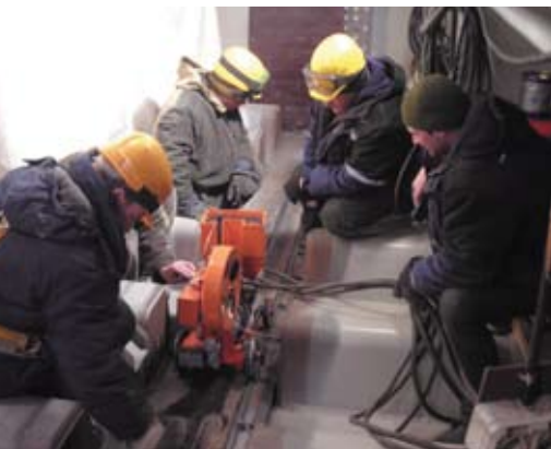
Рис. 8. Автоматическая сварка под флюсом поперечного стыка монтажных панелей в створе оси мостового перехода
