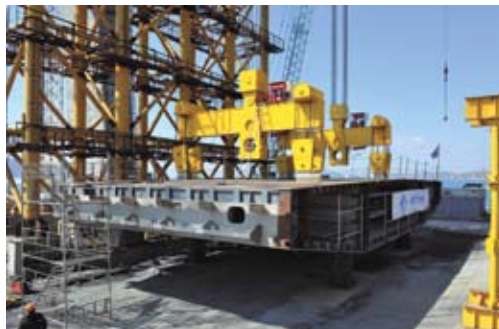
Рис. 3. Крепление монтажной панели к монтажному агрегату
