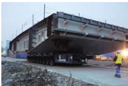
Рис. 2. Перемещение панели под монтажный агрегат
