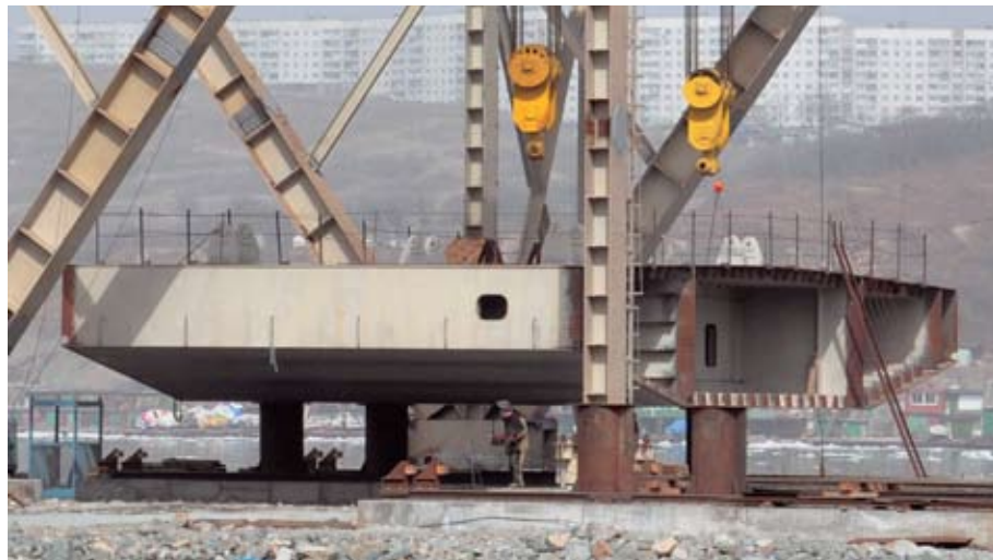
Рис. 13. Общий вид монтажной секции
