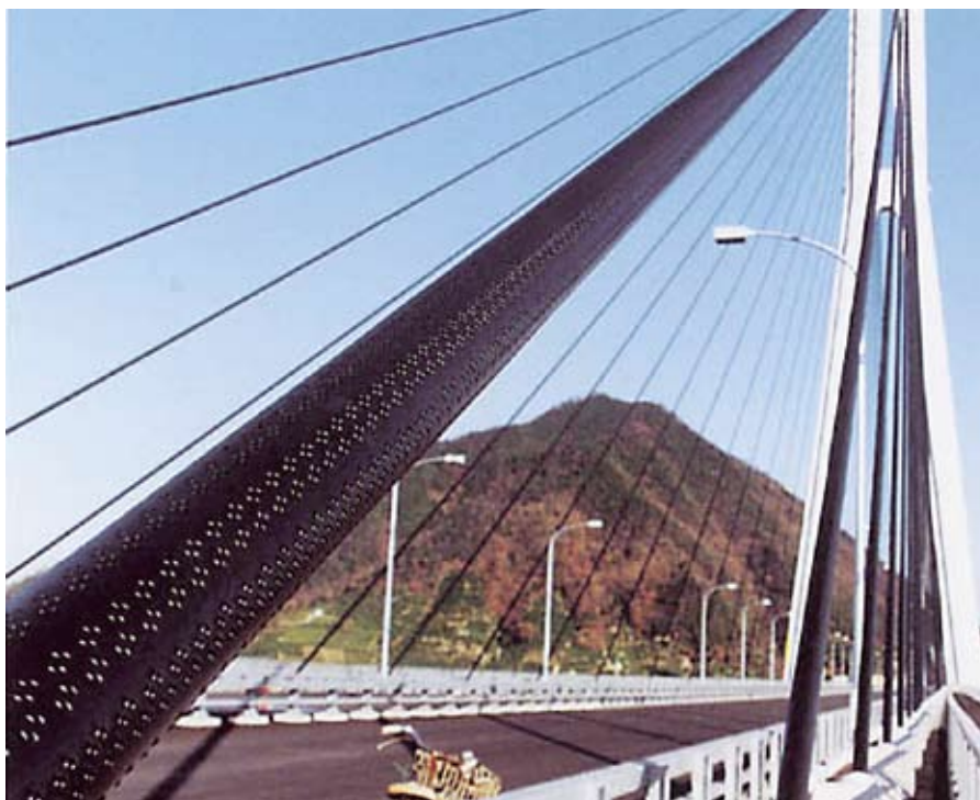
Ванта с вдавленной поверхностью для защиты от вибраций
