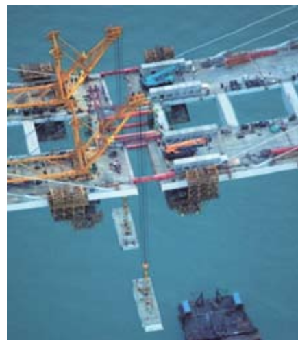
Рис. 4. Монтаж СВСиУ объединения консолей центрального пролета моста Камнерзов.
