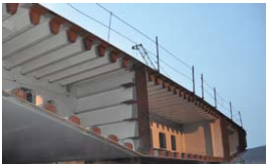
Рис. 9. Общий вид поперечного стыка панели с большим количеством трапециевидных ребер
