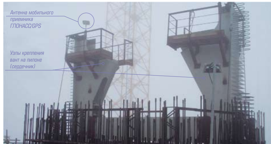
Рис. 6. Антенна мобильного приемника на пилоне М6
