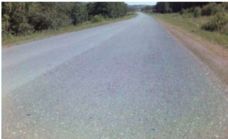
Автомобильная дорога на трассе Белорецк – Учалы (26-36 км). Построена на неокисленном компаундированном битуме (технология 2) в июне 1994 г. Снимки — июль 2009 г.
