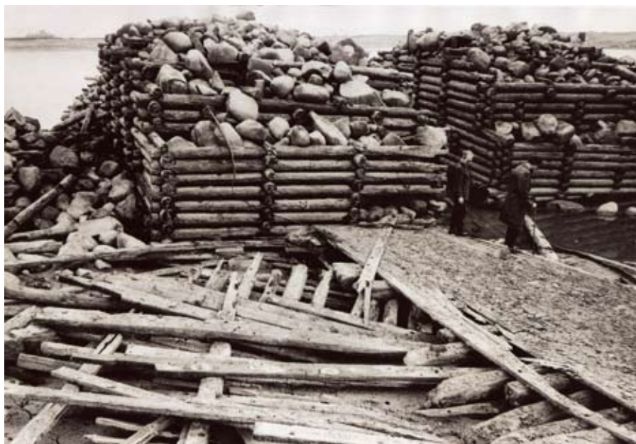
Часть линий ряжей перед фортом Константин. На заднем плане отсыпка котлована С-1. 14 мая 1986 г.
