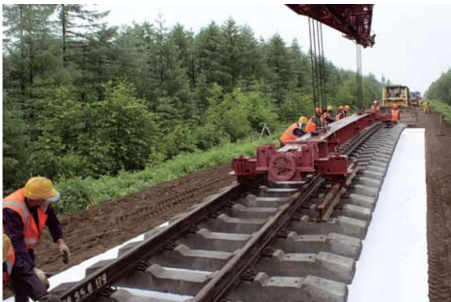
Укладка железнодорожного полотна
