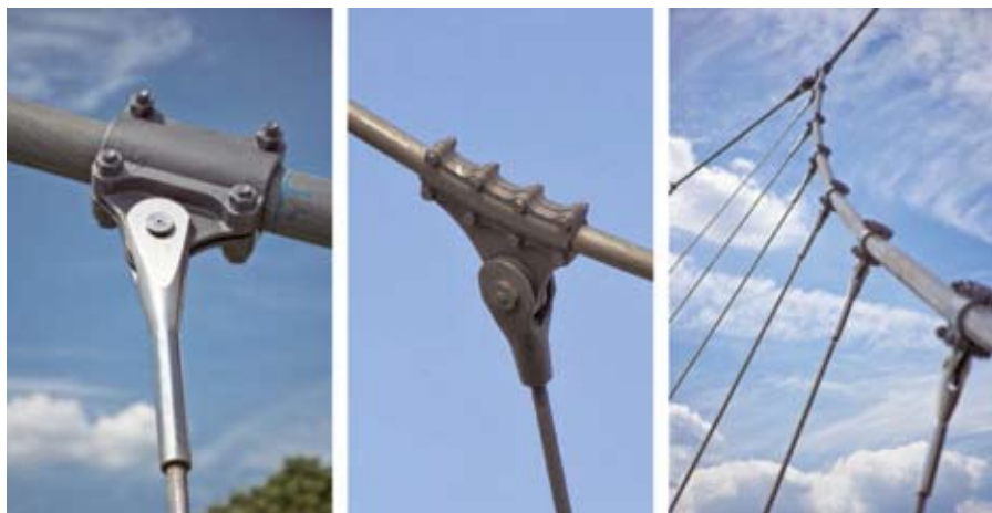
Рис. 10. Фрезерованные стяжные хомуты канатов
