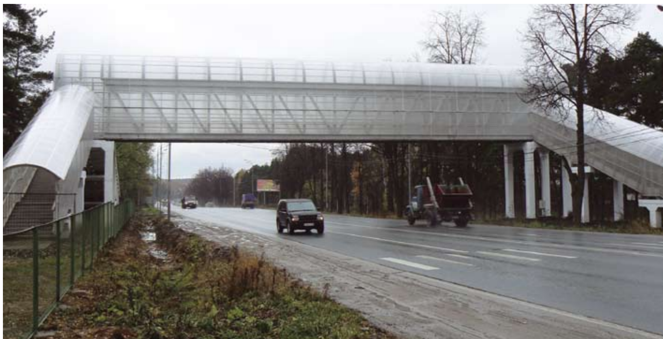
Мост на км 29+600 через Можайское шоссе в пос. ВНИИССОК Одинцовского района Московской области
