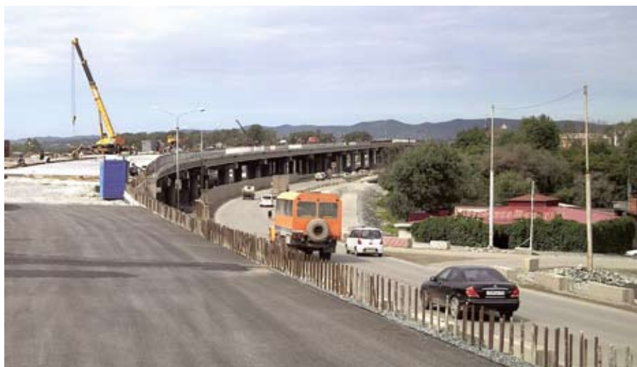
Реконструкция автомобильной дороги аэропорт «Кневичи—станция Санаторная». Эстакада №1 на ПК7+92,77
