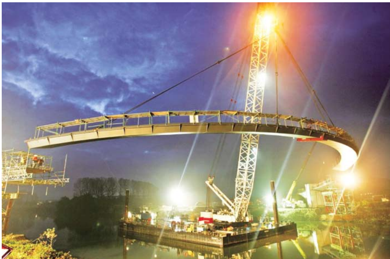
Рис. 14. Монтаж центральной секции пролетного строения плавучим краном
