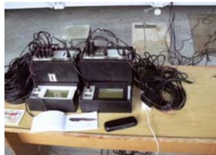
Система тензометрического контроля искусственных сооружений для записи напряжений в элементах марша
