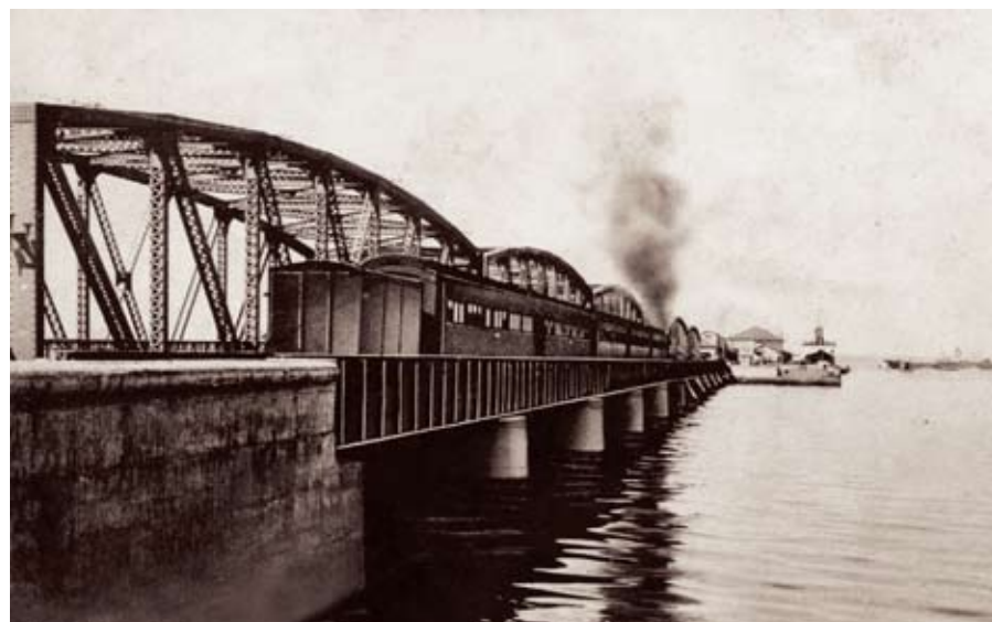
Железнодорожный мост в Отомари
