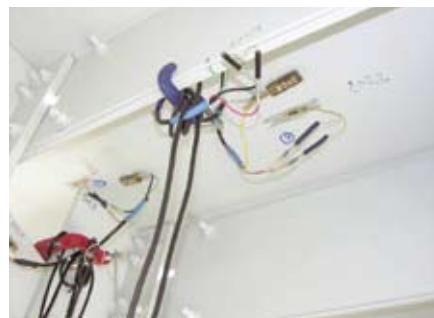
Тензодатчики на элементах пролетного строения
