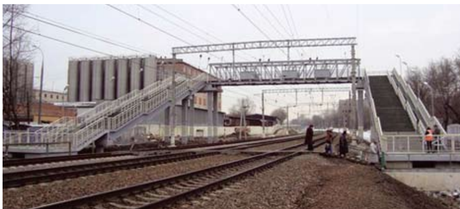
Пешеходный мост на 7 км ПК 9 участка Москва Пассажирская Курская–Кусково Московской железной дороги
