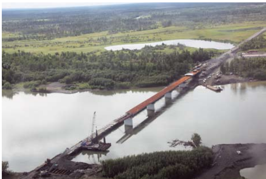
Надвижка пролетного строения моста через реку Камчатка
