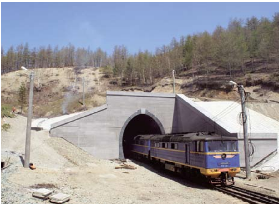
Южный портал тоннеля №21
