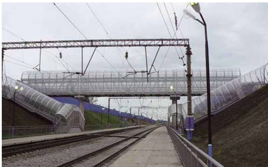
Пешеходный мост у платформы 586 км участка Рязск–Чертково Юго-Восточной железной дороги в г. Воронеже
