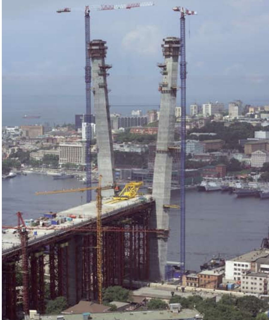
Строительство моста через бухту Золотой Рог. Сооружение пролетное строение 9–13 пилон (опора) №9 175 метров
