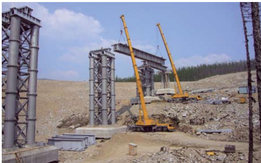
Монтаж пролетного строения на участке Улак—Эльга
