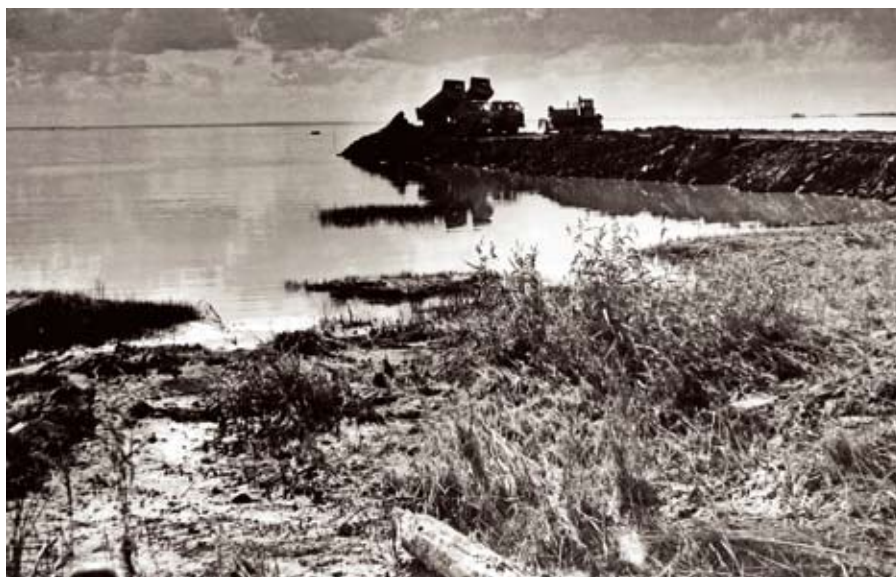
Строительная площадка «Горская». Пионерная отсыпка дамбы «Д-11». 1980 г.
