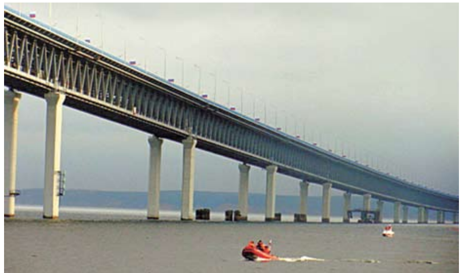
Старый и новый мост через Волгу
