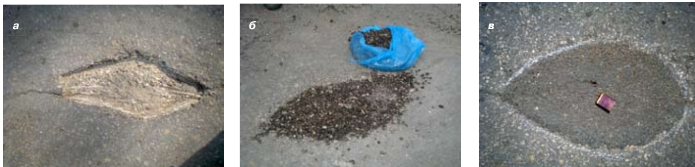
Рис. 2. Ремонт выбоины на дорожном покрытии с произвольной конфигурацией в плане: а — выбоина, подлежащая ремонту; б — распределение смеси; в — выбоина через несколько часов после ремонта
