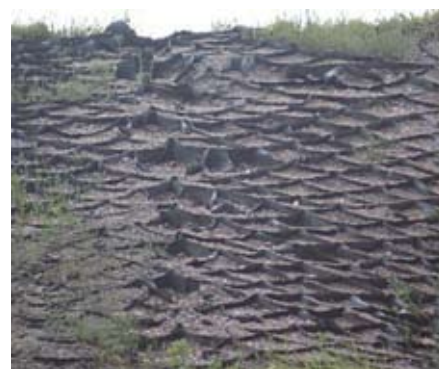
Рис. 3. Последствия ползучести полиэтиленовых георешеток
