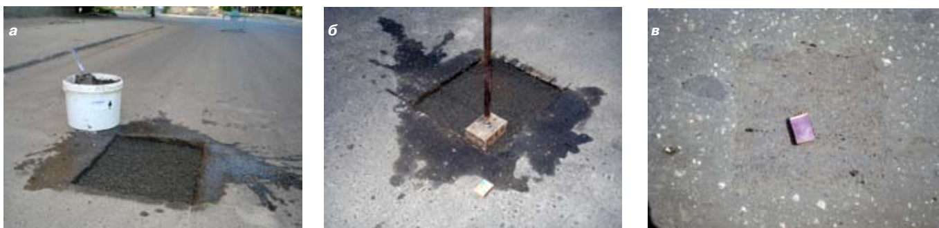
Рис. 3. Ремонт выбоины небольшого размера на дорожном покрытии с прямоугольным очертанием в плане: а — распределение смеси; б — уплотнение смеси металлической трамбовкой; в — отремонтированная выбоина на третьи сутки после ремонта
