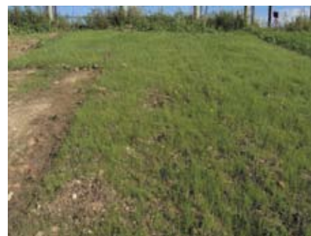
Рис. 4. Арнит на Загорской ГАЭС через 3 недели после монтажа
