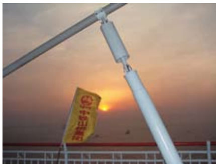
Адаптивный демпфер на мосту Сутонг в КНР
