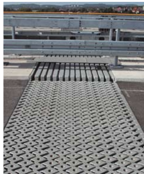
Конструкции с ромбическими элементами на автобанах A73, Германия
