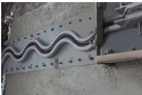
Шов XW1 при монтаже на Donnersbergerbrücke в Мюнхене
