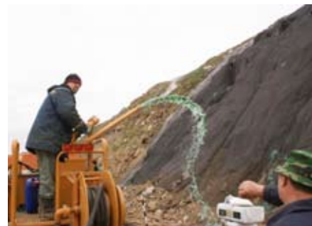
Рис. 2. Гидропосев
