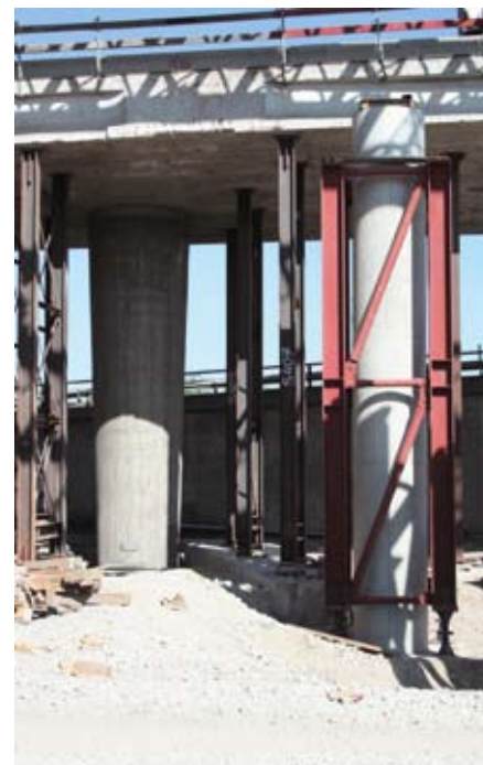
Реконструкция эстакады Freimann, автобан А9 Берлин–Мюнхен, съезд 75
