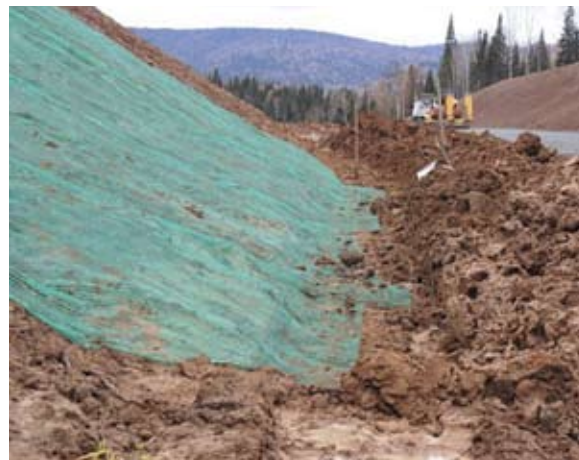
Рис. 7. Укрепление откосов геоматом Геосклон 3 D зеленого цвета: слева — Нижний Новгород, справа — Таштагол
