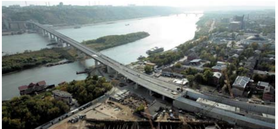
Продление Автозаводской линии метрополитена в Нижнем Новгороде от станции «Московская» до станции «Горьковская» (2007–2011 гг.)
