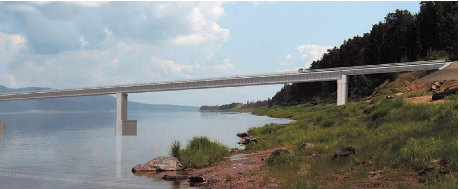
Объемы основных работ
