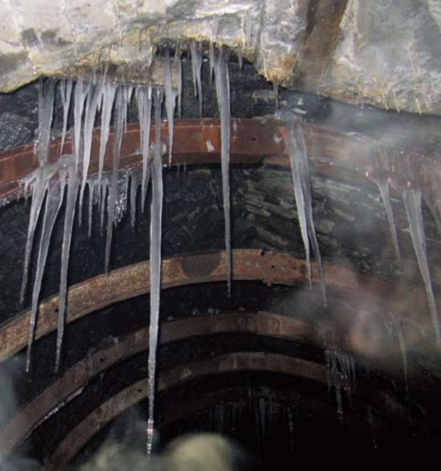
Участок многофункциональной штольни без обделки перед началом реконструкции
