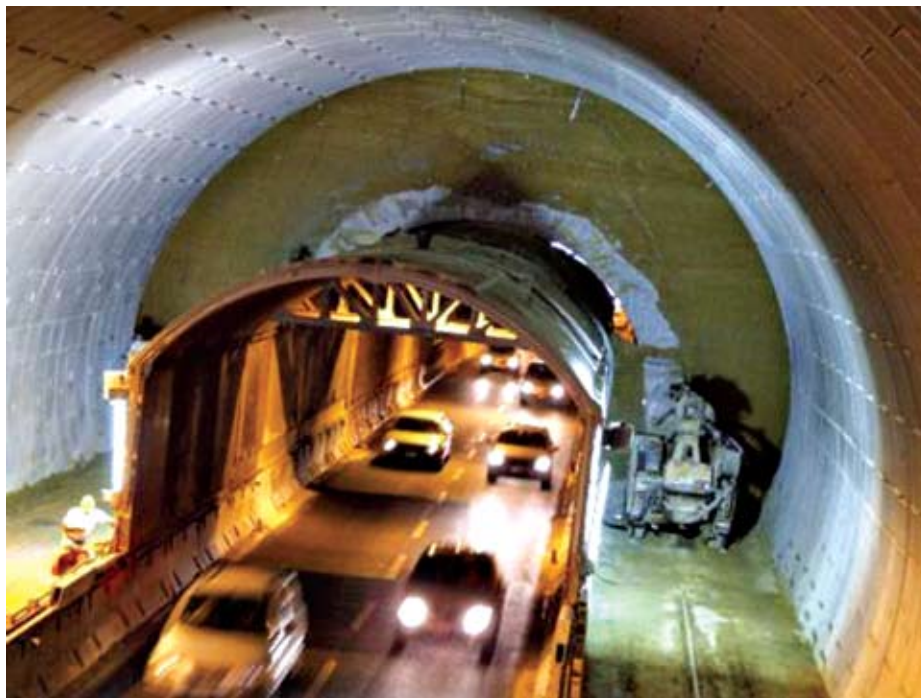
Рис. 1. Тоннель Наццано: движение под защитным стальным щитом
