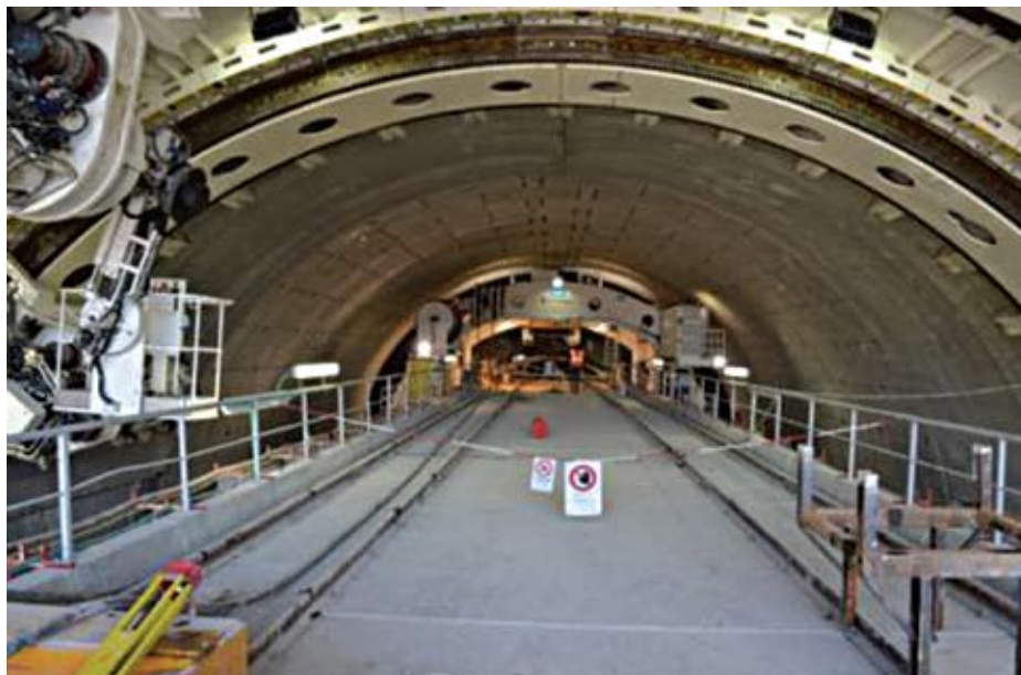
Рис. 7. Тоннель Монтедомини: пространство площадки над щитом
