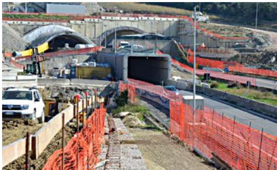
Рис. 6. Тоннель Монтедомини: щит, обеспечивающий безопасность движения
