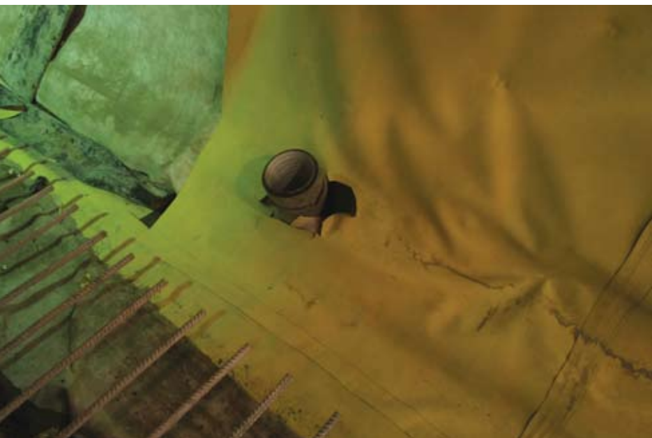
Выполнение пленочной гидроизоляции с выводом дренажной ревизии
