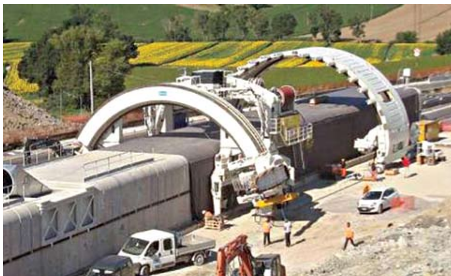
Рис. 8. Две машины, используемые для расширения тоннеля Монтедомини
