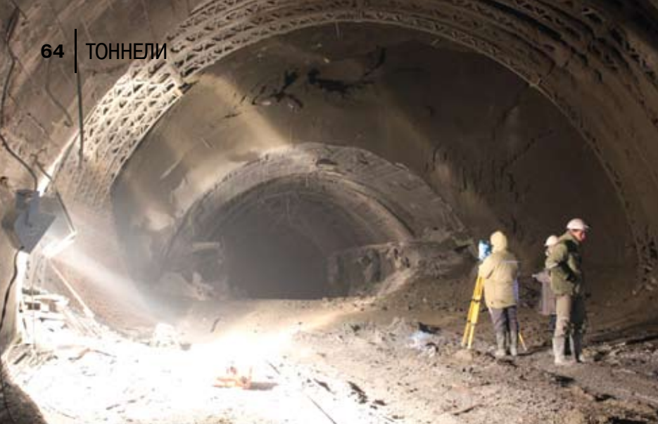
Пере проходка калоттной части транспортного тоннеля с возведением временной крепи
