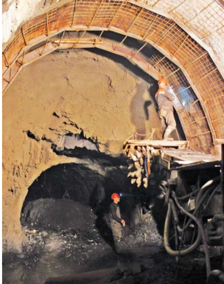
Пере проходка многофункциональной штольни с возведением временной крепи на участке геологического разлома
