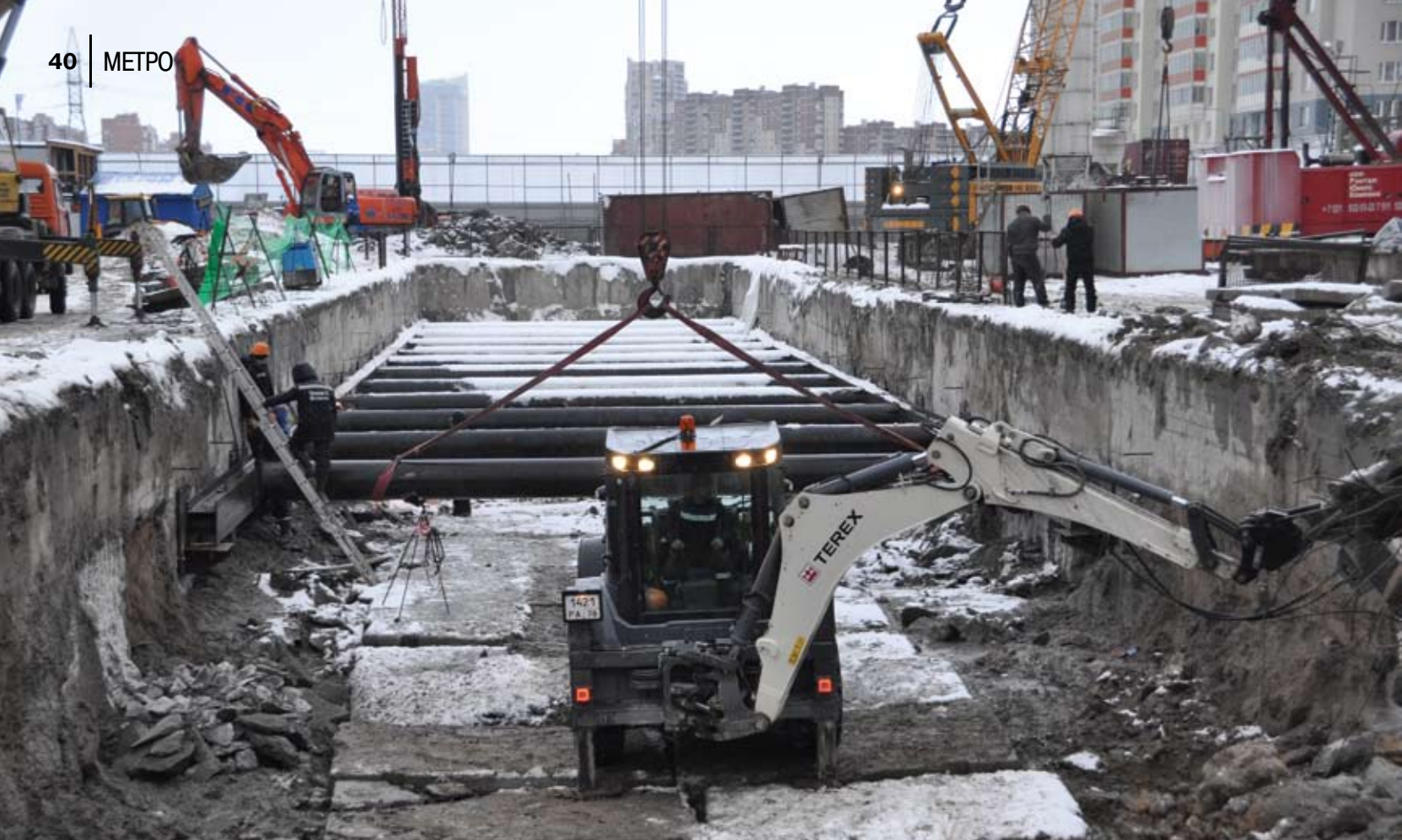
Подготовительные работы по строительству НВЛ, разработка прямого участка стартового котлована
