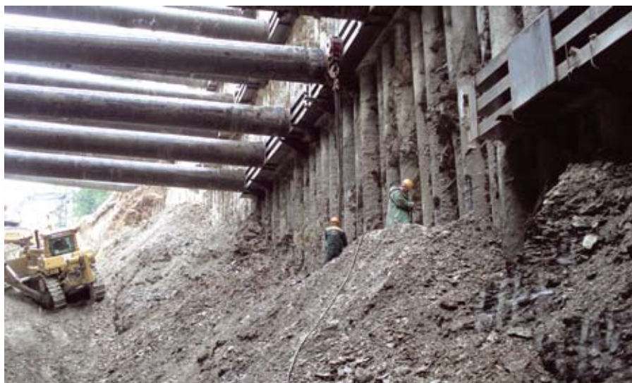
Сооружение распорного крепления
