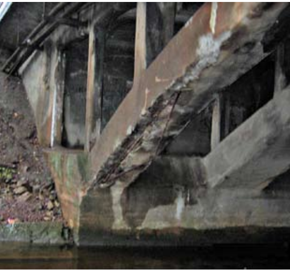
Рис. 9. Шлиссельбургский мост. Удар негабаритным водным транспортом
