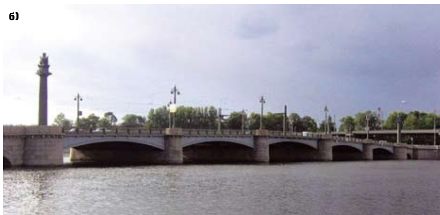
Ушаковский мост через р. Большую Невку: а — до реконструкции; б — в настоящее время
