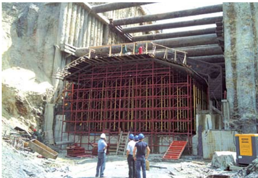
Сооружение перекрытия тоннеля
