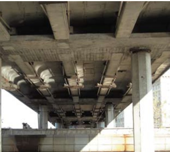
Рис. 10. Кронштадтский путепровод с элементами усиления
