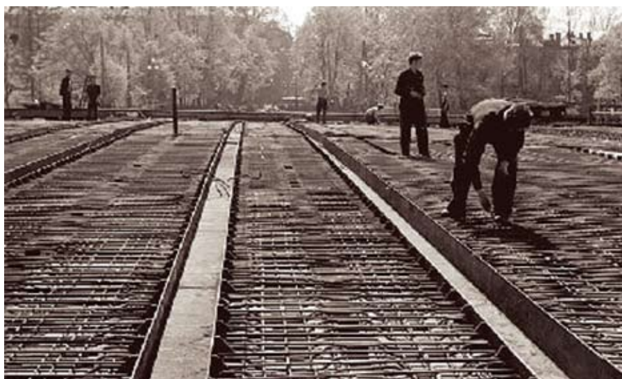
Реконструкция Каменноостровского моста: железобетонная плита разводного пролета. 1954 год
