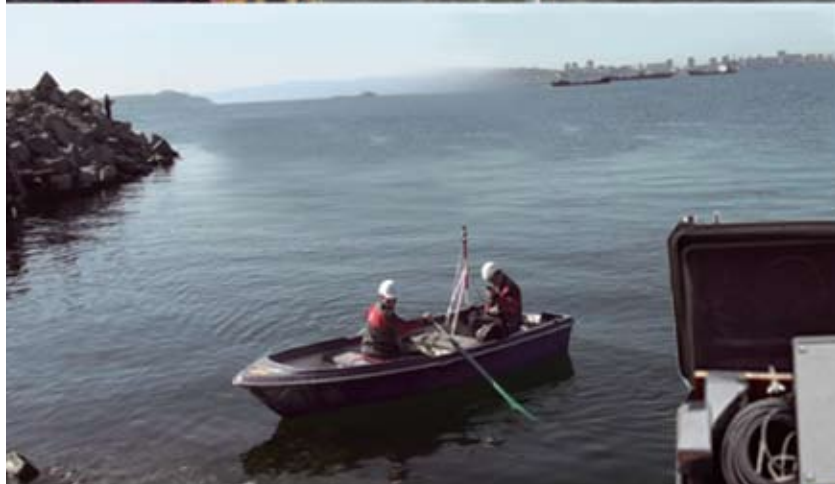
Рис. 4. Контроль сооружения технологической площадки
