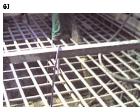
Рис. 1. Контроль величины защитного слоя железобетонной конструкции: а — Ферроскан PS 200; б — результаты обработки
