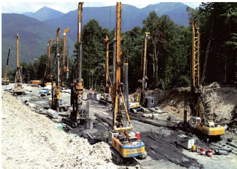
Сооружение ограждающих стен на тоннеле на ПК86
