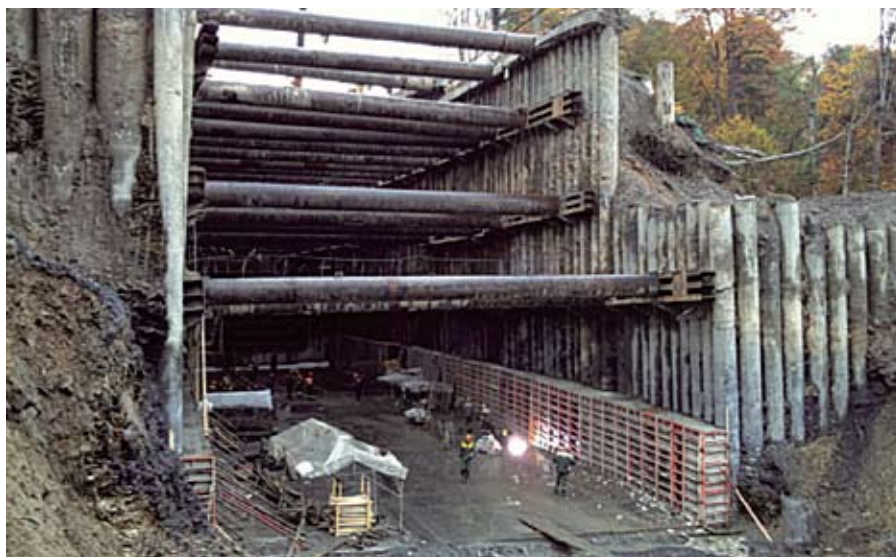
Сооружение лотка и стен тоннеля
