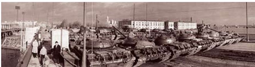
Испытание Тучкова моста
