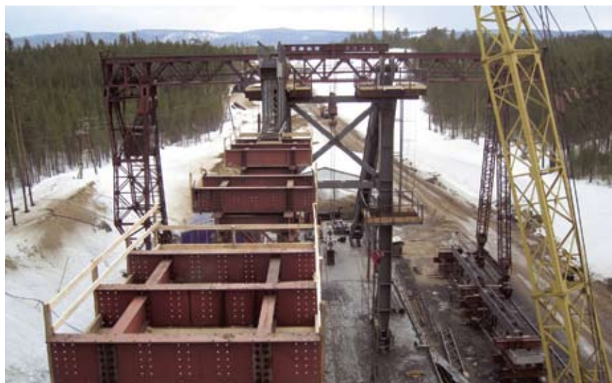
Монтаж шпунгельной системы
