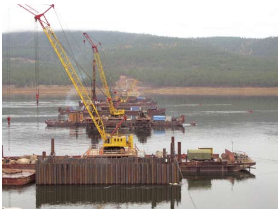
Рис. 4. Сооружение опор с плавсредств. Октябрь 2009 года
