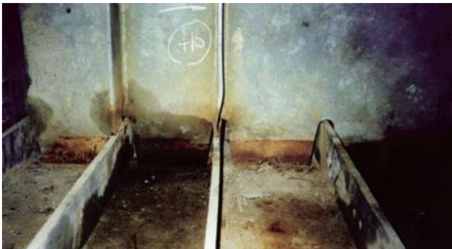
Рис. 10. Потеря устойчивости полудиафрагмы, погибь стенки полудиафрагмы в нижней части (до 40 мм) и вертикального ребра жесткости (до 16 мм), разрыв углового сварного шва между стенкой полудиафрагмы и нижней плитой
