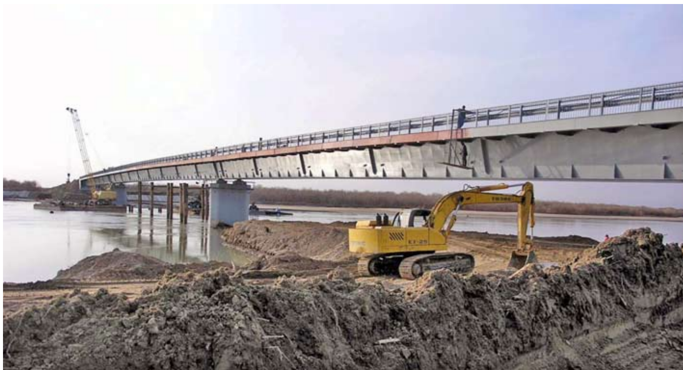
Рис. 8. Мост через р. Сырдарью в Республике Казахстан
