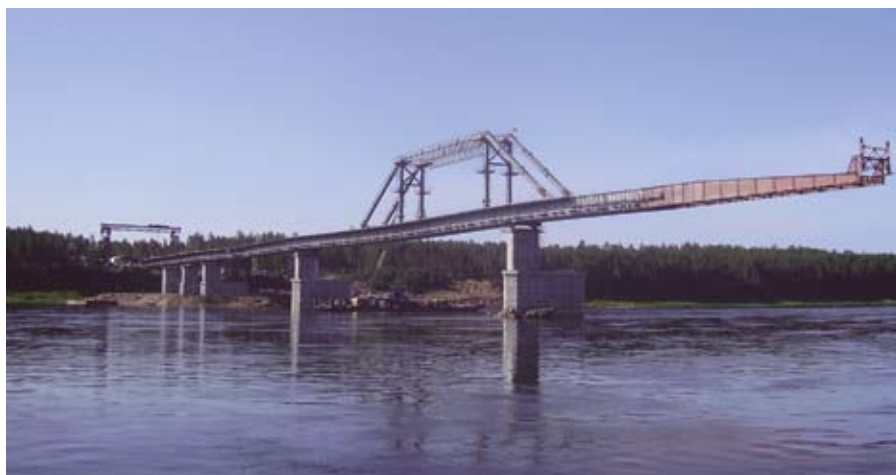
Рис. 2. Надвигка пролетных строений в пролетах 1–12
