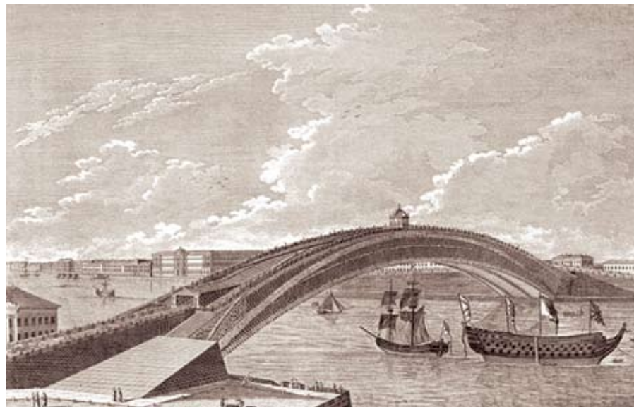
Арочный деревянный мост через Неву в Петербурге. Проект И. Кулибина
