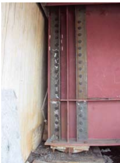
Рис. 11. Повреждения несущих конструкций пролетного строения
