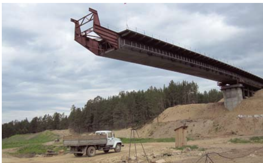
Рис. 3. Надвигка пролетного строения в пролетах 12–16
