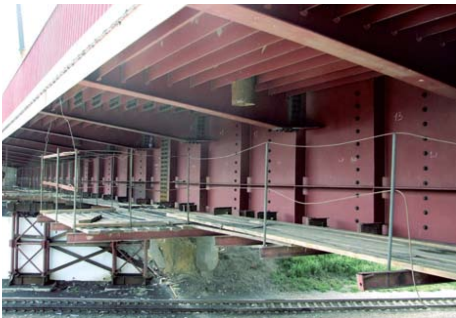
Рис. 10. Потеря устойчивости полудиафрагмы, погибь стенки полудиафрагмы в нижней части (до 40 мм) и вертикального ребра жесткости (до 16 мм), разрыв углового сварного шва между стенкой полудиафрагмы и нижней плитой
