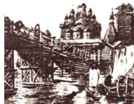
Деревянный мост через Волхов в Великом Новгороде
