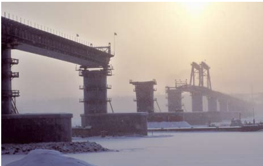
Одновременный монтаж с двух берегов
