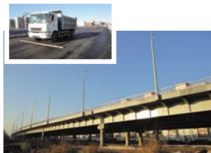
Испытания сооружений комплекса городского моста через реки Старая и Новая Преголя в Калининграде
