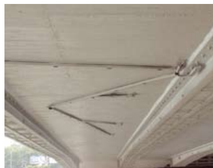
Рис. 4. Датчики напряжения на мосту Александра Невского
