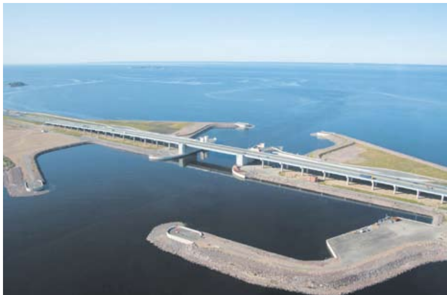
КЗС. Автодорожный подъемный мост на судопропускном сооружении С2
