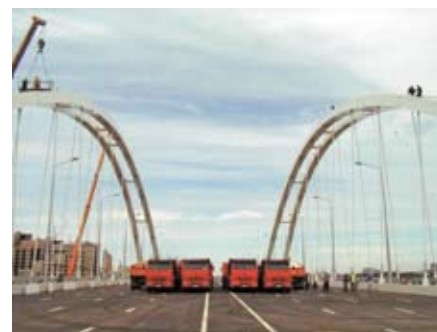
Испытания арочного пролетного строения моста через Ишим в Астане
