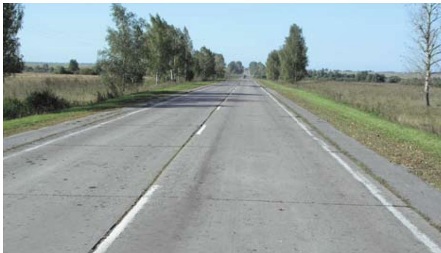
Рис. 3. Дорога М3 «Украина», км 515, год строительства — 1958
