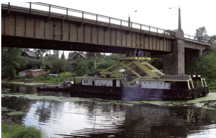
Рис. 2. Ремонтная плавучая база в работе
