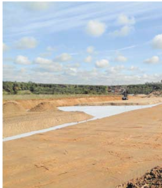
Рис. 5. Для исключения работ по замене слабых грунтов широко применен геотекстиль и дренаж глубокого заложения
