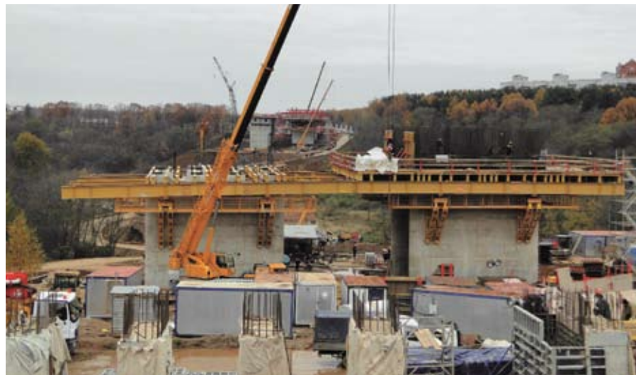
Строительство моста через р. Чаченку
