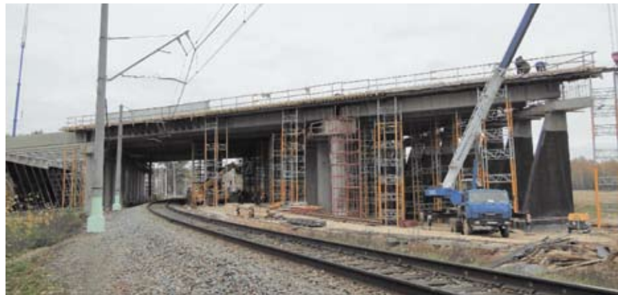
Мост через Усовскую железнодорожную ветку
