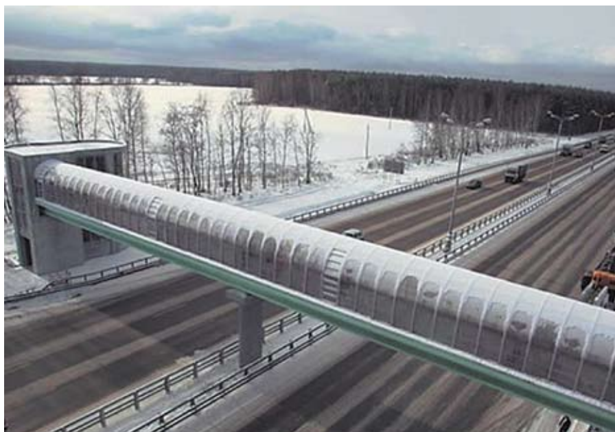
Монолитное пролетное строение, выполненное из композитных материалов
