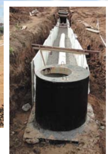
Рис. 5. Для исключения работ по замене слабых грунтов широко применен геотекстиль и дренаж глубокого заложения
