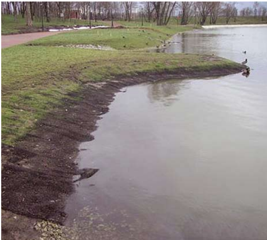
Рис. 3. Закрепление берега геокомпозиционной системой
