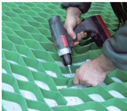
Рис. 4. Укладка объемной полимерной георешетки
