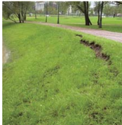
Рис. 4. Закрепление берега каменной наброской со сплошной одерновкой
