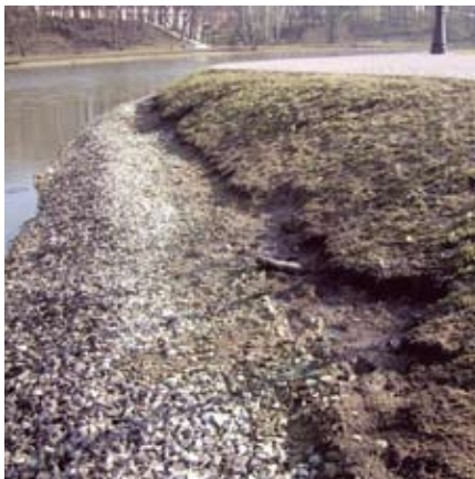
Рис. 4. Закрепление берега каменной наброской со сплошной одерновкой
