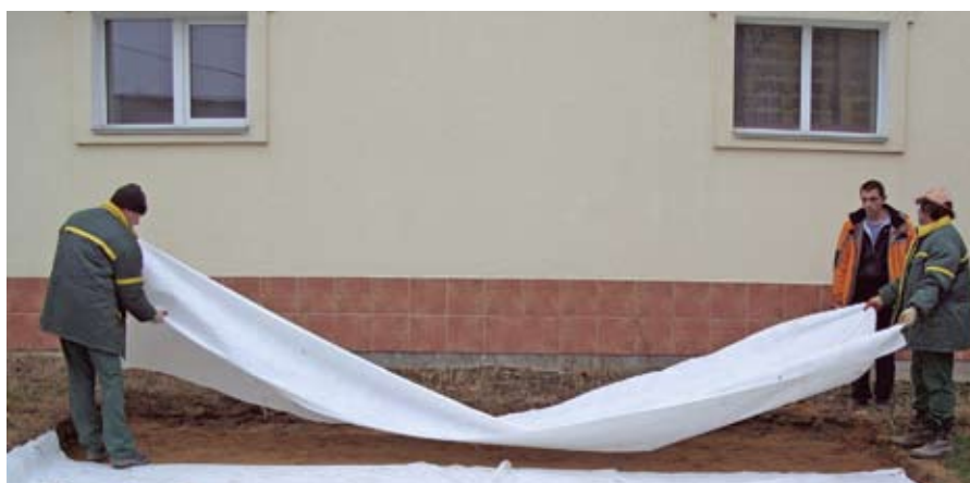
Рис. 3. Укладка иглопробивного полотна на выровненный слой песка
