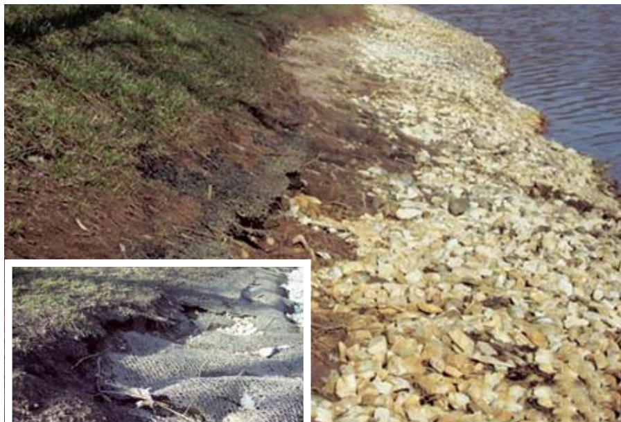
Рис. 5. Закрепление берега каменной наброской с применением противозерозионного мата
