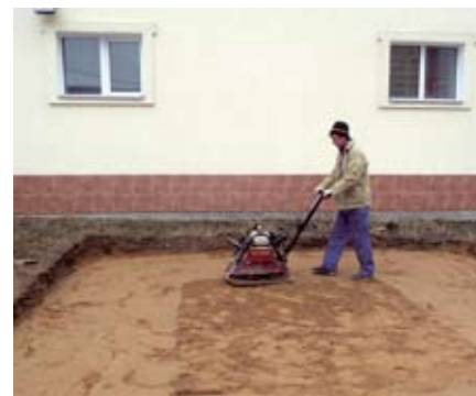
Рис. 2. Засыпка слоем песка территории для обустройства автостоянки и его выравнивание
