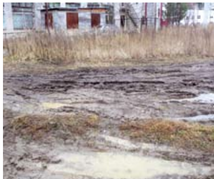
Рис. 1. Подготовка основы для укладки газонной георешетки
