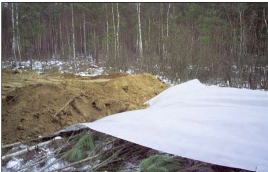
Рис. 3. Строительство опытного участка в Осиповичском лесхозе
