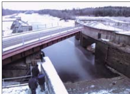
Наводка моста осуществляется поворотом пролетного строения на 90°
