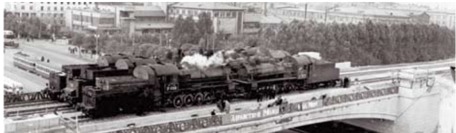
Рис. 4. Испытание путепровода
