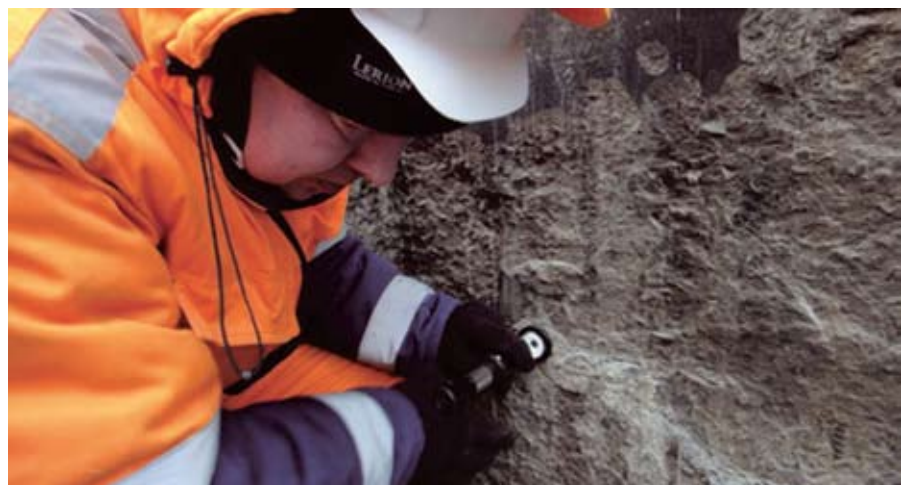
Рис.2. Измерения прочности бетона конструкций и характеристик трещин
