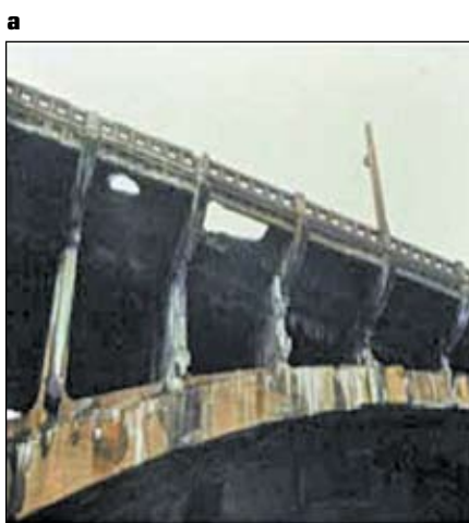
Рис. 10. Коррозия тротуарных блоков железобетонного арочного моста: а — вид снизу; б — вид с моста
