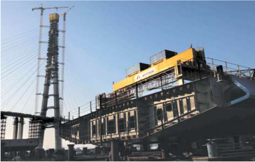
Панель металлической балки жесткости на стапеле
