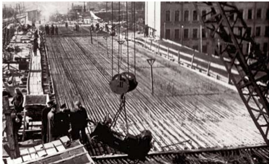
Рис. 3. Преднапряжение плиты
