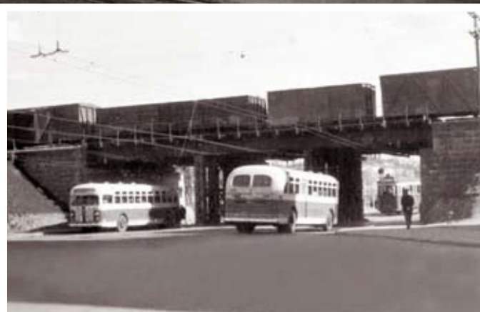
Рис. 1. Общий вид путепровода после реконструкции и до начала работ
