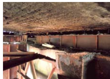
Рис.1. Характерные повреждения бетонных поверхностей пролетного строения
