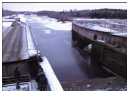
Наводка моста осуществляется поворотом пролетного строения на 90°
