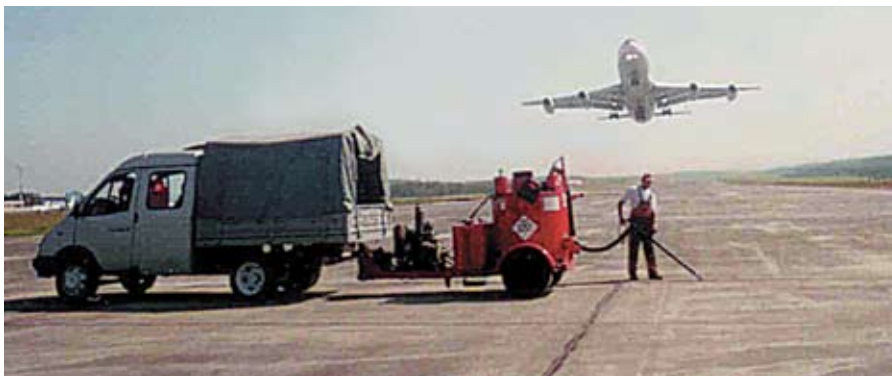
Рис. 4. Выполнение работ по герметизации швов на действующей ВПП аэропорта Красноярск, 2004 год
