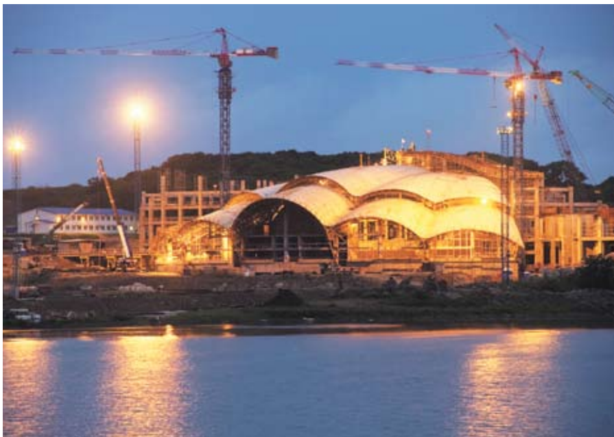
Строящийся научно-образовательный комплекс «Приморский океанариум» на острове Русском во Владивостоке
