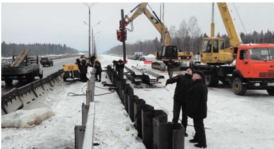
Строительство обхода Одинцово
