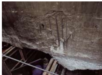
Рис.1. Характерные повреждения бетонных поверхностей пролетного строения
