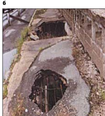
Рис. 10. Коррозия тротуарных блоков железобетонного арочного моста: а — вид снизу; б — вид с моста
