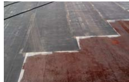
Рис. 2. Выполнение гидроизоляционных работ по ржавчине
