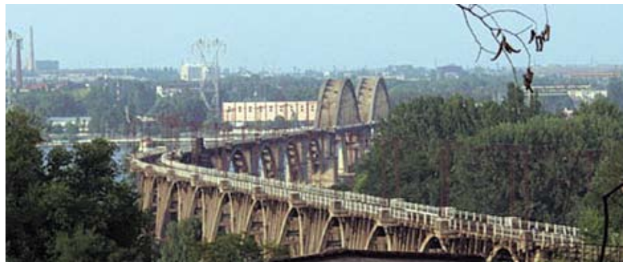
Правобережная криволинейная в плане часть моста
