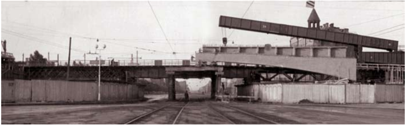
Рис. 2. Монтаж блоков пролетного строения
