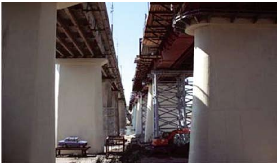
Использование системы АРМОКОТ С101 для железобетонных опор на мосту через р. Ока в Алексине Тульской области
