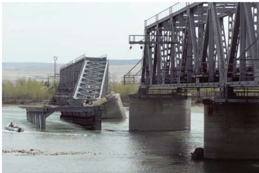
Рис. 7. Железнодорожный мост через реку Абакан (май 2011 г.)
