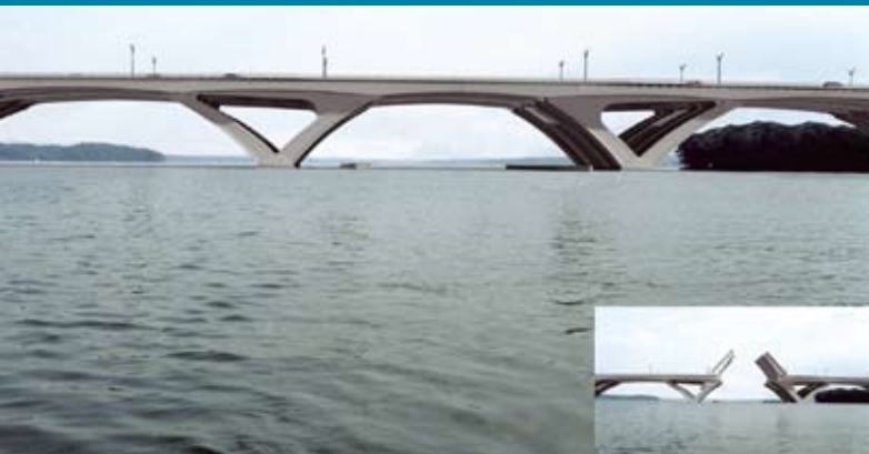
Мост Вудро Вильсона, Вирджиния — Вашингтон — Мэриленд (США)
