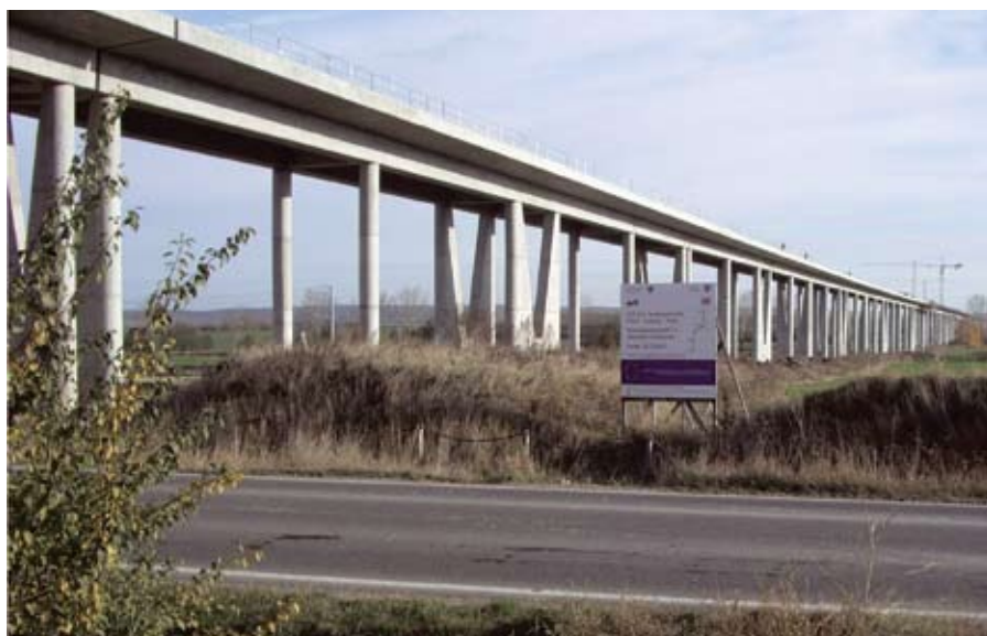
Рис. 6. Пример моста с неразрезным пролетным строением и чередующимися большими и малыми пролетами
