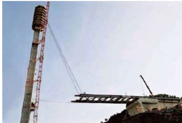
Рис. 1.9. Надвигка стального пролетного строения от восточного берега
