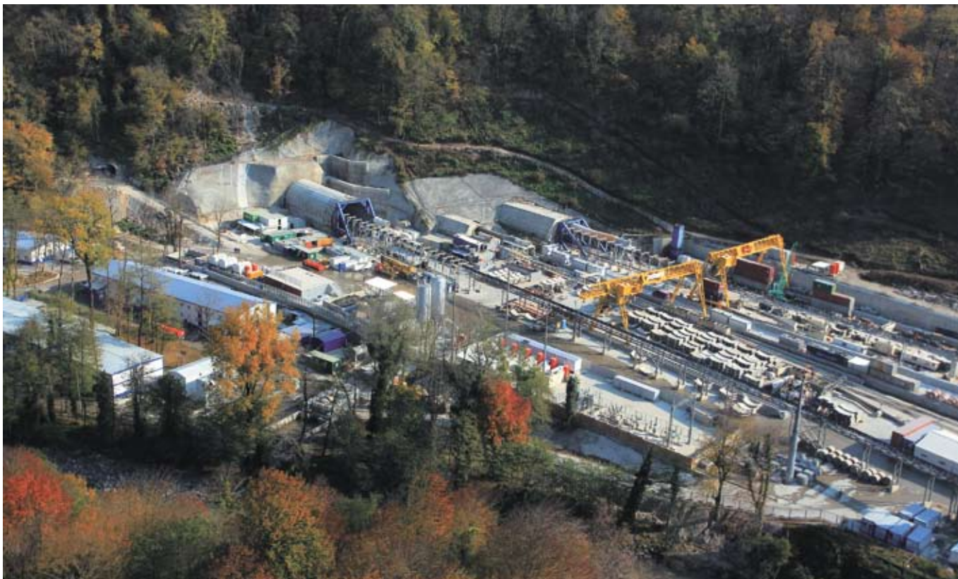
На строительстве третьего тоннельного комплекса
