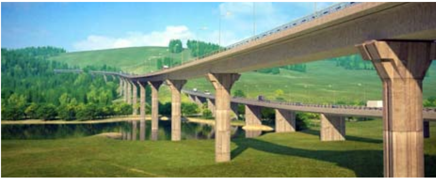
Мостовой переход на автомобильной дороге Пермь — Березники
