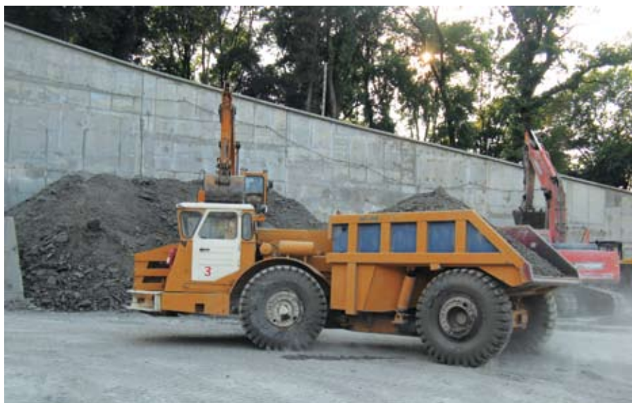
На строительстве тоннелей №5 и 5а
