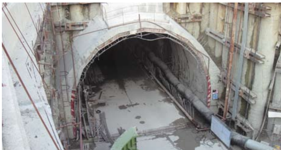
Тоннель №8. Дополнительная штольня
