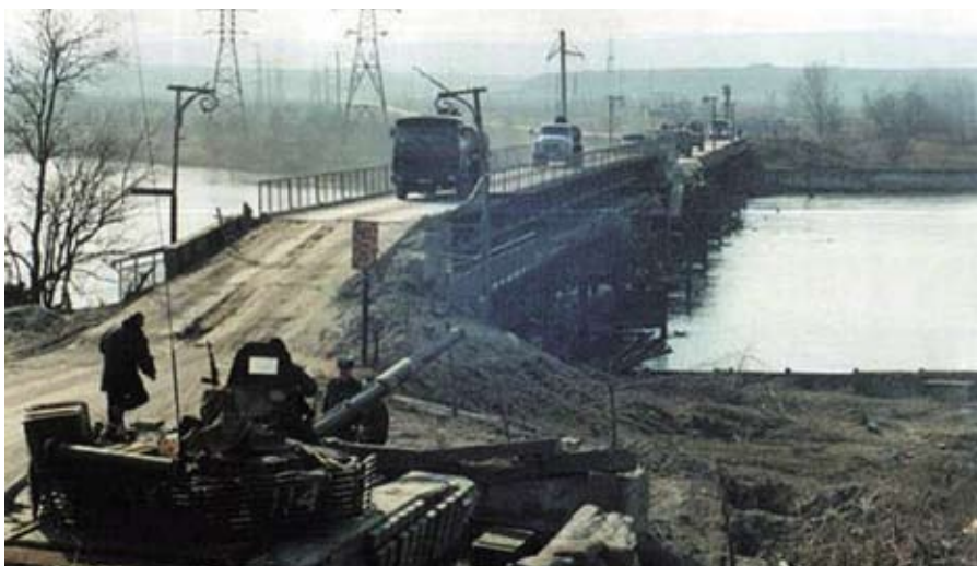
Мост через реку Терек в районе ст. Червлённой
