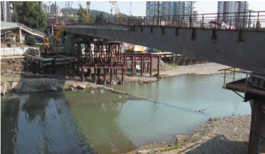
Строительство моста через реку Сочи
