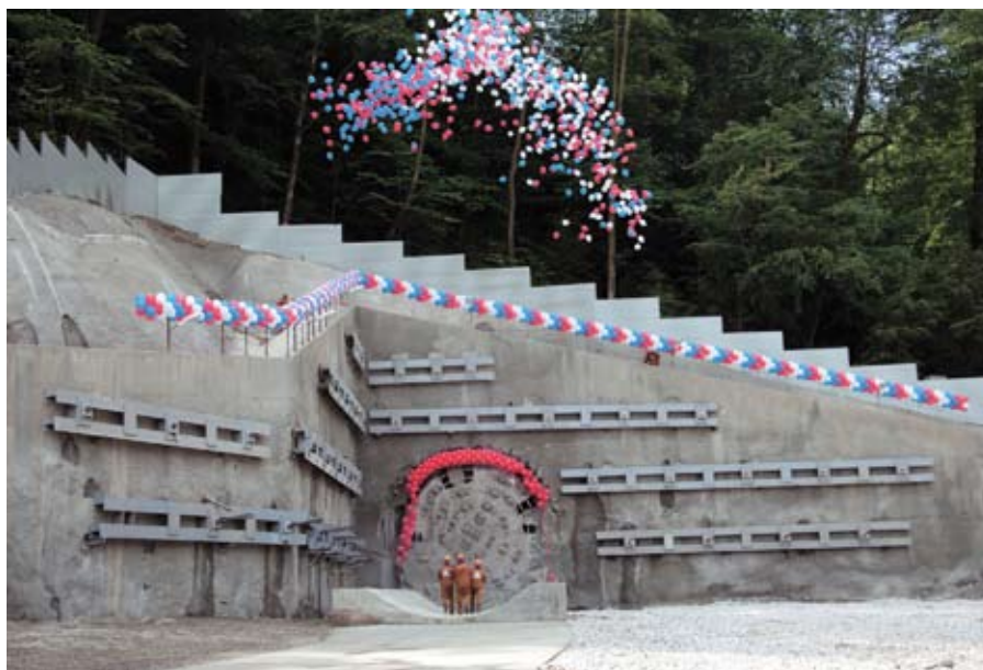
Первый тоннельный комплекс пройден
