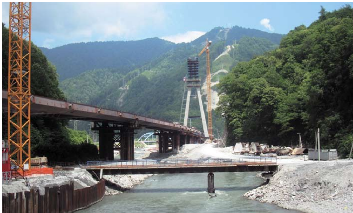
Вантовый автодорожный мост через Мзымту
