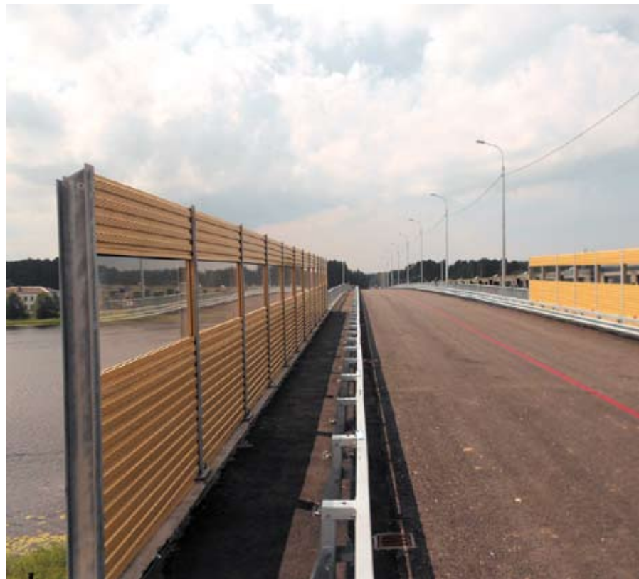
Мост через реку Паша на км 175+606 автомобильной дороги М-18 «Кола»
