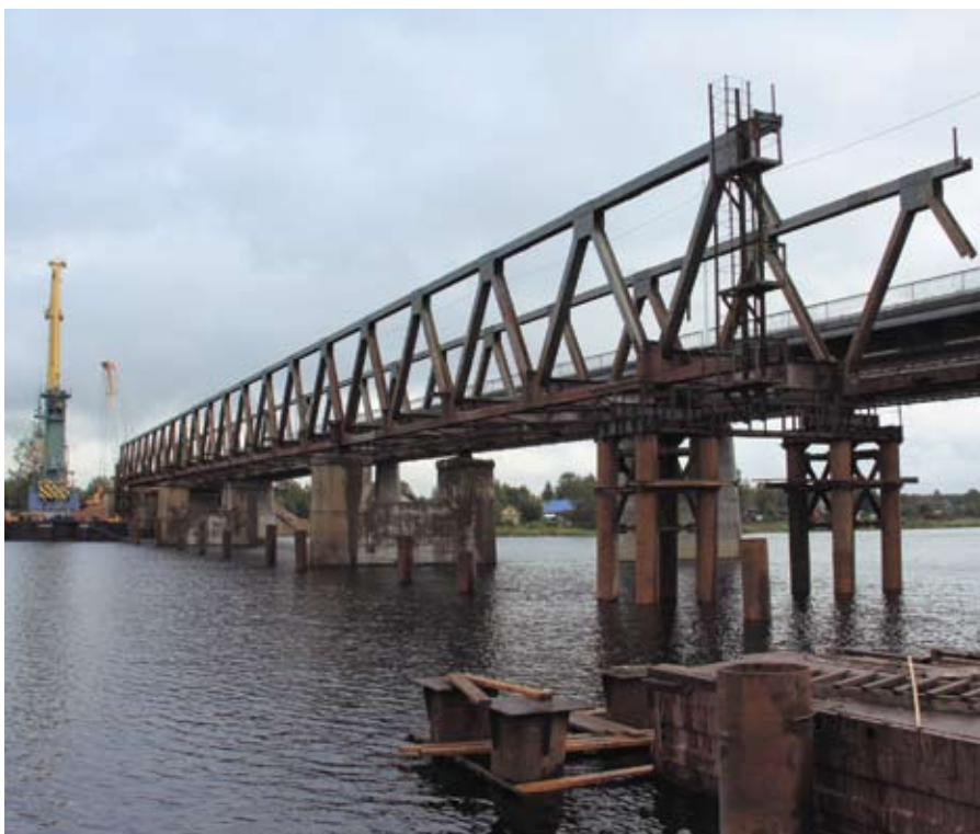
Разборка старого моста через реку Паша
