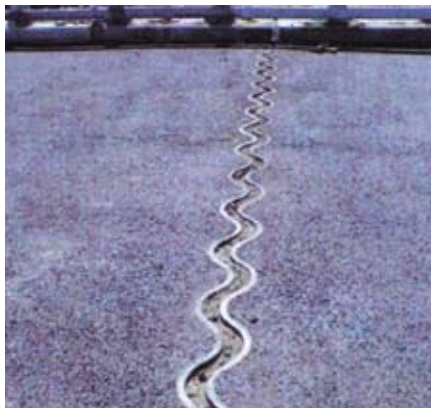
Рис. 10. Волнообразный деформационный шов Maurer типа XW1: а — примыкание покрытия в одном уровне с кромкой шва; б — усиление покрытия за счет армирования волнообразной формой примыкания покрытия ко шву
