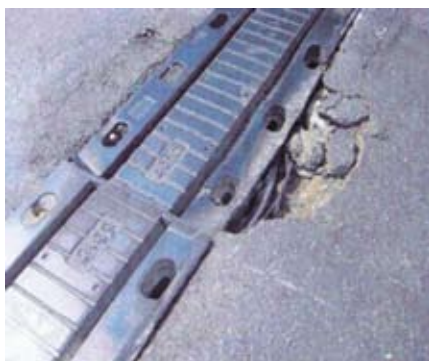
Рис. 4. Швы типа Transflex
