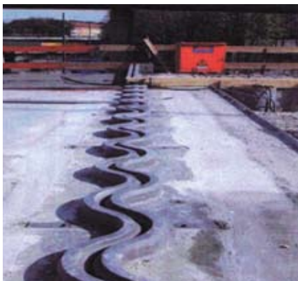
Рис. 10. Волнообразный деформационный шов Maurer типа XW1: а — примыкание покрытия в одном уровне с кромкой шва; б — усиление покрытия за счет армирования волнообразной формой примыкания покрытия ко шву
