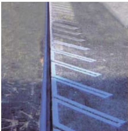
Рис. 9. Армирование асфальта ребрами из полимербетона
