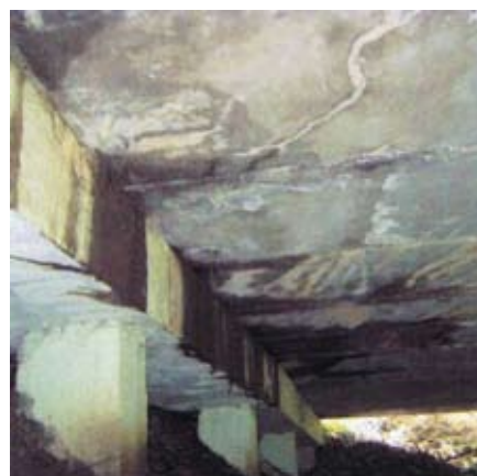
Рис. 2. «Герметичные» гребенчатые швы с водоотводным лотком «в действии»
