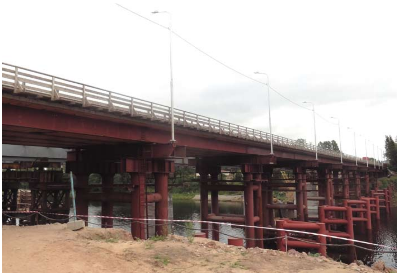
Капитальный ремонт моста через реку Сясь на км 515+372 автомобильной дороги А-114 Вологда – Новая Ладога до магистрали «Кола». Объездной мост
