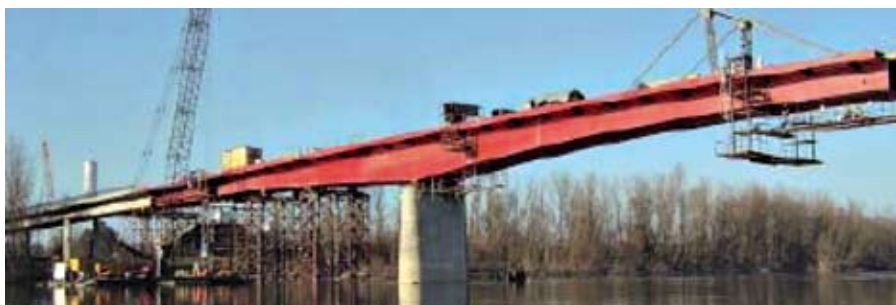
Рис. 3.5. Навесной монтаж консоли нового стального пролетного строения
