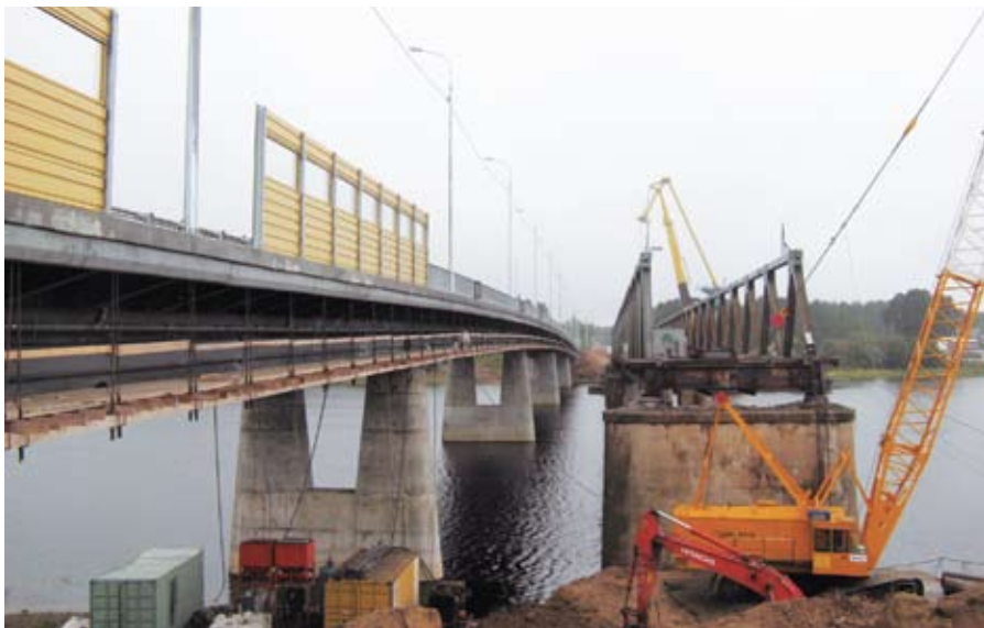
Старый и новый мост через реку Паша
