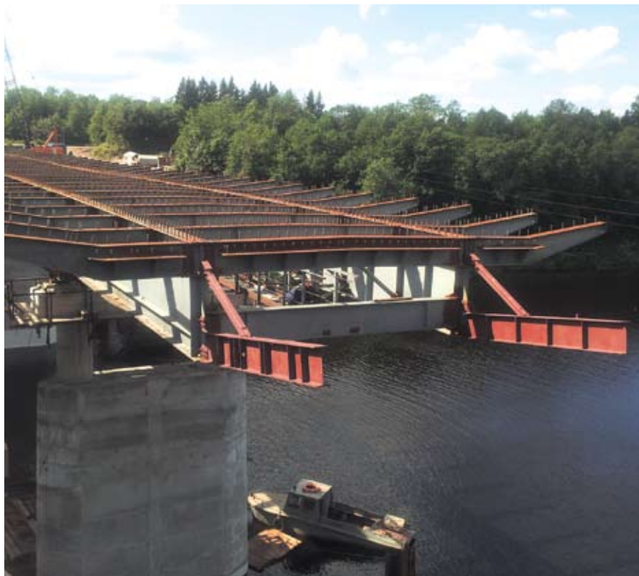
Капитальный ремонт моста через реку Сясь на км 515+372 автомобильной дороги А-114 Вологда – Новая Ладога до магистрали «Кола»
