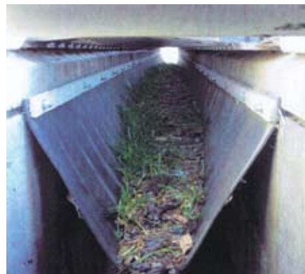
Рис. 1. Модульная конструкция деформационных швов со стальными несущими и резиновыми герметизирующими элементами
