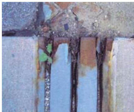
Рис. 6. Узел деформационного шва в зоне бордюров: а — интенсивная коррозия в месте перелома профиля шва; б — профиль в зоне бордюров, сформированный гнутьем
