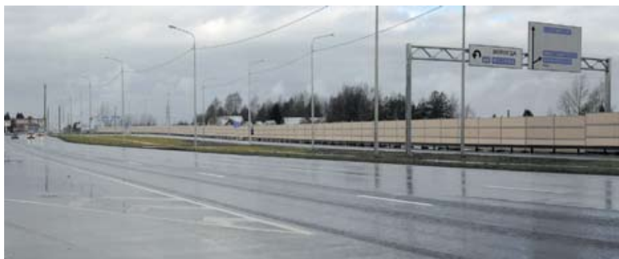
На участке км 4+320 — км 6+486 автомобильной дороги А-114 Вологда — Новая Ладога
