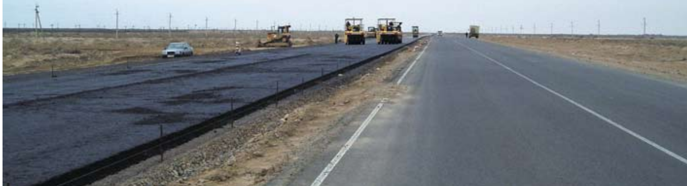
Рис. 1. Строительство автомагистрали Западная Европа — Западный Китай в Кызылординской области
