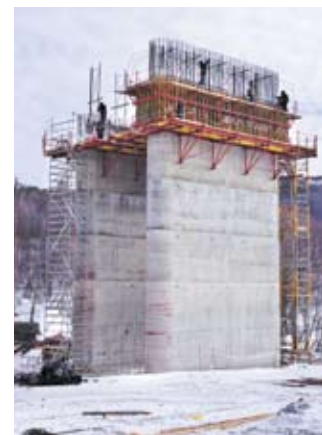
Консольно-переставные подмости (мост-эстакада через реку Чаченка)
