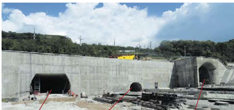
Автодорожный тоннель L=2296,0 м
