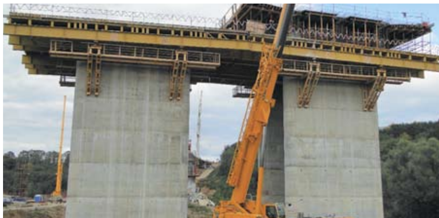
СВСиУ (мост-эстакада через реку Чаченка)
