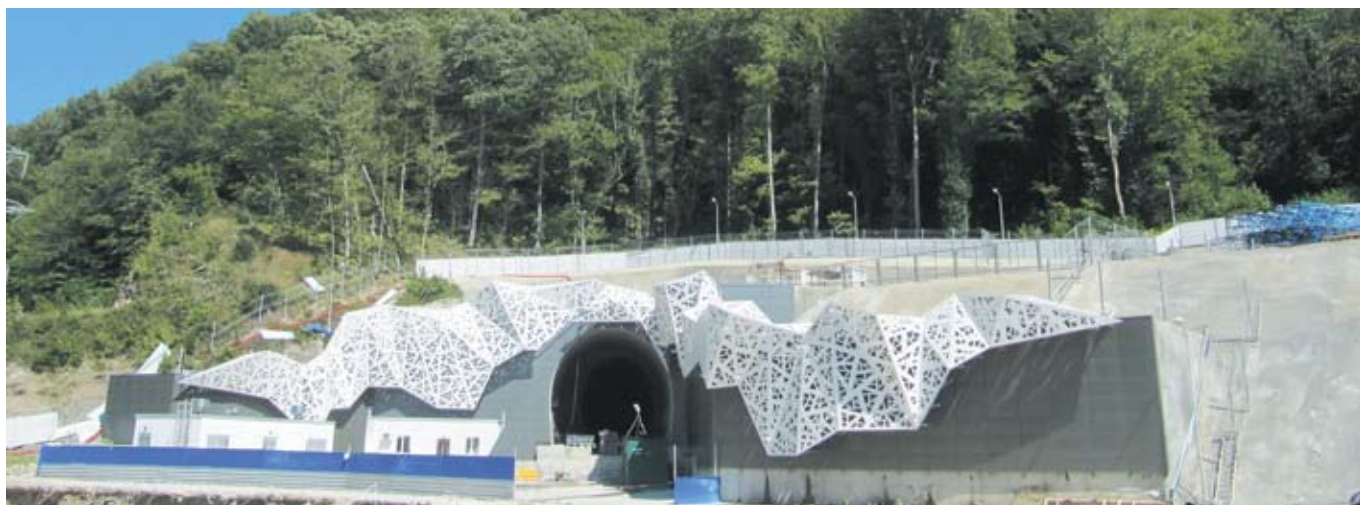
Рис. 4. Портал и конструкция обделки ж/д тоннеля № 4
