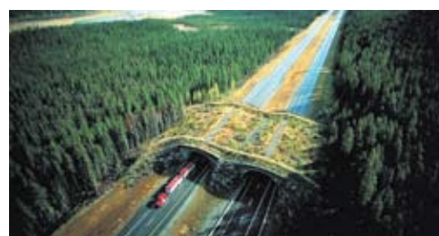
Рис. 3. Зверопереход над дорожным полотном
