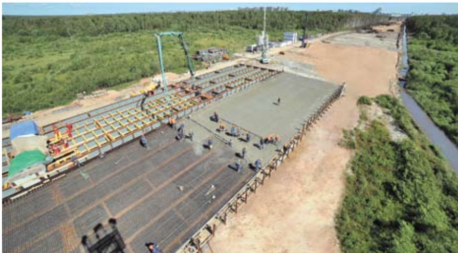
Строительство северного участка ЗСД
