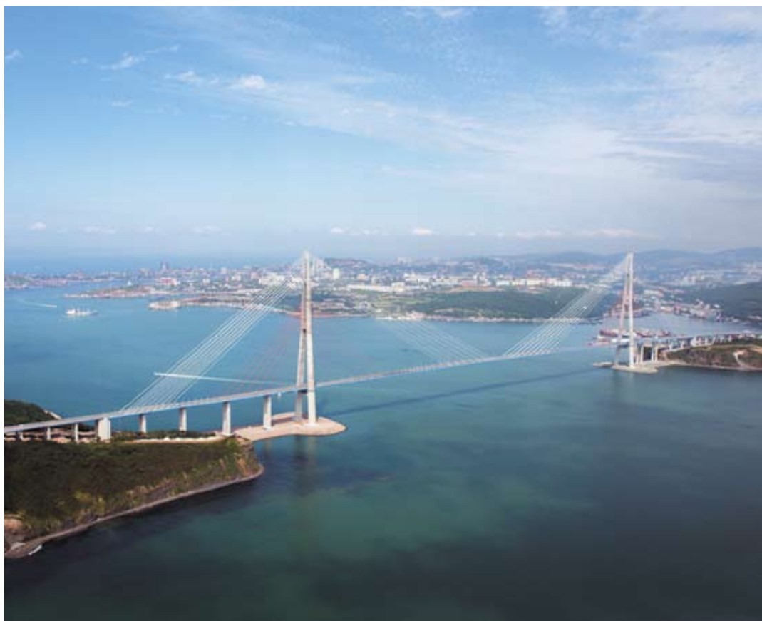
Мостовой переход на остров Русский во Владивостоке
