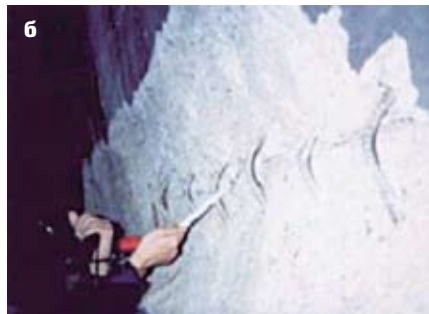
Рис. 5. Продольные (а) и поперечные (б) трещины в обделке, возникшие в результате воздействия землетрясения
