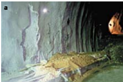
Рис. 5. Продольные (а) и поперечные (б) трещины в обделке, возникшие в результате воздействия землетрясения
