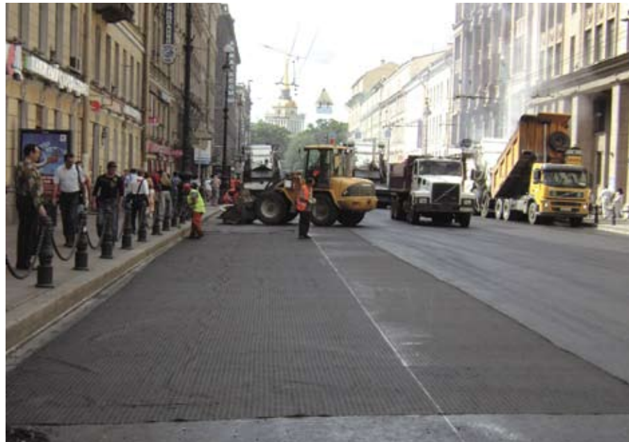
Укладка асфальтобетонного покрытия, армированного геосеткой Хателит, на Невском проспекте
