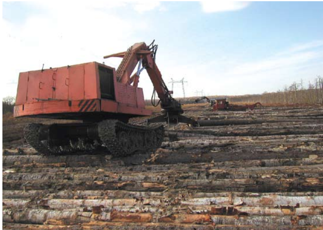
Рис. 2. Устройство лежневых настилов
