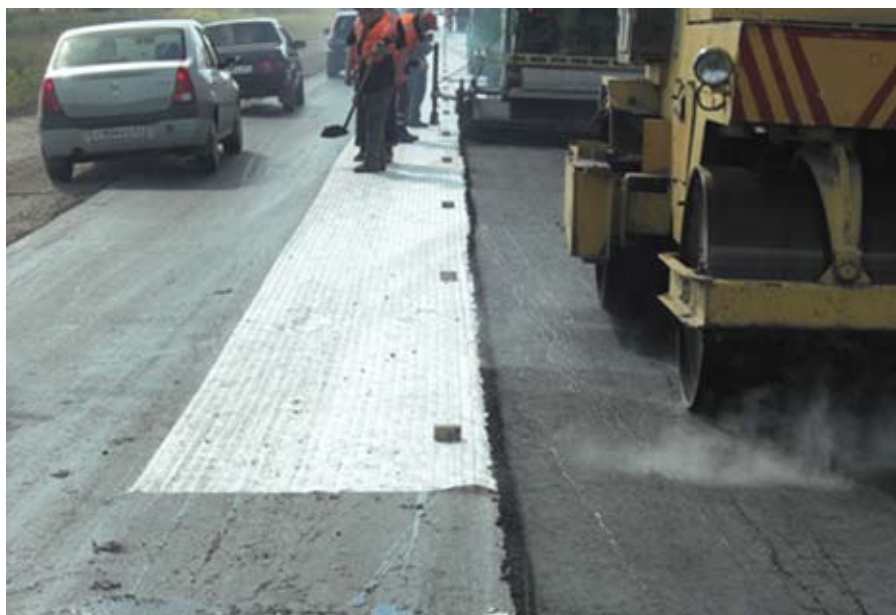
Устройство верхнего слоя асфальтобетонного покрытия с армирующей георешеткой
