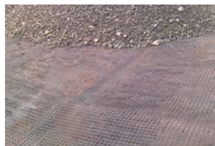
Рис. 2. Усиление слоя основания из щебеночной смеси двухосной георешеткой TGS 40-40 на автомобильной дороге Лидога — Ванино
