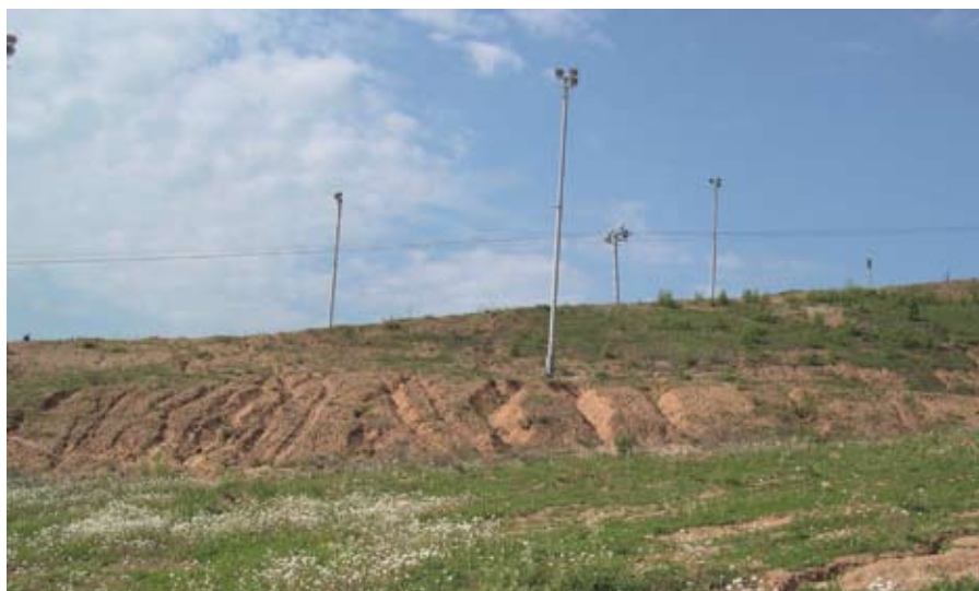
Рис. 1. Эрозионные процессы на откосах
