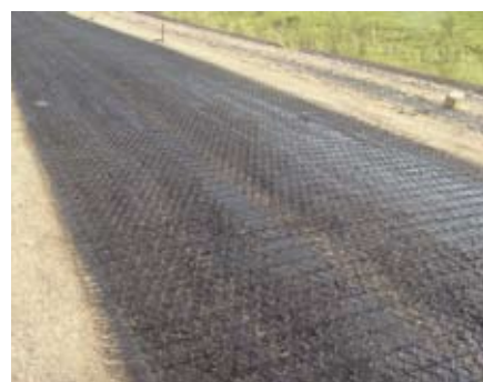
Рис. 2. Металлическая сетка «Родмеш», уложенная на щебеночное основание, перед устройством асфальтобетонного покрытия
