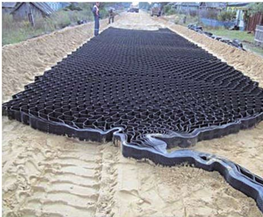
Участок автомобильной дороги Старочернеево — Парсаты — Сявель
