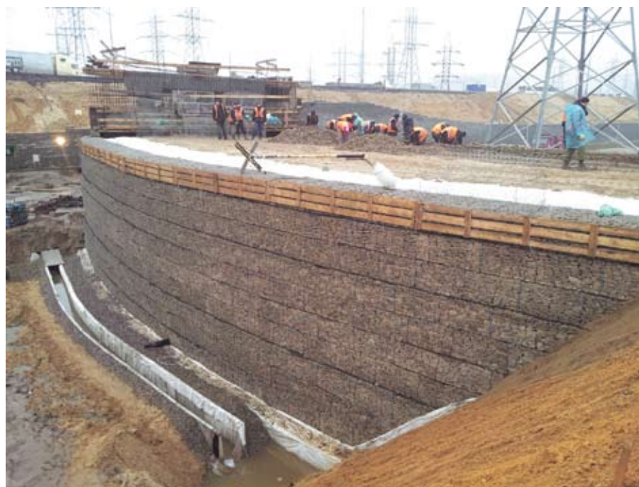
Рис. 3. Устройство облицовки из коробов габиона
