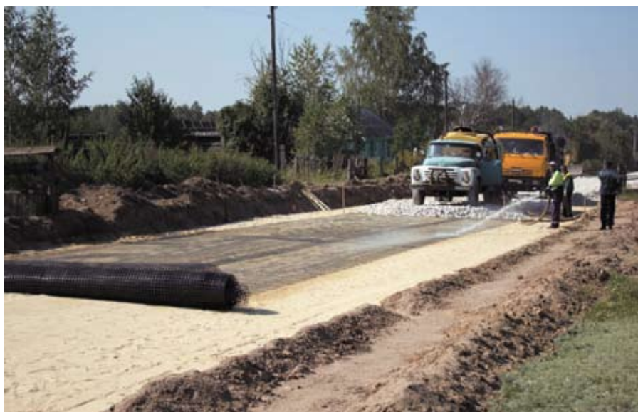
Укладка георешетки для армирования нижних слоев основания автомобильной дороги
