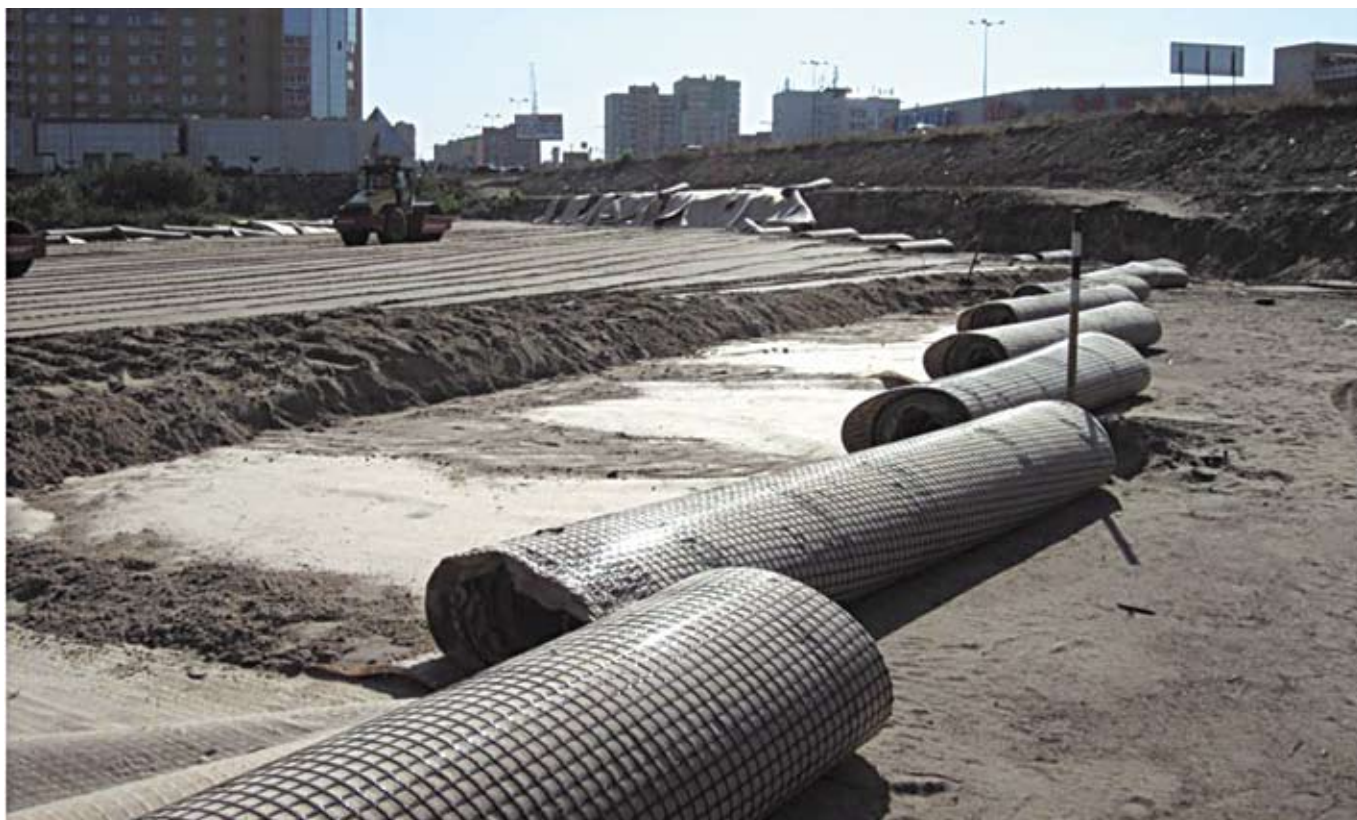
Усиление основания насыпи при строительстве северного обхода города Рязани
