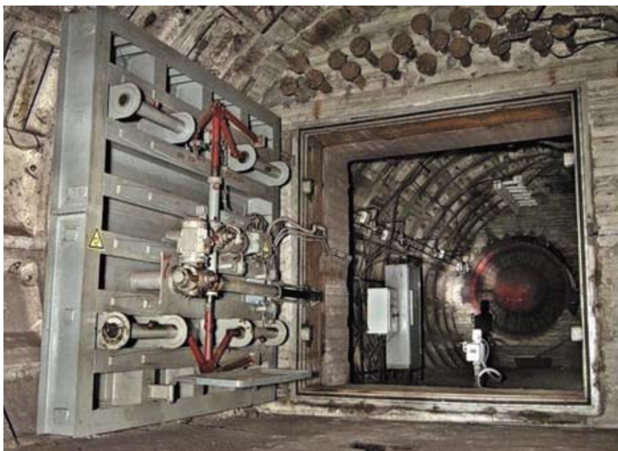
Рис. 2. Аварийный затвор типа ЗТ-П
