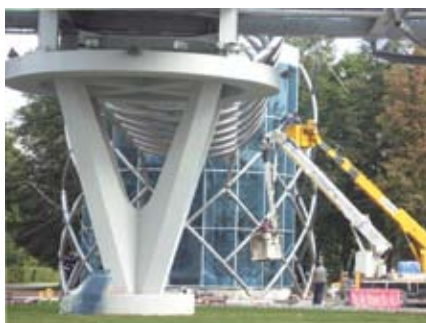
Рис. 6. Монтаж пешеходного перехода в г. Химки Московской области
