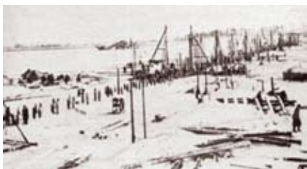
Строительство низководного свайно-ледового моста через Неву у Шлиссельбурга в январе 1943 года
