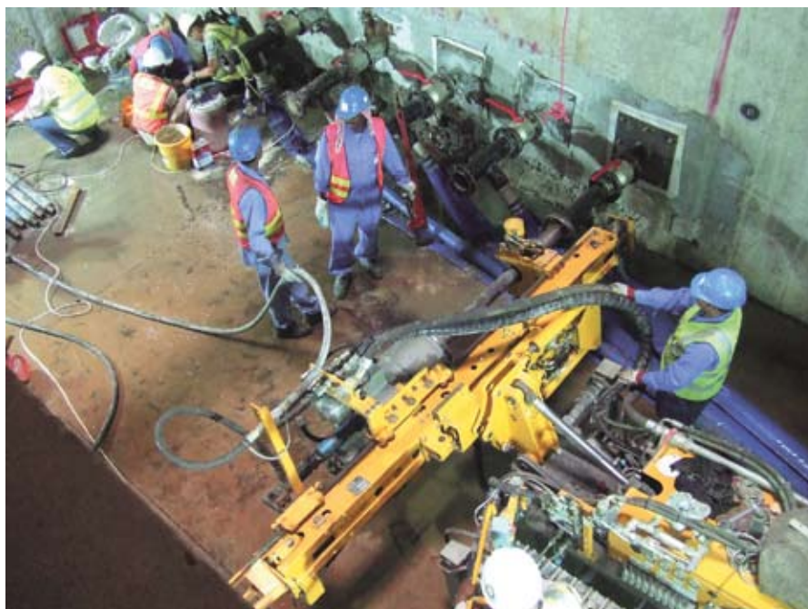
Рис. 8. Бурение горизонтальных скважин через преенторы
