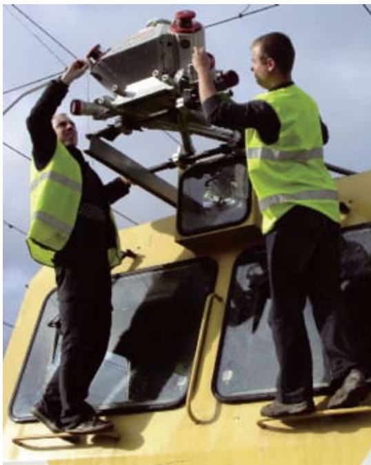
Монтаж Riegl VMX-250 на железнодорожной автомотрисе
