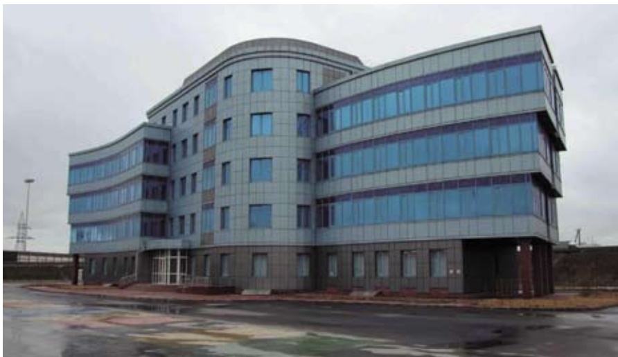
Здание Центрального пункта управления (ЦПУ)
