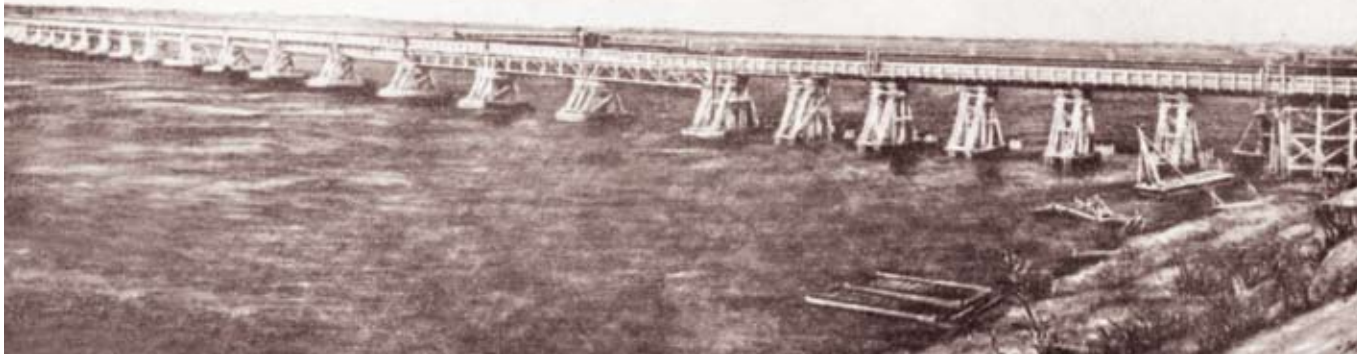
Высоководный мост через Неву у Шлиссельбурга
