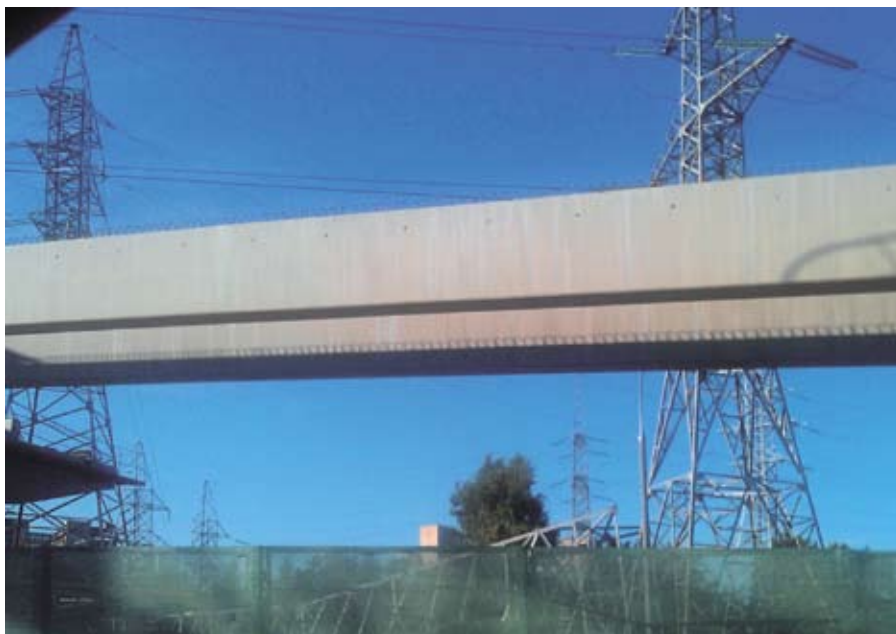
Рис. 1. Балки, установленные на развязке МКАД — Ленинградское шоссе
