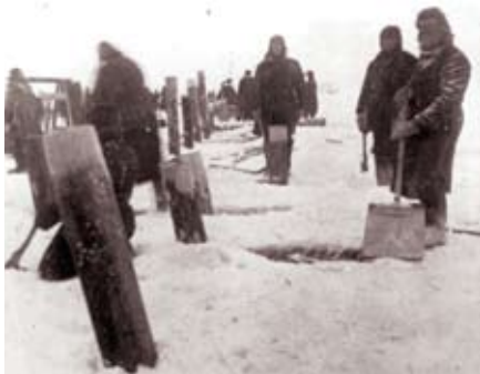
Перекас свай в результате подвижки льда
