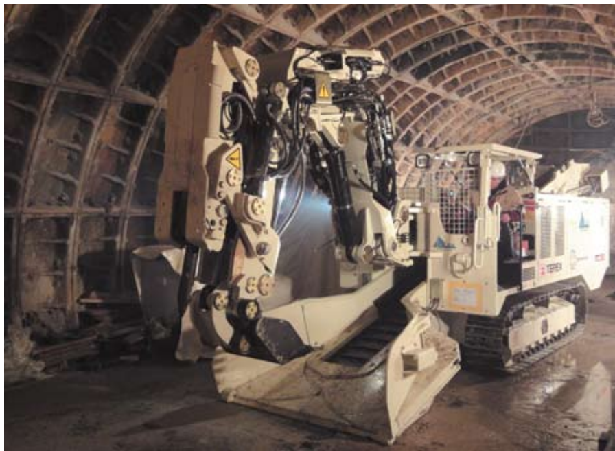
Рис. 2. ИТС-120. Проходка подходных выработок строящейся станции «Бутырская» Люблинско-Дмитровской линии столичного метро
