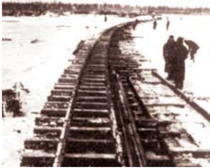
Строительство узкоколейной железной дороги по льду Ладожского озера в декабре 1942 года
