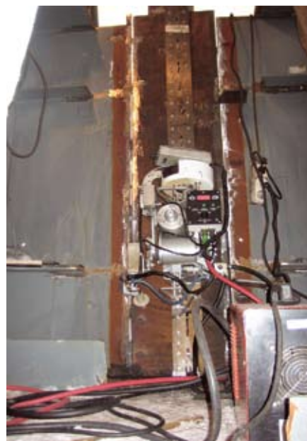
Комплекс вертикальной автоматической сварки «Восход» на пролетном строении
