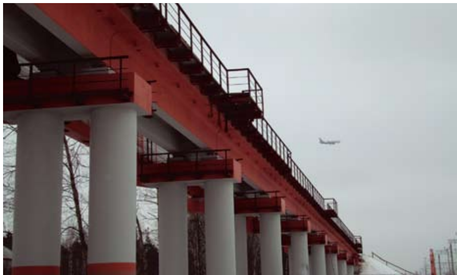
Путепровод на ПК13+52 Шереметьевской ветки
