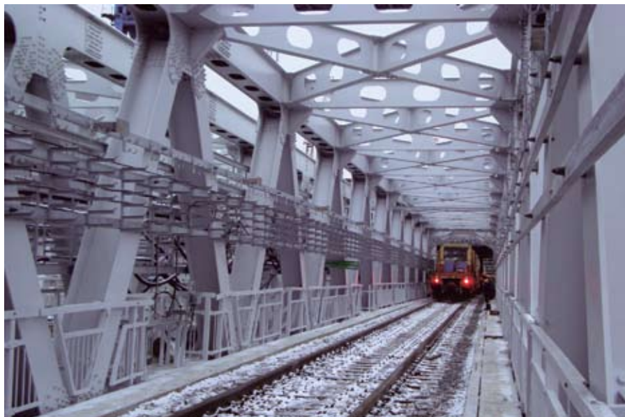
Мост через р. Москва между станциями Мякинино и Волоколамская Арбатско-Покровской линии метрополитена
