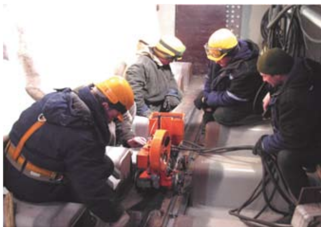
Автоматическая сварка под флюсом монтажных панелей в створе мостового перехода на остров Русский
