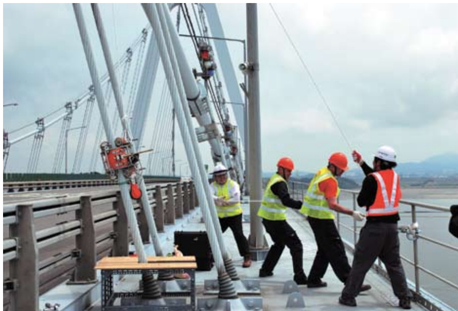
Рис. 2. Контроль вантовых канатов моста Йонджон дефектоскопом «ИНТРОС»
