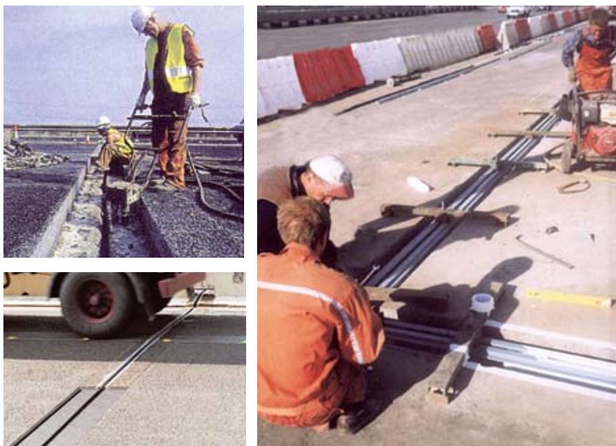
Рис. 3. Технологические этапы устройства деформационных швов
