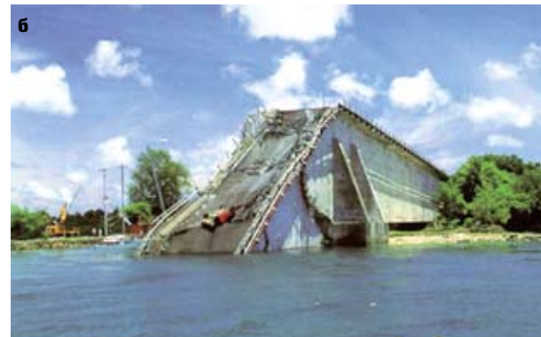
Рис. 2. Мост между островами Корор и Бабелтуап (Республика Палау): до (а) и после (б) разрушения
