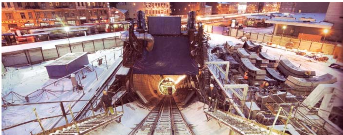
Рис. 5. Проходка наклонного эскалаторного тоннеля на станции «Обводный канал»
