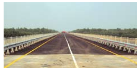
Применение покрытия Matacryl® при строительстве мостового перехода через р. Камчатка, 2012 г.
