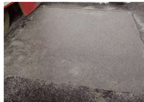
Пробный участок на разводном пролете Володарского моста в Санкт-Петербурге, 2011 г.
