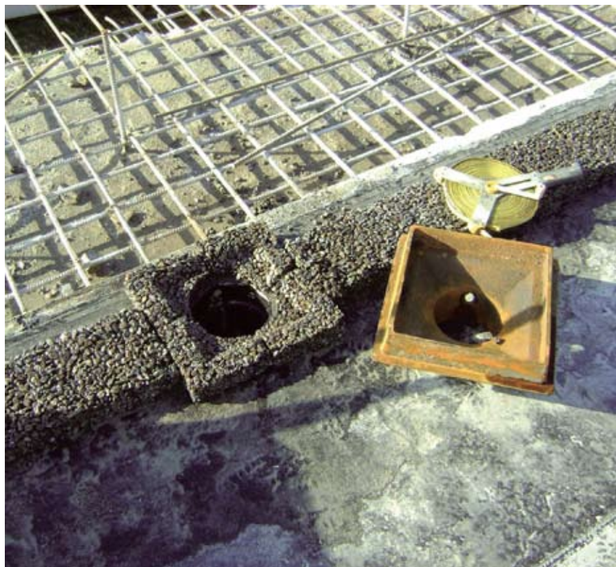
Дренажный канал на мосту
