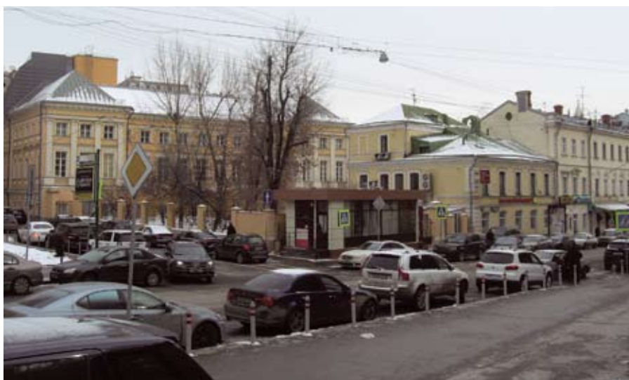
Рис. 4. Площадка для строительства эскалаторного тоннеля к станции «Консерватория»
