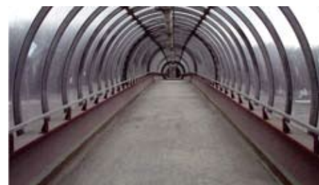
Применение Системы Matacryl® на пешеходном мосту, г. Тверь, 2003 г.
