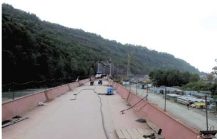
Цельносварное балластное корыто балочного ж/д пролетного строения, г. Адлер
