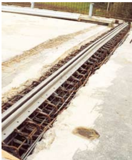
Примыкание дорожной одежды к конструкции деформационного шва: слева — зарубежная конструкция; справа — конструкция СК-80 ООО «НПП СК МОСТ»
