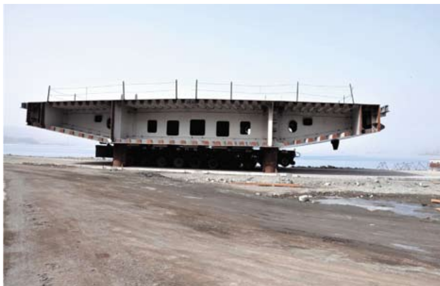
Перемещение панелей мостового перехода на остров Русский
