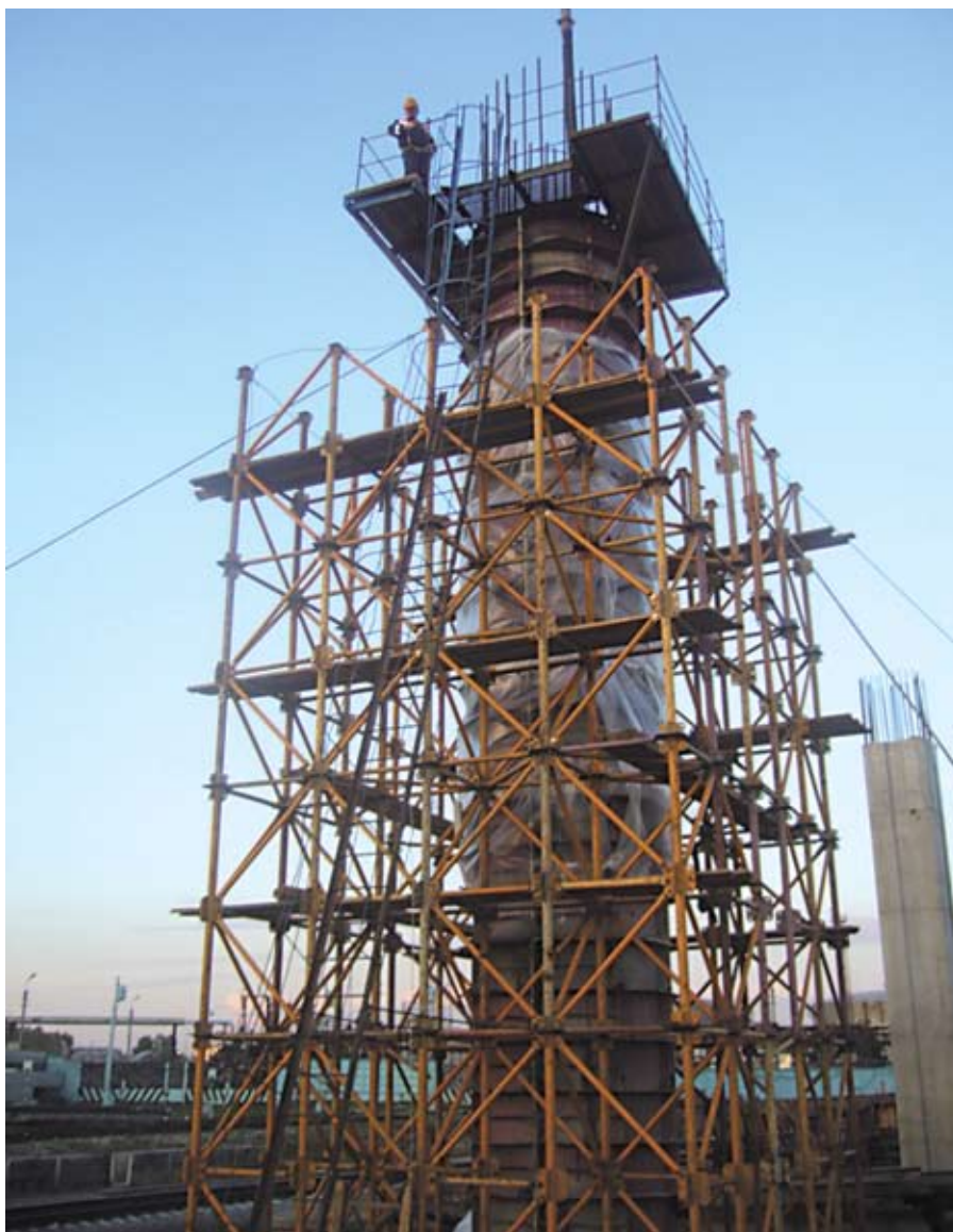
Рис. 4. Опора из самоуплотняющегося бетона, возведенная СТФ «Мостоотряд-99» в Москве
