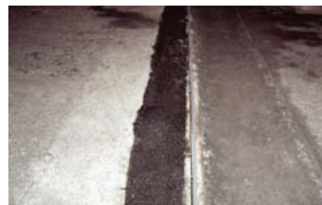
Переходная зона между традиционным дорожным полотном и деформационным швом. Проект «Защита ДШ, КАД, Санкт-Петербург», 2011 г.
