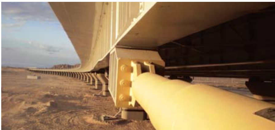
Рис. 2. Система сейсмобезопасности на путепроводе в Туркменистане
