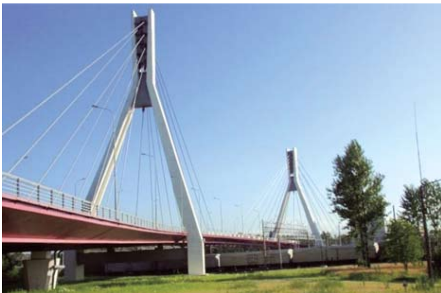
Рис. 3. Путепровод через железнодорожные пути в створе пр. Александровской Фермы
