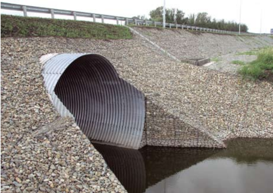
Водопропускная металлическая гофрированная труба на участке реконструкции
