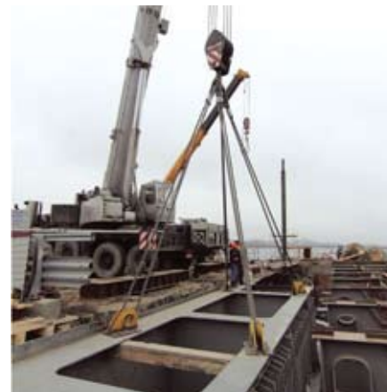
Монтаж блоков новых противовесов разводного пролетного строения
