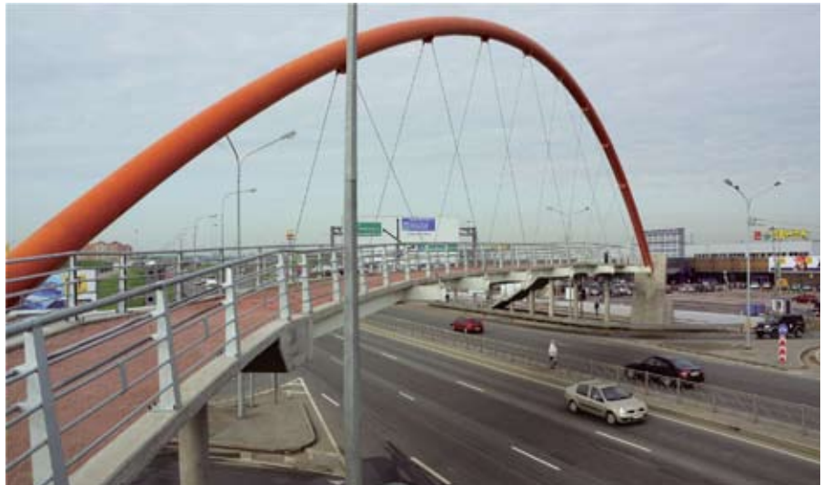
Рис. 1. Общий вид надземного пешеходного перехода через Таллинское шоссе
