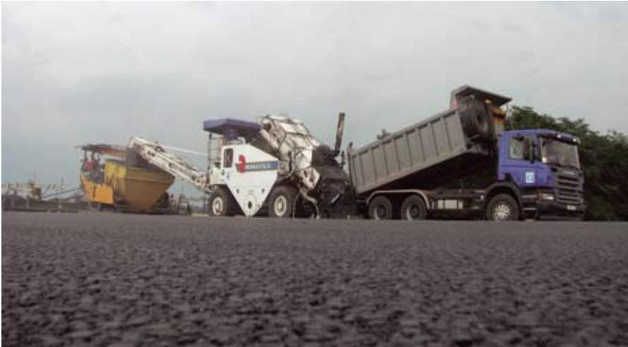
Устройство асфальтобетонного покрытия
