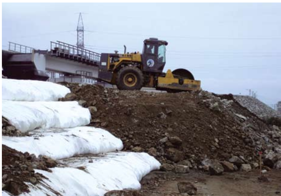
Рис. 1. Укладка слоев геотекстиля в нижней части насыпи
