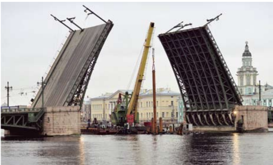
Сооружение временной опоры разводного пролета
