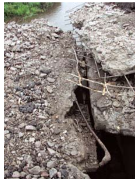
Рис. 7. Обрушение пролетного строения моста в Боровичах
