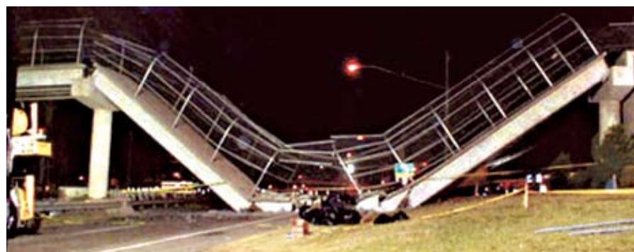
Рис. 8. Обрушение пешеходного моста в Шарлотте (США)
