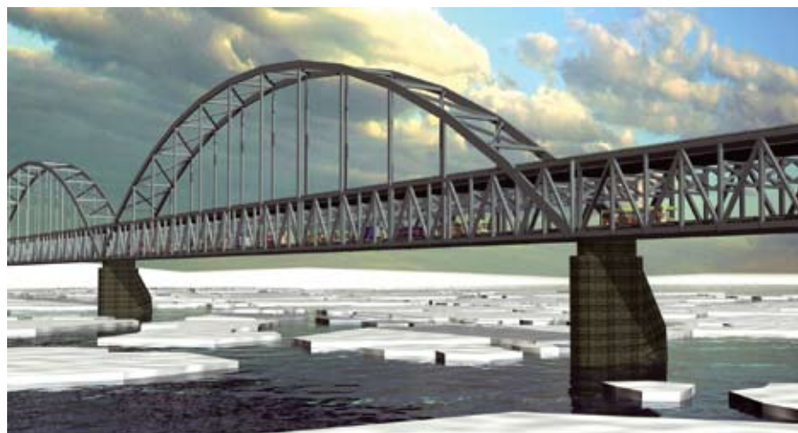
Вариант мостового перехода через реку Лену с перспективой железнодорожного движения. Длина моста 3147,2 м, 18 пролетов с ездой автотранспорта в двух направлениях. Схема моста: 33,6+2×154+4×308+10×154+33,6 м
