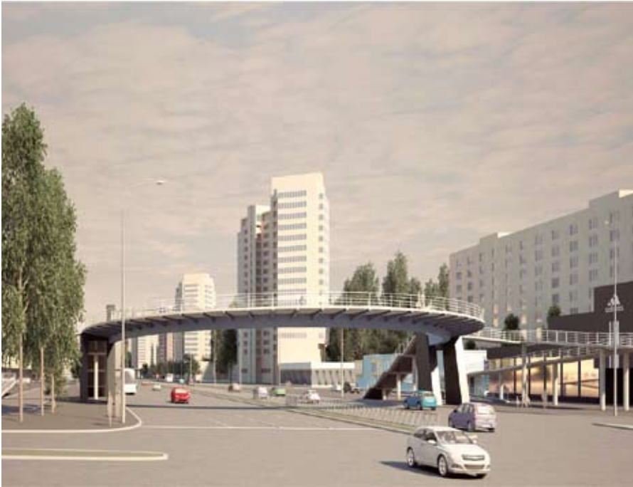
Рис. 5. Общий вид надземного пешеходного перехода на пересечении проспекта Славы с Белградской улицей
