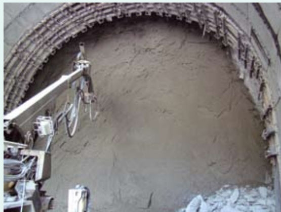
Лоб забоя на 86-м километре. Фибронабрызгбетон
