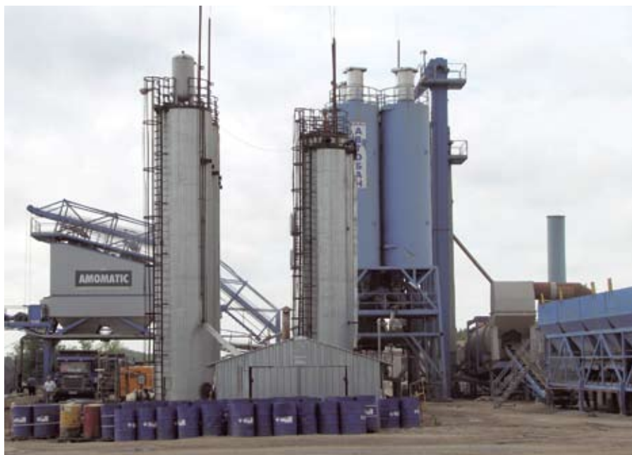
Асфальтобетонные смесительные установки на участке реконструкции
