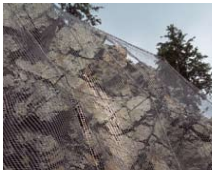
Рис. 11. Конструкции для защиты полотна автодороги от выпадения продуктов скальной эрозии
