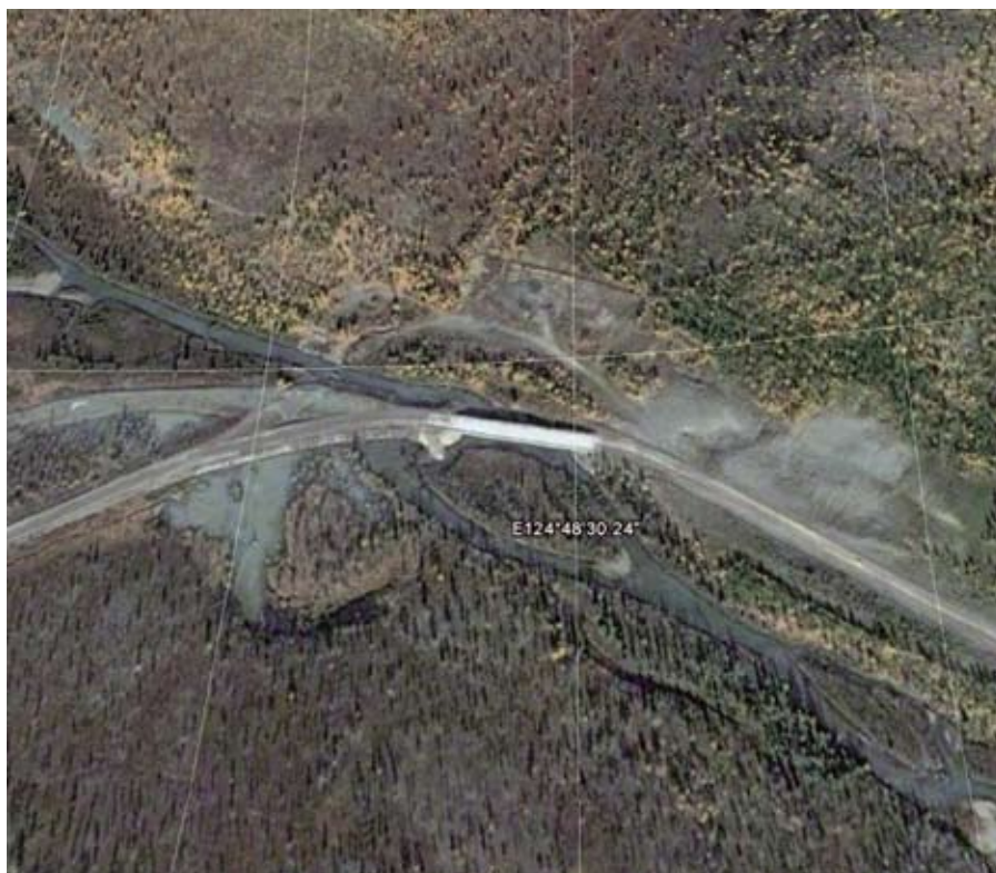
Рис. 1. Общий план оползневого участка трассы автодороги
