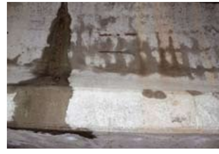
Рис. 6. Следы протечек, обнажения и коррозии арматуры балки пролетного строения
