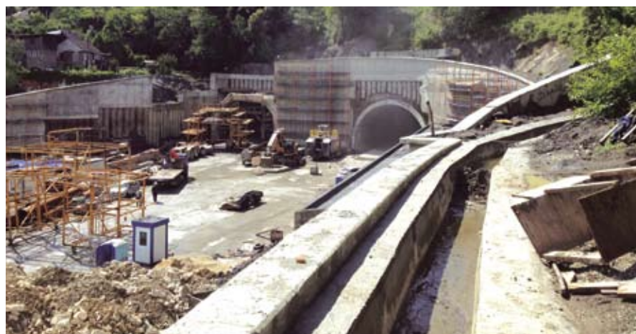
Южный портал тоннелей №5 и 5а (Сочи)
