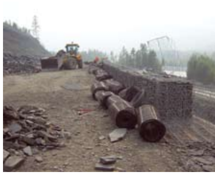
Рис. 10. Армобрунтовые конструкции земляного полотна
