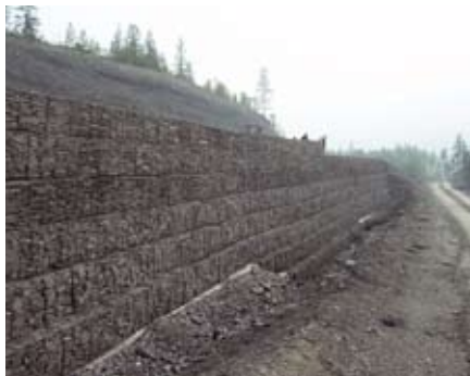
Рис. 10. Армобрунтовые конструкции земляного полотна
