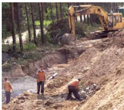
Рис. 8. Разработка котлована для устройства облицовочной стены из габионов
