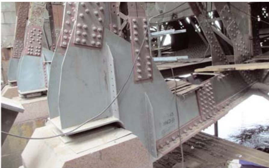
Новые опорные узлы
