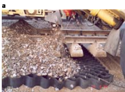
Рис. 11. Объемные геоячейки «Прудон-494»: а — в подбалластном слое; б — в конструкции подпорной стены
