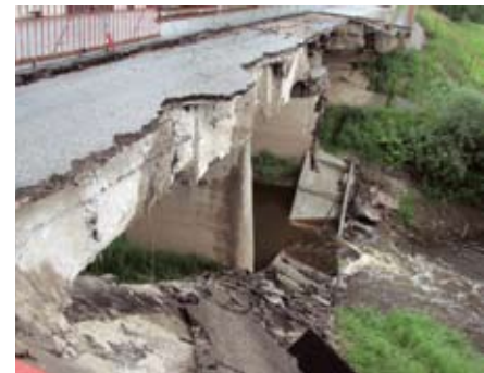
Рис. 6. Следы протечек, обнажения и коррозии арматуры балки пролетного строения
