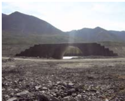
Рис. 9. Армобрунтовые конструкции водопропускных сооружений
