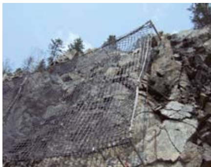
Рис. 11. Конструкции для защиты полотна автодороги от выпадения продуктов скальной эрозии
