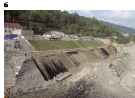
Рис. 11. Объемные геоячейки «Прудон-494»: а — в подбалластном слое; б — в конструкции подпорной стены
