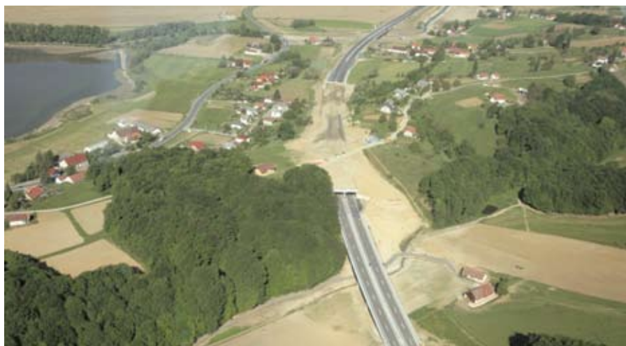
Тоннель в районе поселка Мочна
