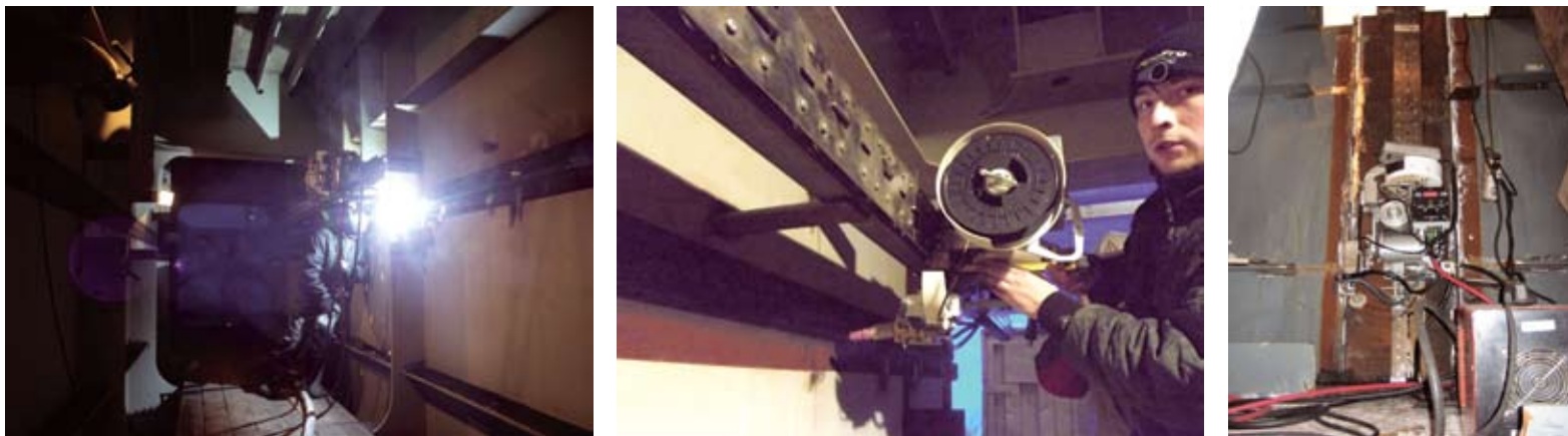
Рис. 1. Автоматическая сварка порошковыми проволоками горизонтального и вертикального швов на мосту через Енисей
