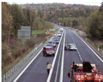
Рис. 9. Устройство центральных тросовых ограждений на автомобильной дороге 2+1
