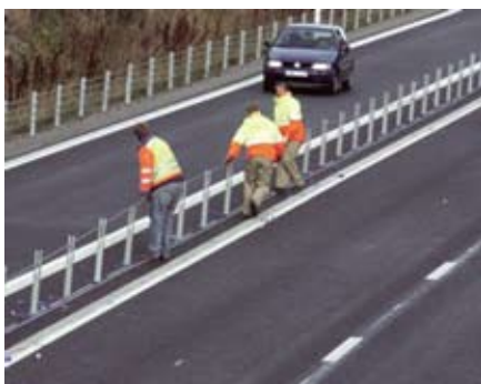
Рис. 9. Устройство центральных тросовых ограждений на автомобильной дороге 2+1
