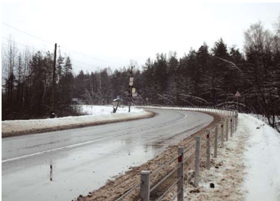
Рис. 2. Боковое тросовое ограждение на поворотном участке автомобильной дороги Раменское — Донино
