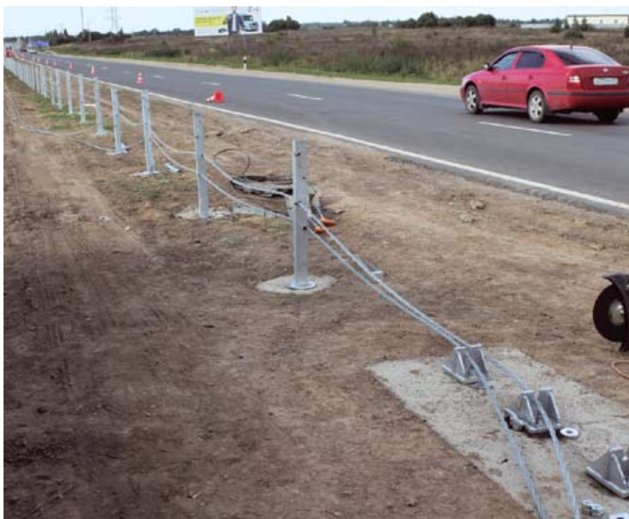
Рис. 4. Процесс установки тросовых ограждений на участке дороги М-1
