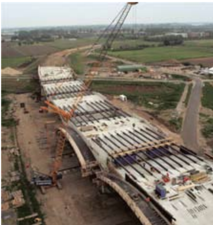
Предварительно напряженные стяжки между гребнями
