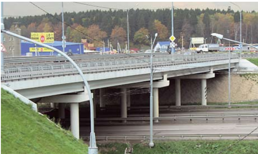
Рис. 6. Путепровод на Калужском шоссе у торгового центра «ИКЕА»
