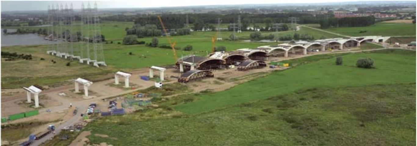
Ход строительства: стойки опор, V-образный ригель и кружала
