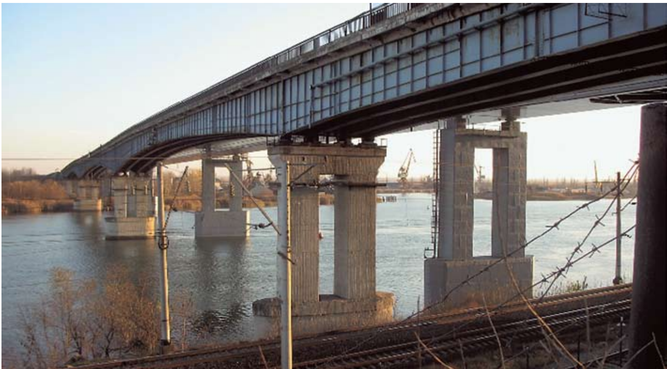
Рис. 5. Аксайский мост через р. Дон
