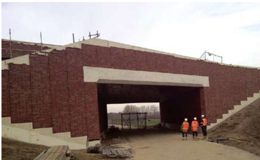
Кирпичная кладка на Восточной дамбе
