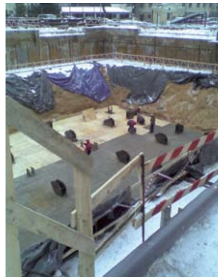
Рис. 3. Разработка котлована перед монтажом распорной системы
