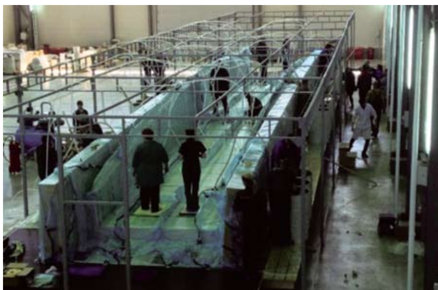
Рис. 3. Изготовление цельнокомпозитного пролетного строения методом вакуумной инфузии в ОАО «Тверьстеклопластик» (ГК «Рускомполит»)
