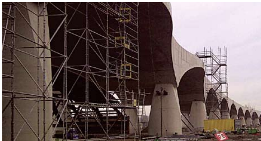
Северная подходная эстакада в процессе строительства
