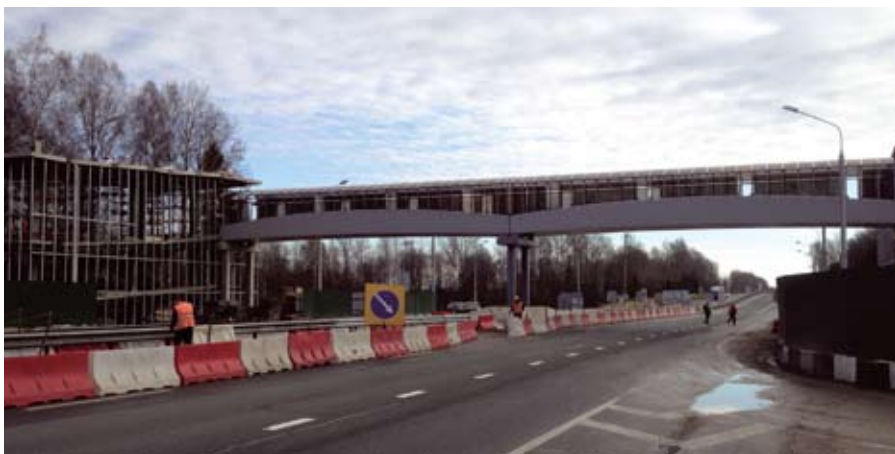
Рис. 13. Пешеходный мост с цельнокомпозитными пролетными строениями на трассе М-1 в Смоленской области
