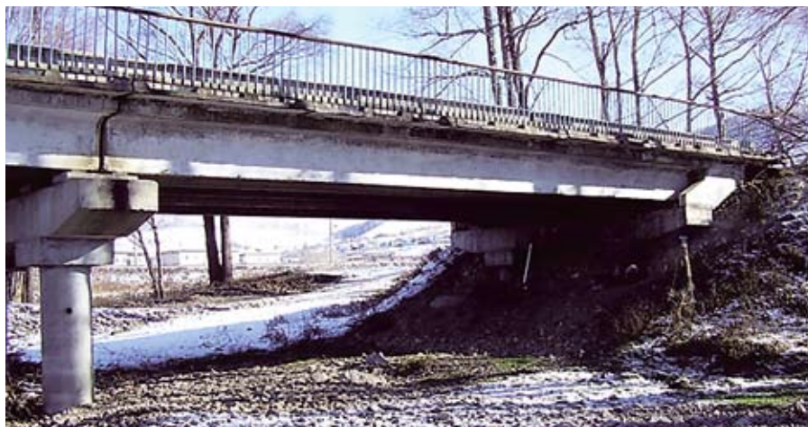
Рис. 2. Мост через р. Хинган в г. Облучье, ЕАО
