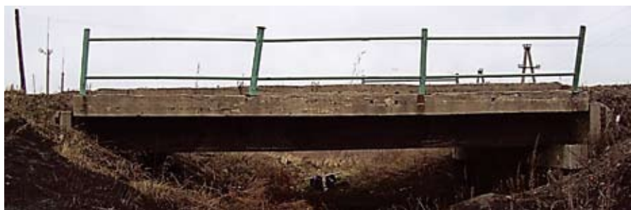
Рис. 1. Мост через суходол в с. Екатириинславка, на Южной ул. Амурской области
