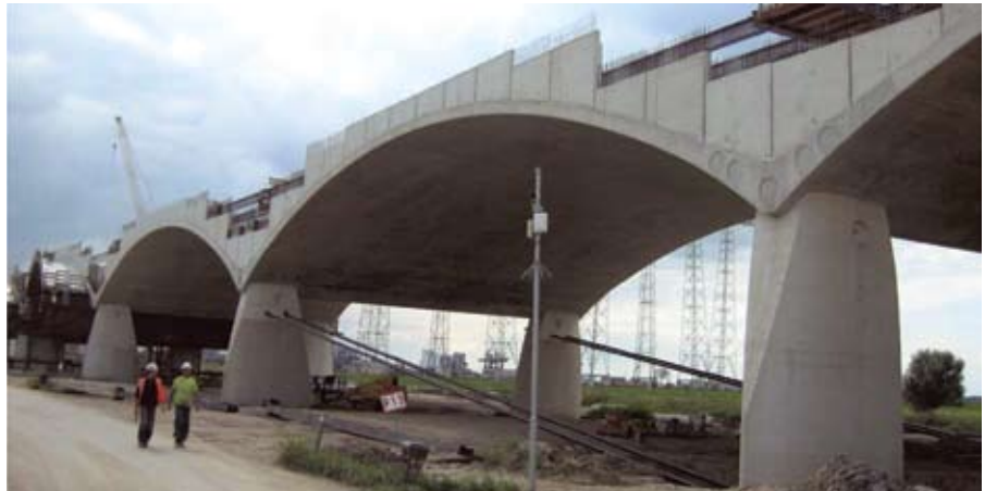
Предварительно напряженные стяжки PN7-PN8
