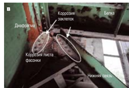
Рис. 11. Изгиб и разрыв связей мостов во время Великого восточно-японского землетрясения 2011 года: а — изгиб и разрыв верхних связей; б — разрыв нижней связи; в — нарушение присоединения нижней связи к листу ребра балки и диафрагме
