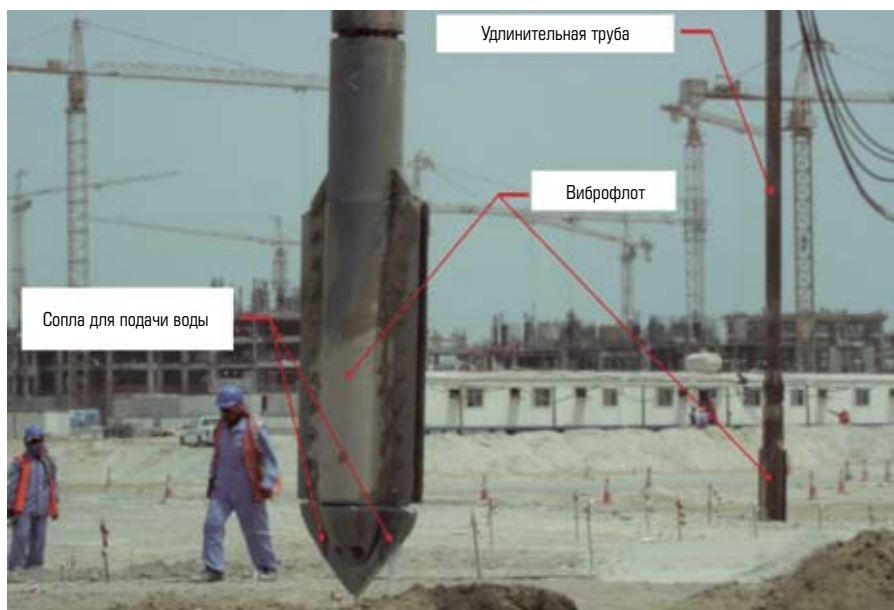
Рис. 7. Гидравлический виброфлот
