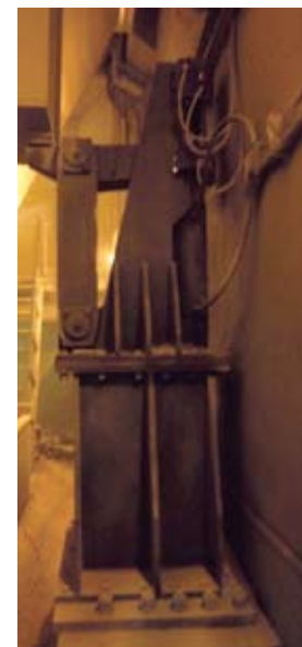
Механизм подклинки, установленный на Ладожском мосту
