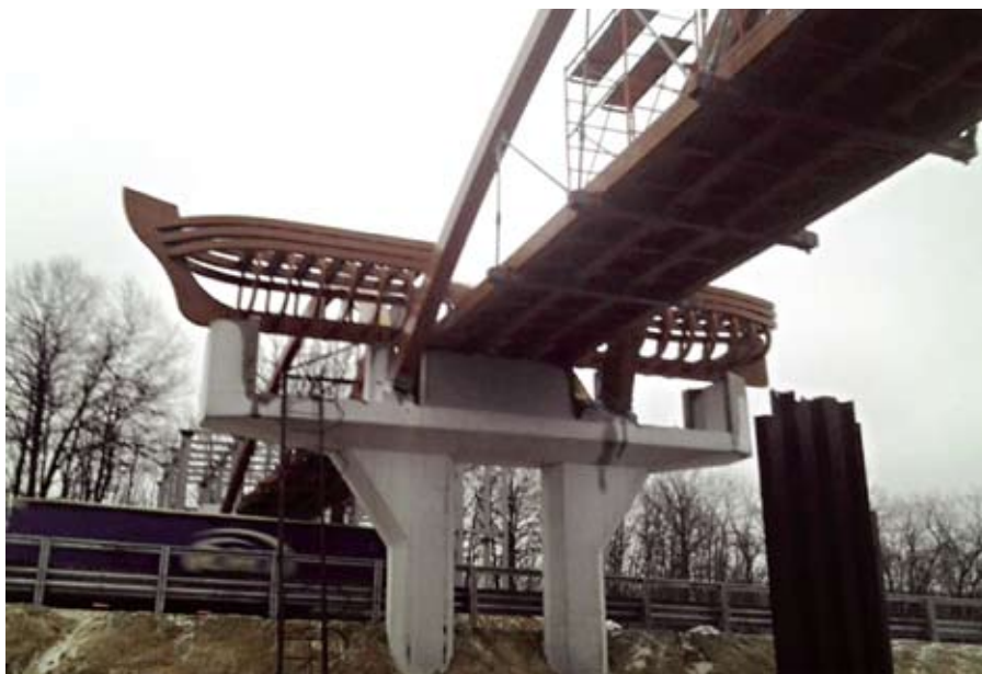
Пешеходный мост из дерево-клееных конструкций
