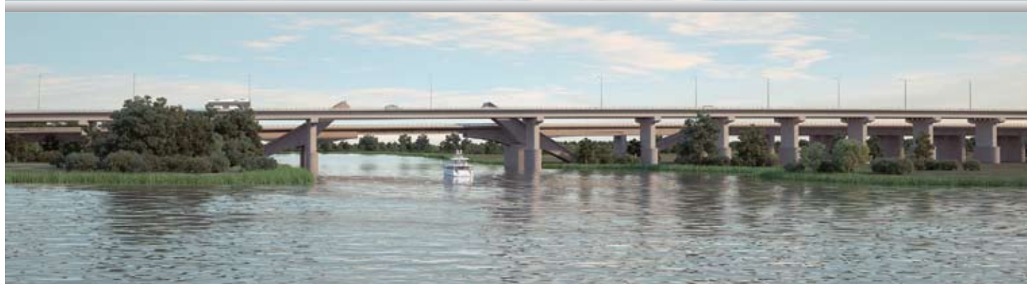
Реконструкция мостового перехода через реки Старая и Новая Преголя на строительстве Южного обхода Калининграда
