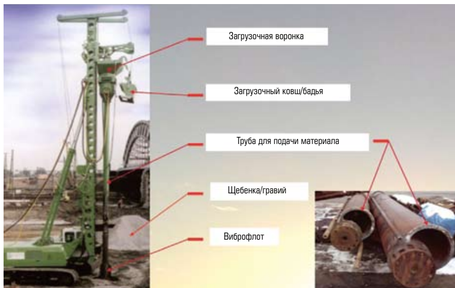
Рис. 6. Создание грунтовых свай методом снизу вверх
