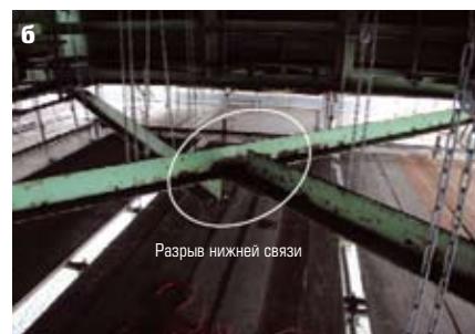
Рис. 11. Изгиб и разрыв связей мостов во время Великого восточно-японского землетрясения 2011 года: а — изгиб и разрыв верхних связей; б — разрыв нижней связи; в — нарушение присоединения нижней связи к листу ребра балки и диафрагме
