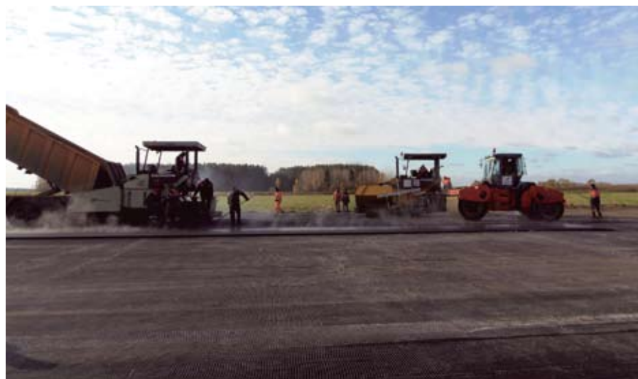
Работы по устройству покрытия с использованием базальтовой сетки в аэропорту (Могилев)
