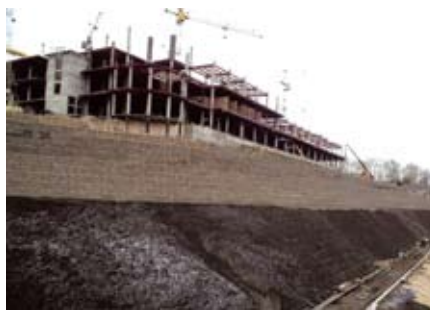
Рис. 2. Подпорная стенка в период строительства
