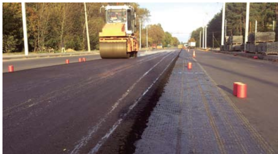
Устройство дорожного покрытия с применением геосетки
