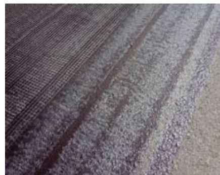
Рис. 5. Укладка дорожной сетки между слоями асфальтобетонного покрытия
