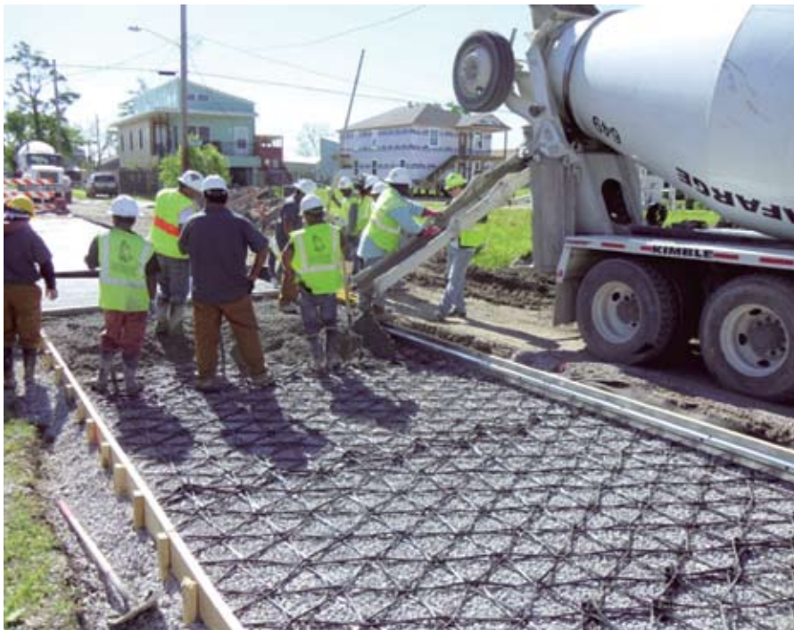
Рис. 6. Применение БПА при строительстве дорог с бетонным покрытием
