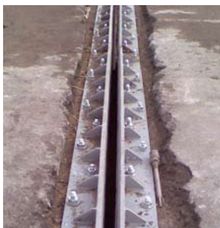
Крепление окаймлений деформационного шва анкерами Hilti
