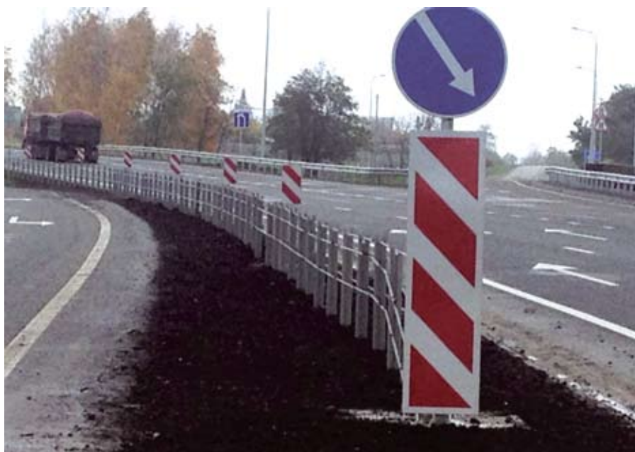
Тросовые осевые дорожные ограждения
