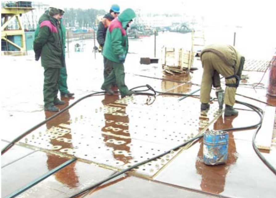
Рис. 1. Демонтаж стыковых накладок пролетных строений временного моста — дублера после надвижки
