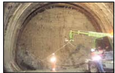
Этап 5. Затяжка торкрет-бетоном временной крепи
