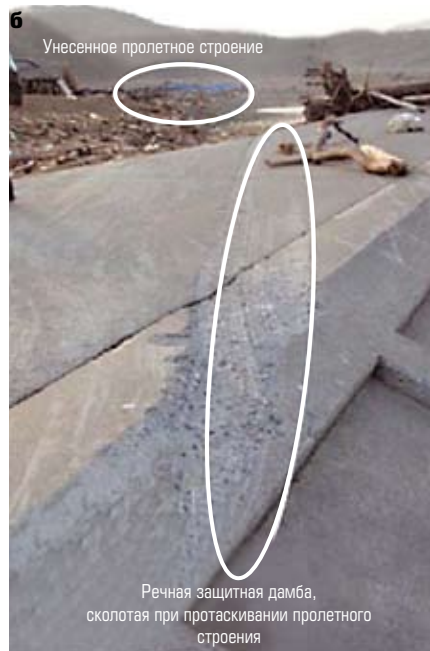
Рис. 25. Результат действия цунами: а — пролеты S1–S3 после сноса, б — сколы защитной речной дамбы, полученные при протаскивании пролетного строения
