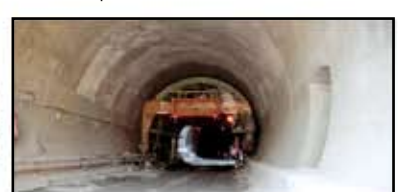
Этап 7. Устройство постоянной обделки. II этап прямой свод
