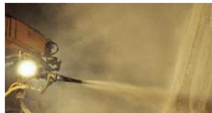
Процесс нанесения торкрет-бетона
