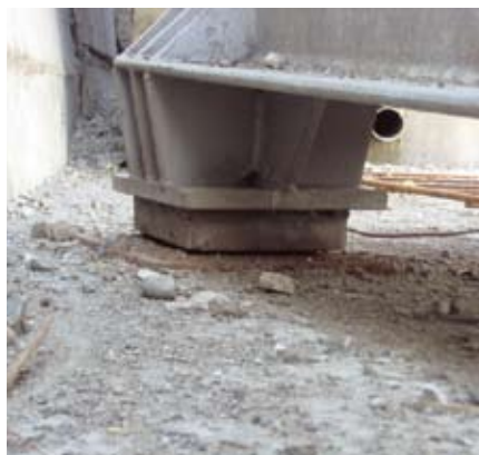
Опорная часть под кабельной эстакадой
