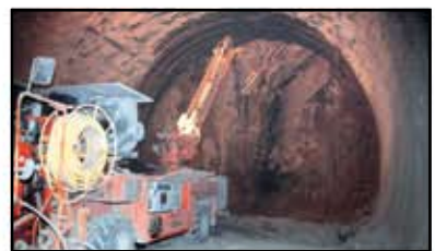
Этап 4. Устройство временной крепи контура выработки из стальных арок
