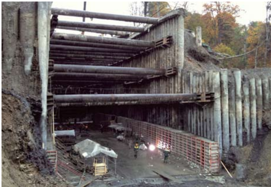
Восточный портал тоннеля на ПК 74
