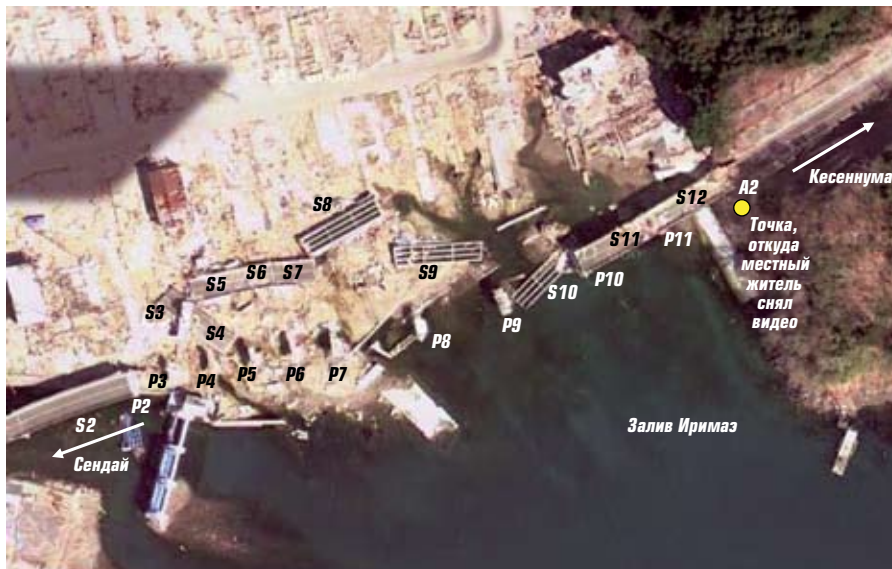
Рис. 18. Повреждение моста Утатсу цунами. S2–S12 — пролетные строения; P2–P11 — промежуточные опоры; A2 — устой
