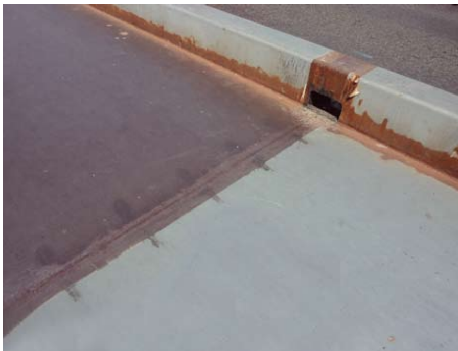
Рис. 3. Готовое тонкослойное покрытие в замке разводного пролета
