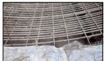
Этап 7. Устройство постоянной обделки. II этап прямой свод
