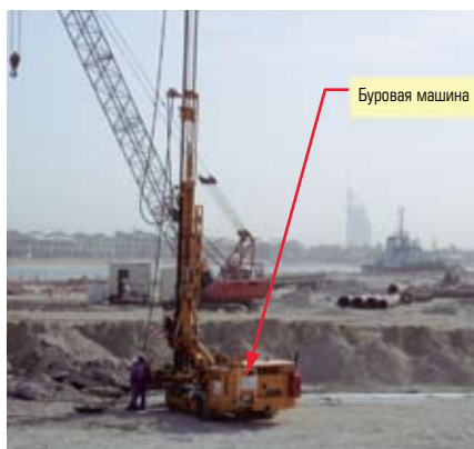
Рис. 16. Буровая машина для проведения струйной цементации
