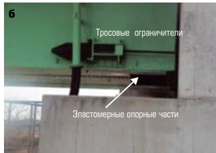
Рис. 16. Мост Шин-Теннох: а — пролеты; б — эластомерные опорные части и тросовые ограничители
