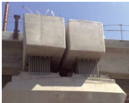
Амортизаторы стержневые на железнодорожной эстакаде
