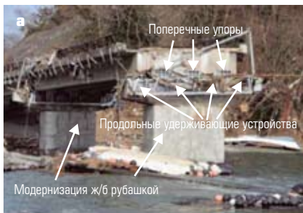
Рис. 23. Механизмы разрушения моста Утатсу волной цунами: а — простое смывание и волочение; б — всплытие перед смыванием и волочением
