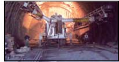
Этап 1. Горизонтальное и наклонное бурение забоя тоннеля с закладкой стекловолоконных труб
