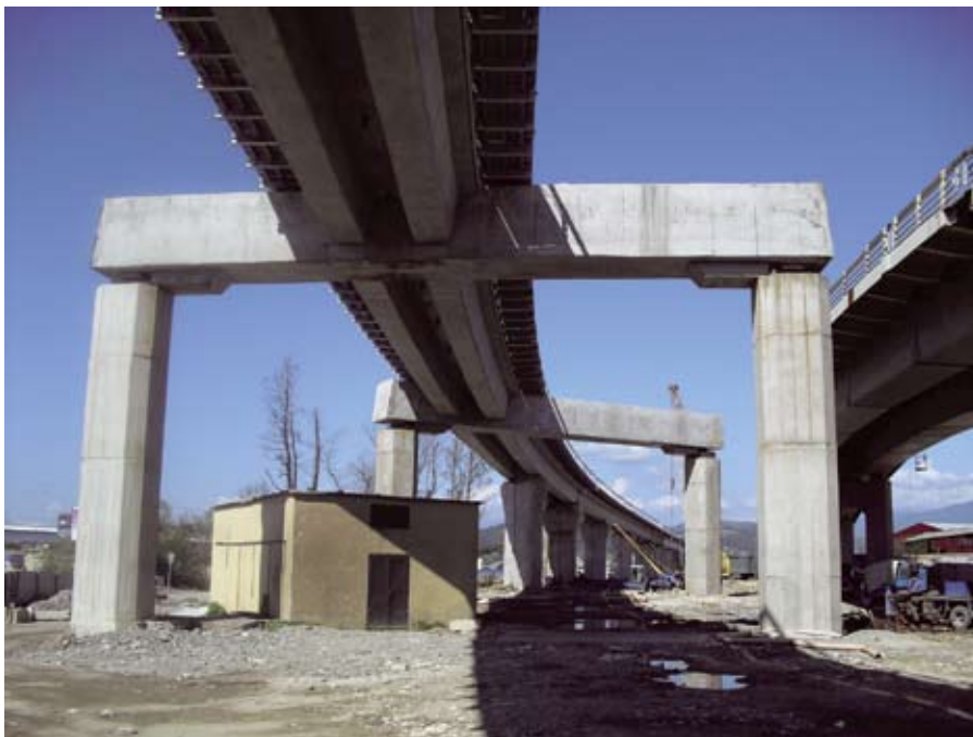
Эстакада на железной дороге Адлер — Красная Поляна (применены деформационные швы и сейсмозащитные устройства, изготовленные ООО «СК Стройкомплекс-5»)
