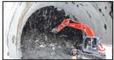
Этап 3. Нанесение торкрет-бетона на лоб забоя и прилегающие поверхности для защиты проходки тоннеля
