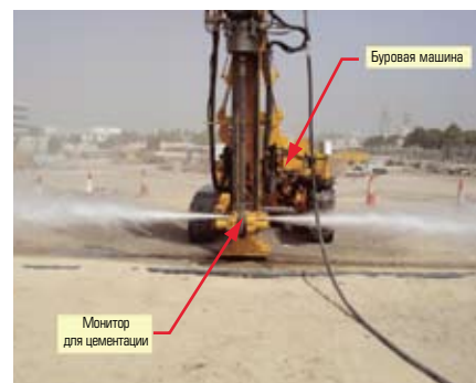
Рис. 18. Подача воды через монитор под высоким давлением
