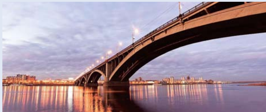
Светильники GALAD ЖКУЗ5, установленные на Коммунальном мосту в Красноярске
