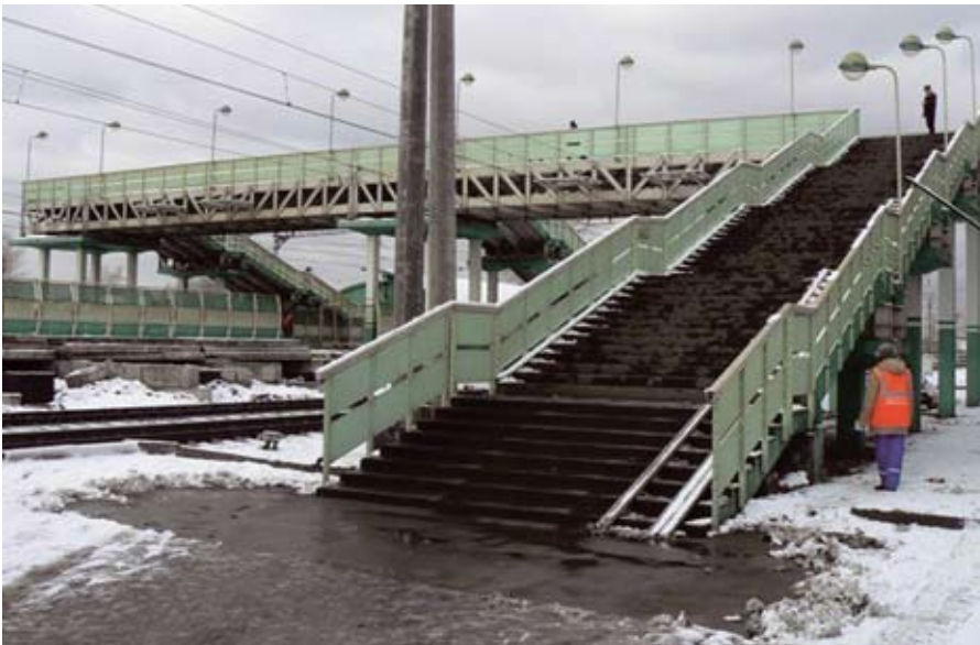
Пешеходный путепровод из композитного материала над железной дорогой
