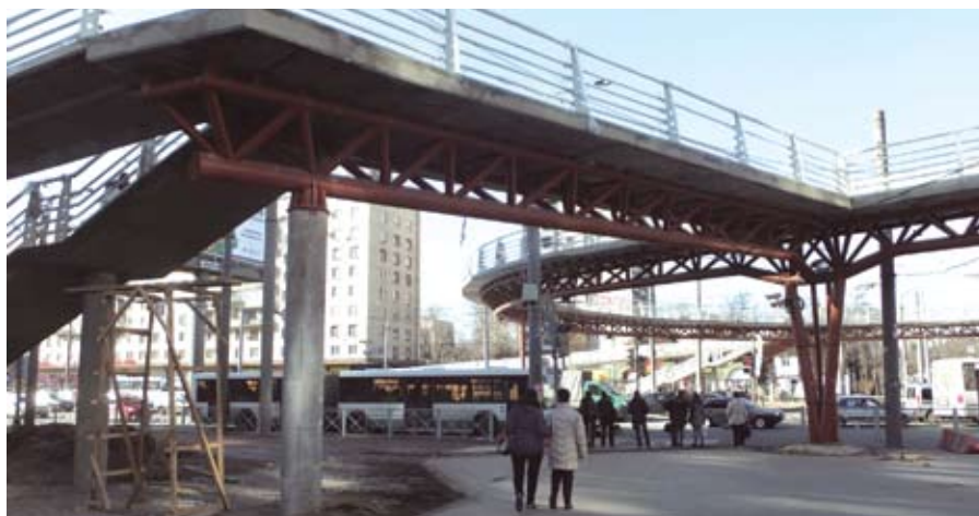
Участок прохода с пролетного строения пешеходного перехода к лестничному сходу и пандусу
