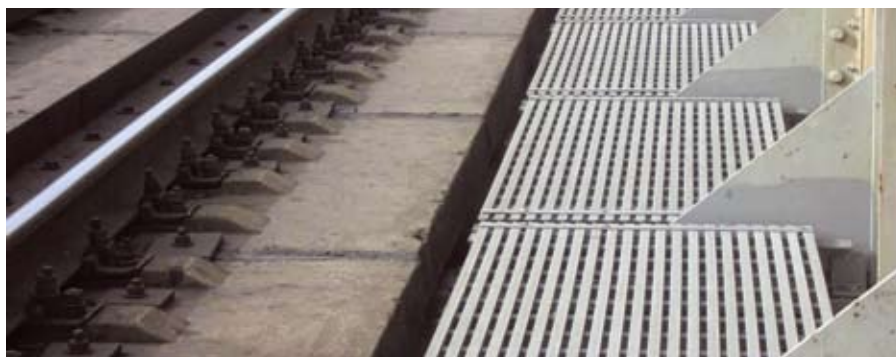
Пешеходный настил из композитного материала
