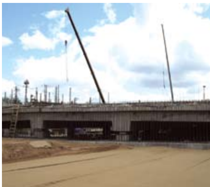
Рис. 7. Участок сопряжения насыпи с эстакадой №1
