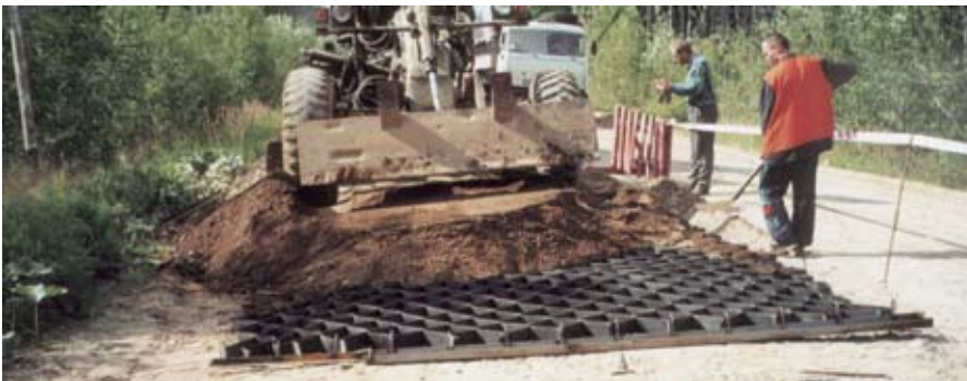
Рис. 3. Армирование грунтового основания объемной георешеткой на объекте в Ленинградской области
