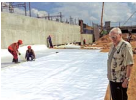
Рис. 9. Укладка геосинтетики. Научное руководство строительства — филиал ОАО ЦНИИС НИЦ «Мосты» (А.Д. Соколов)
