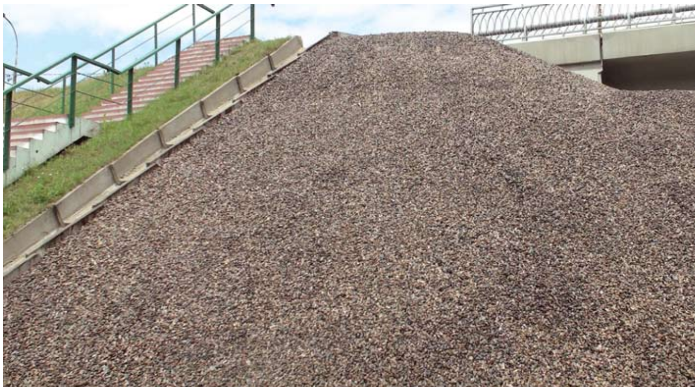
Рис. 6. Результат ремонта конуса моста (ноябрь 2014 года)
