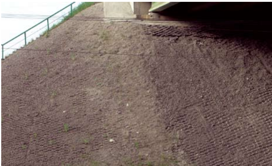
Рис. 3. Состояние щебеночной конструкции конуса моста, укрепленной объемной георешеткой (июнь 2014 года)
