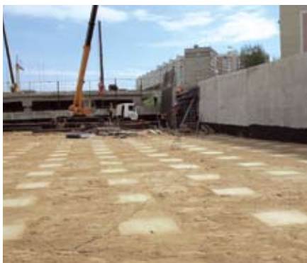
Рис. 8. Усиление слабого основания с помощью свайного поля
