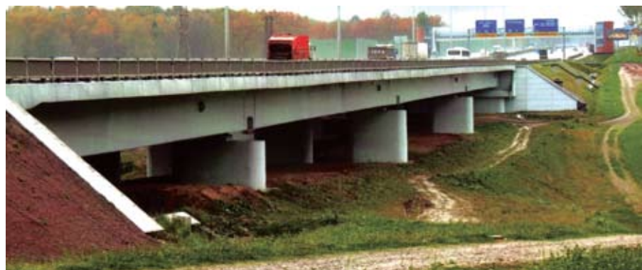
Рис. 6. Общий вид моста через р. Ликову на Киевском шоссе. 2006 год
