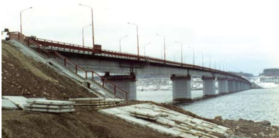
Рис. 4. Мост через р. Чусовую на автодороге Пермь — Березняки после восстановления насыпи и устройства противооползневой армогрунтовой системы
