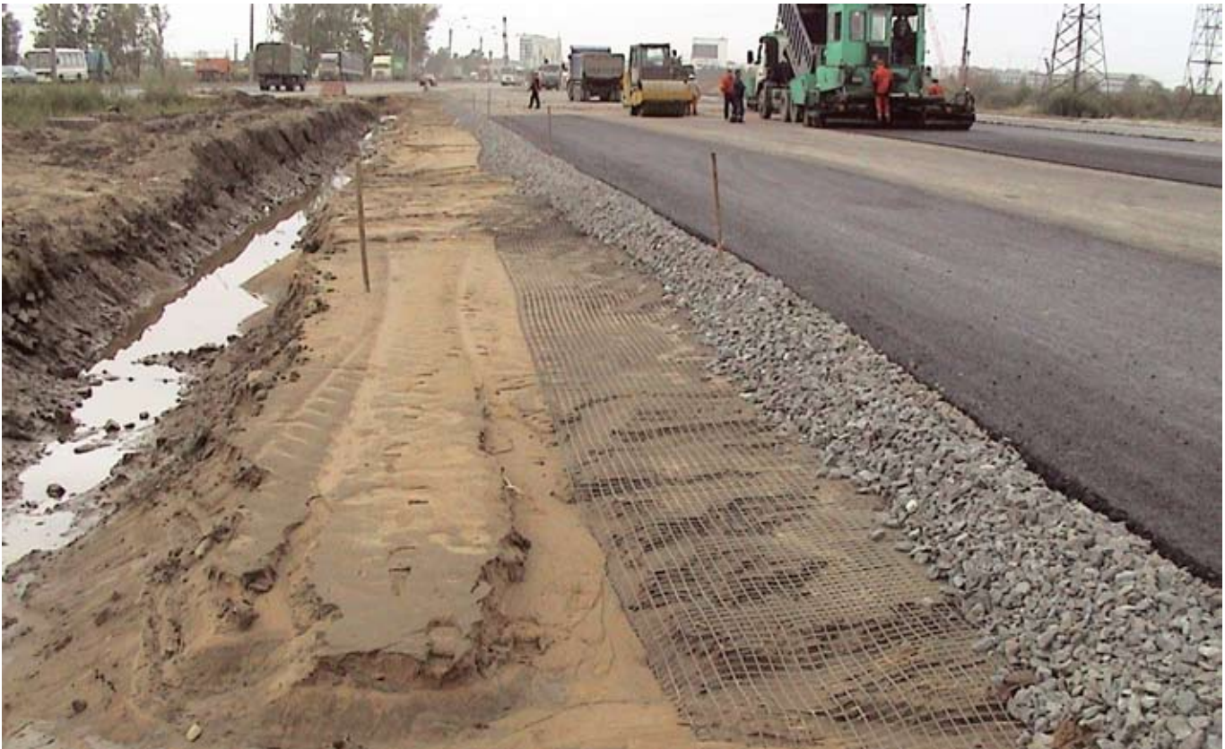
Рис. 2. Армирование щебеночного основания двухосной решеткой Форнит на автомобильной дороге в Ленинградской области
