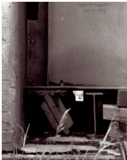
Рис. 1. Пролетное строение моста через р. Дон уперлось в шкафную стенку. Наклонное положение опорной части. 1995 год
