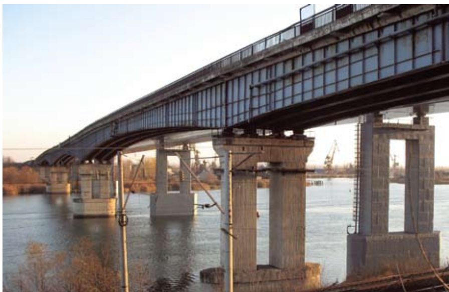
Рис. 2. Общий вид реконструируемого старого Аксайского моста через р. Дон
