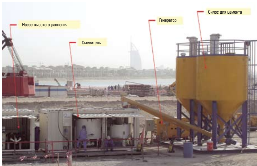
Рис. 5. Комплекс для струйной цементации (Jet Grouting)
