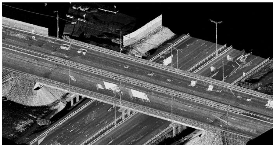
Транспортная развязка автомобильной дороги А107 с М1 «Беларусь»
