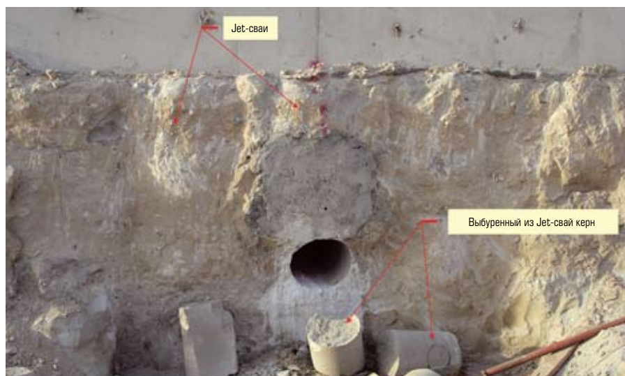
Рис. 9. Керны, выбуренные из тела свай
