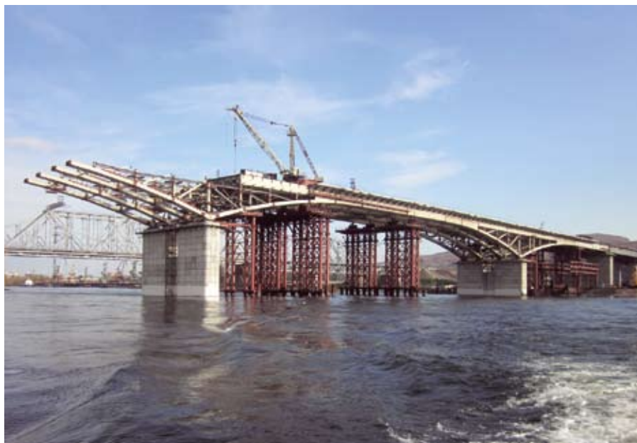
Рис. 4. Монтаж пролетного строения краном МДК-63М
