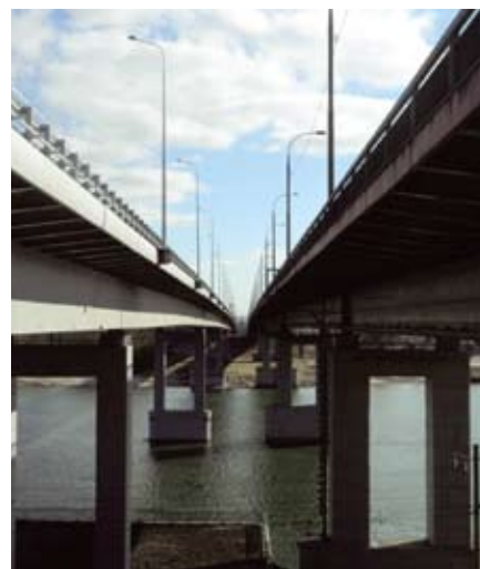
Сооружения Аксайского моста трассы М4 «Дон»
