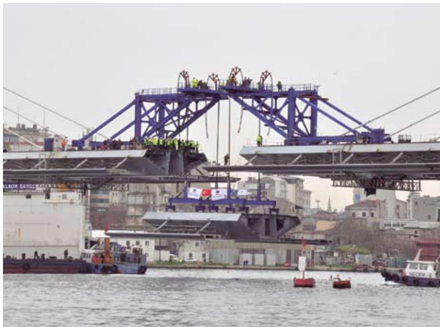
Рис. 7. Замыкание балки жесткости
