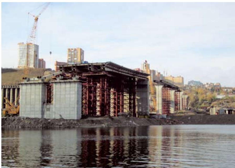
Рис. 5. Монтаж пролетного строения 8–10 с земли
