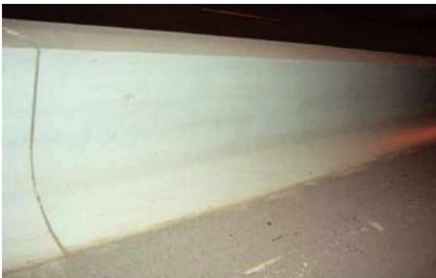
Применение системы защитного покрытия на основе ЗПСМ — ЗПСМ-Б-2 на железобетонных блоках разделительной полосы МКАД
