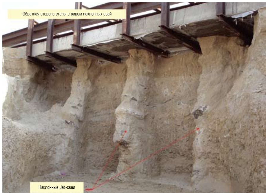
Рис. 8. Вид на обратную сторону ограждающей стены
