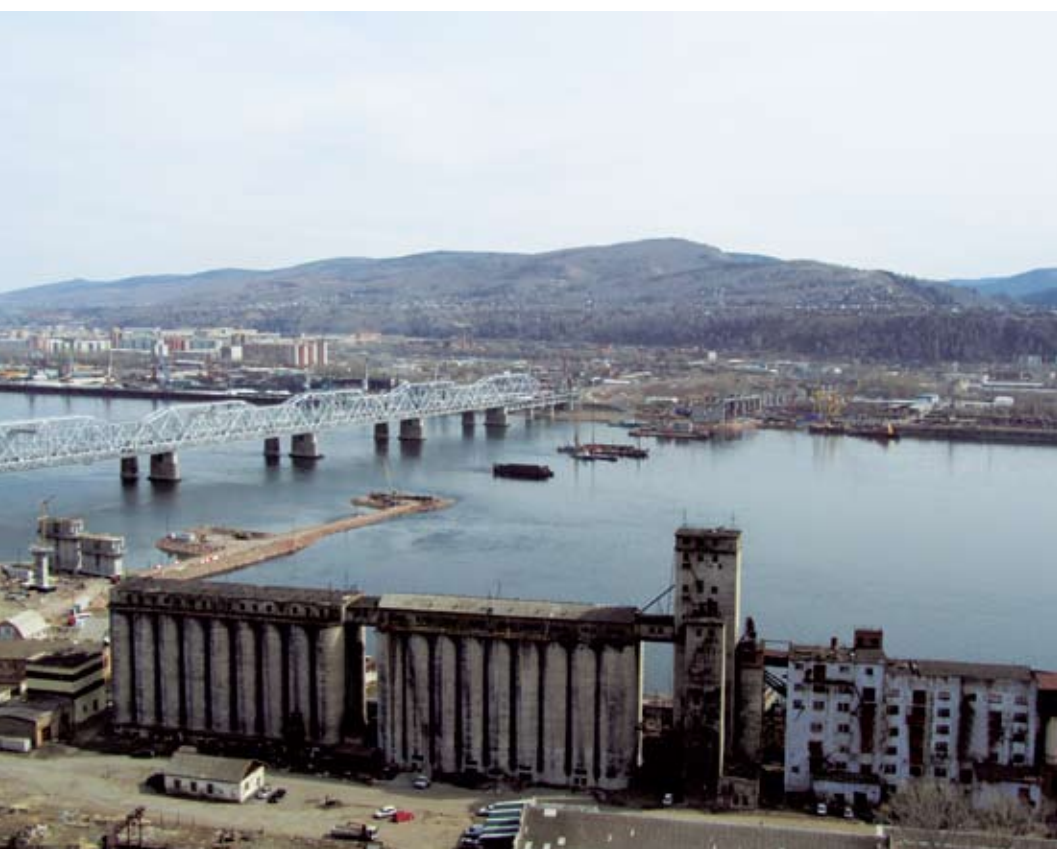
Рис. 2. Сооружение опор с полуостровков
