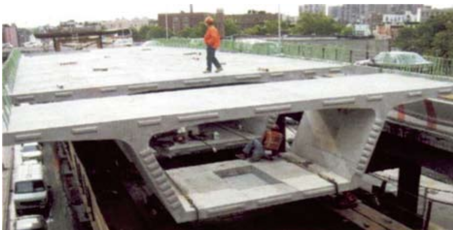
Рис. 3. Типовой сборный коробчатый железобетонный элемент для возведения дорожных эстакад
