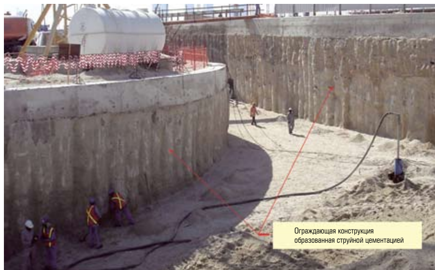
Рис. 7. Ограждающая конструкция, образованная методом струйной цементации
