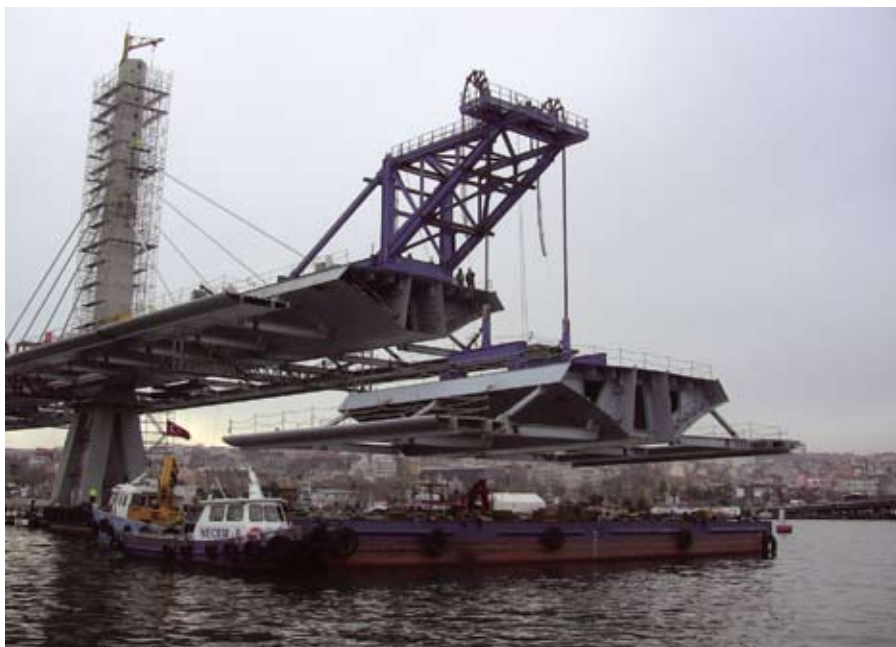
Рис. 6. Подъем стандартной секции
