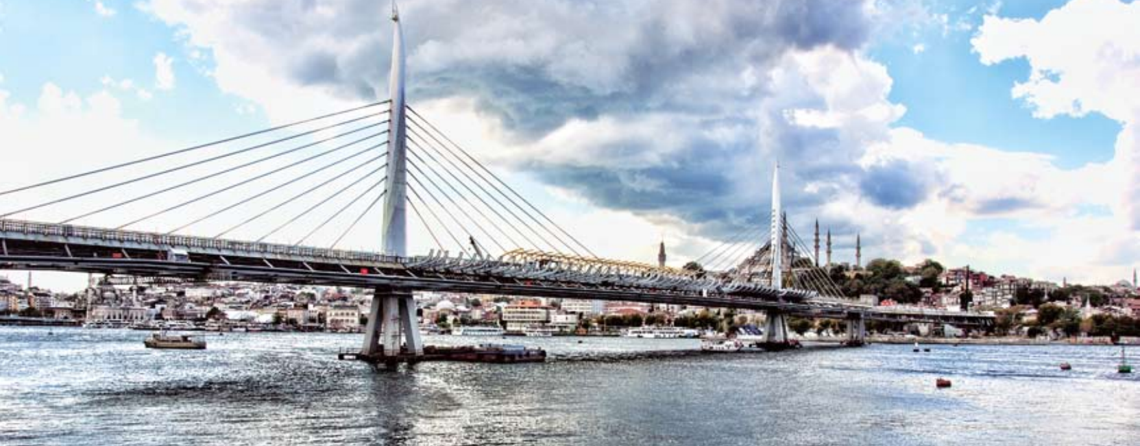
Рис. 1. Общий вид моста «Халич» (залив Золотой Рог)
