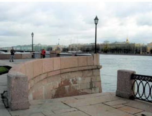
Устой существовавшего наплавного Исаакиевского моста
