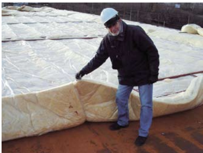
Утепление металла верха ортотропной плиты под окраску
