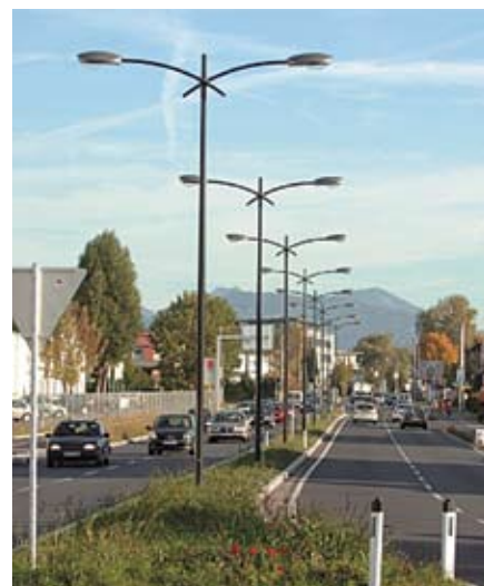
Светильники на опорах из стеклопластика (Австрия)
