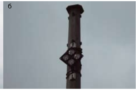
Рис. 5. Датчик поперечных сечений на путепроводе в створе проспекта Александровской Фермы: а) излучатель на пилоне; б) отражатель в середине пролета
