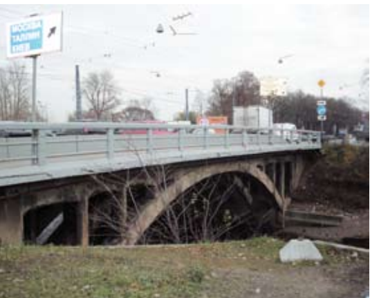
Шлиссельбургский мост через Обводный канал
