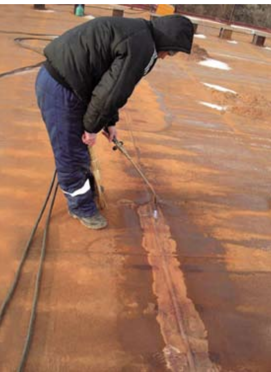
УЗД-контроль сварных швов. Этап 1 (прогрев металла ортотропной плиты)
