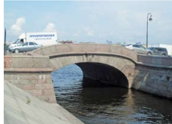
Верхне-Лебяжий мост через Лебяжью канавку
