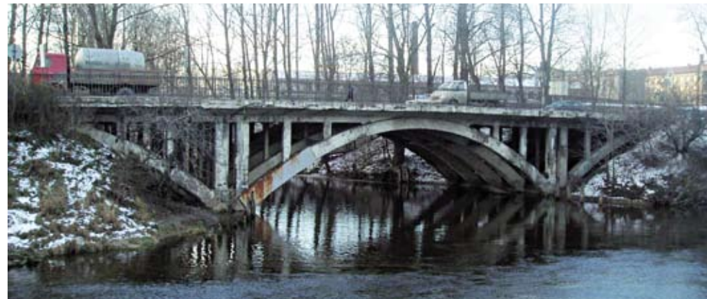
Ново-Кирпичный мост через реку Волковку
