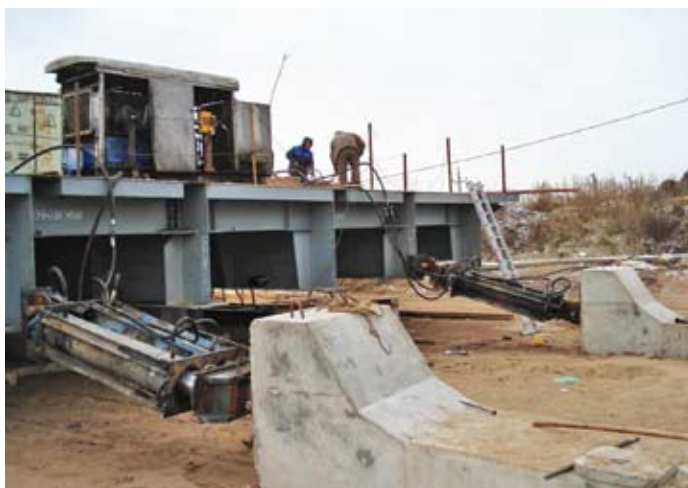
Толкающие устройства — спаренные гидравлические домкраты и упорные железобетонные якоря
