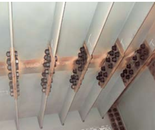
Соединение на протарированных высокопрочных болтах
