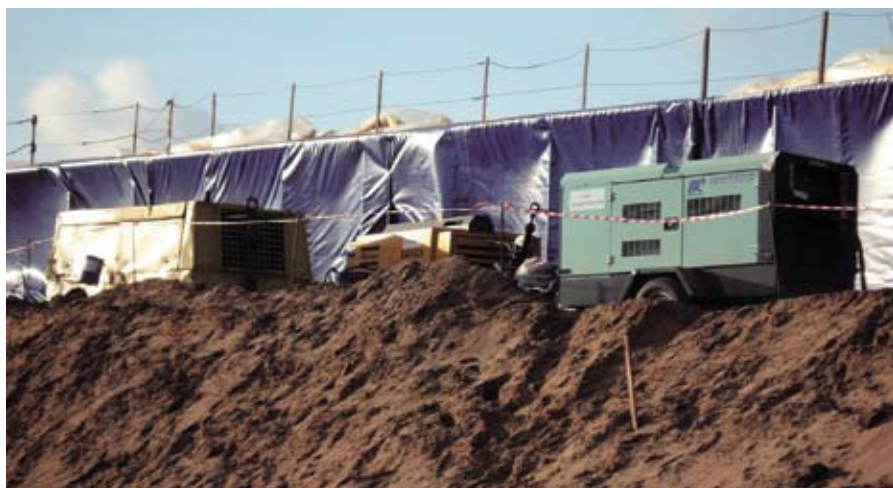
Тепляк для защиты антикоррозионных работ
