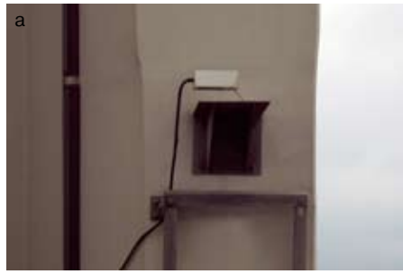
Рис. 5. Датчик поперечных сечений на путепроводе в створе проспекта Александровской Фермы: а) излучатель на пилоне; б) отражатель в середине пролета
