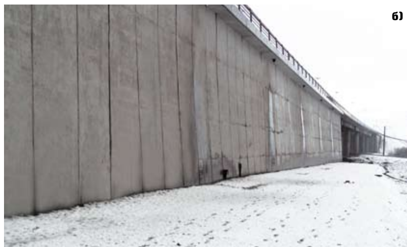
Рис. 3. Армогрунтовая насыпь на КАД на участке ПК 567+98,00 — ПК 585+76,00 в районе ст. Обухово (Лоты 1.4 —1.11): а — схема; б — реализация проекта
