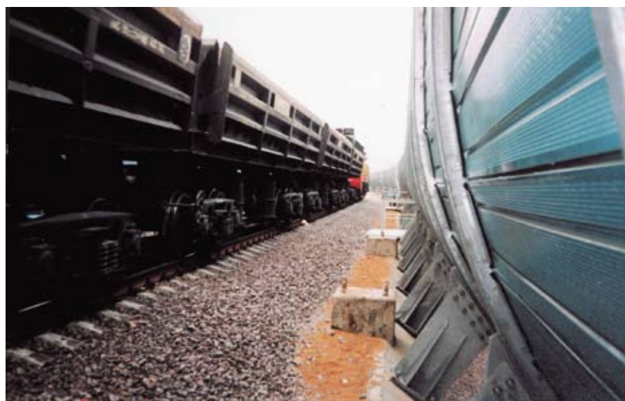
Рис. 1. Армогрунтовая насыпь на подходе к Андреевскому железнодорожному мосту на 3-м транспортном кольце г. Москвы: а — схема; б — реализация проекта
