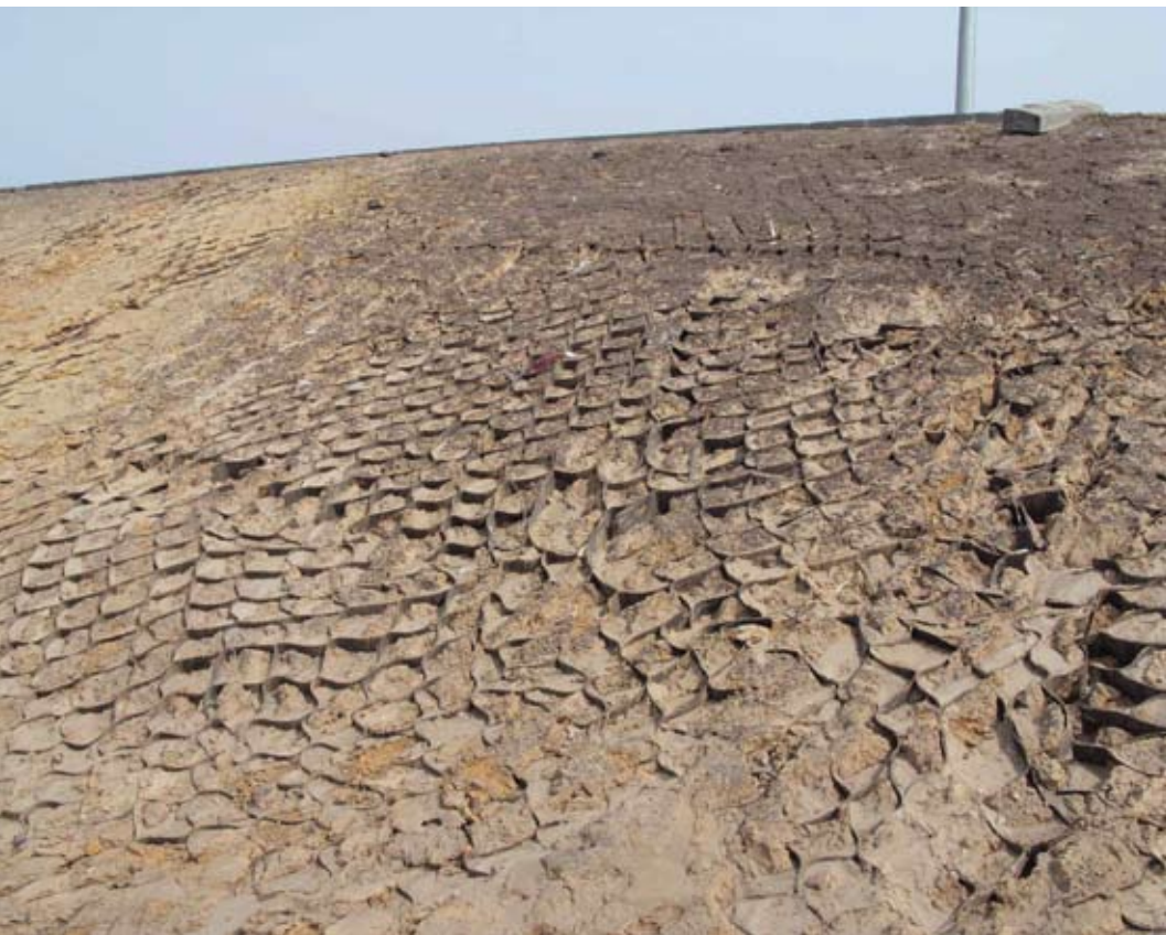
Рис. 3. Результат применения контрафактной георешетки в течение одного летнего сезона
