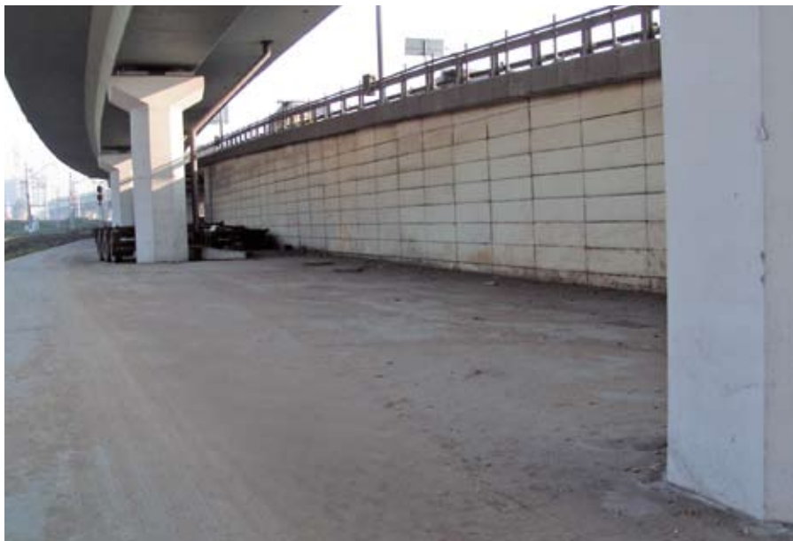
Рис. 2. Армогрунтовая насыпь на подходе к магистральной эстакаде от Звенигородского шоссе до Беговой улицы: а — схема; б — реализация проекта
