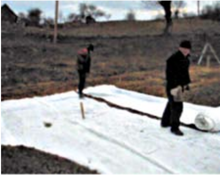
Укладка нетканого геосинтетического материала в Запорожской области
