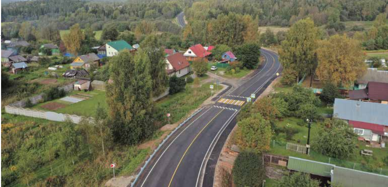
Ярославская область, автодорога Ярославль - Тутаев - Левый берег (в рамках реализации национального проекта «Безопасные и качественные автомобильные дороги» в 2020 году)
