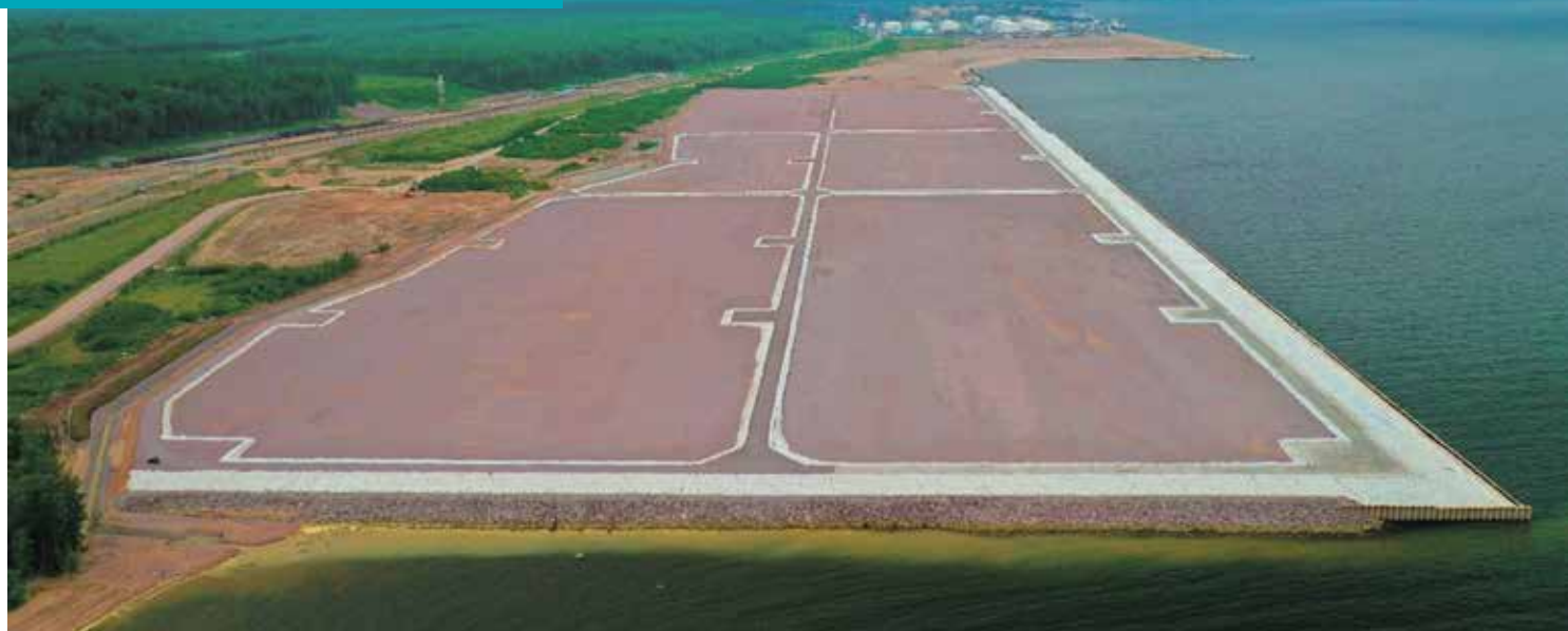
Искусственные земельные участки терминала LUGAPORT. Июнь 2020 года
