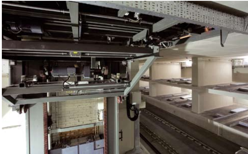
Рис. 4. Подземный «сейф-паркинг» рядом с Исаакиевской пл. в Санкт-Петербурге
