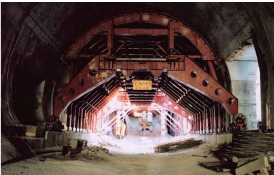
На строительстве автодорожного тоннеля в Уфе
