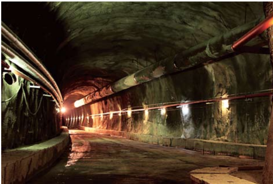
Фрагмент Юкспорского тоннеля №2
