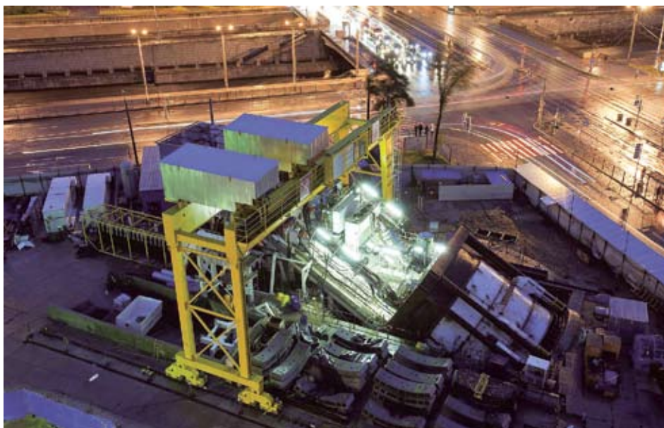
Строительство станции метро «Обводный канал»
