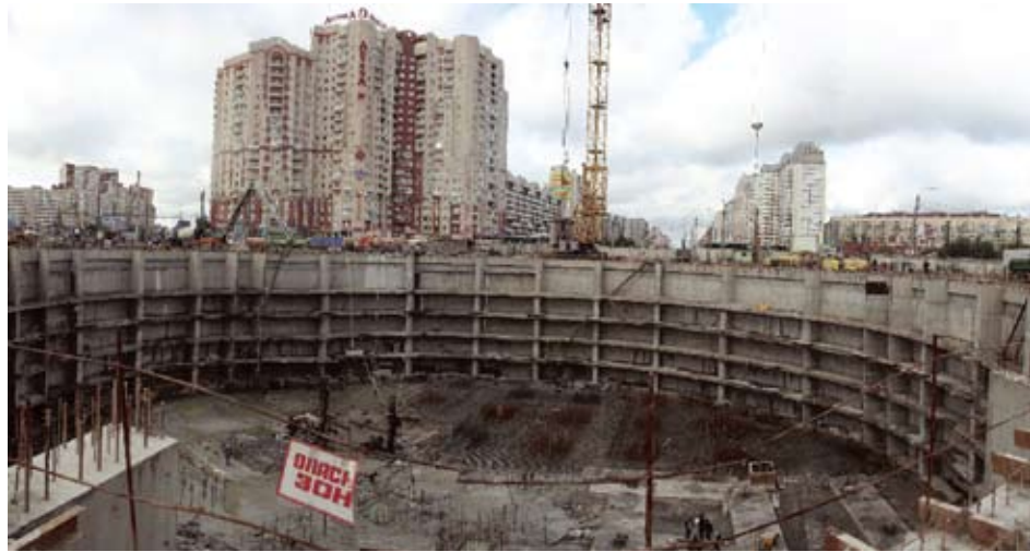
Рис. 3. Котлован на Комендантской площади в Санкт-Петербурге
