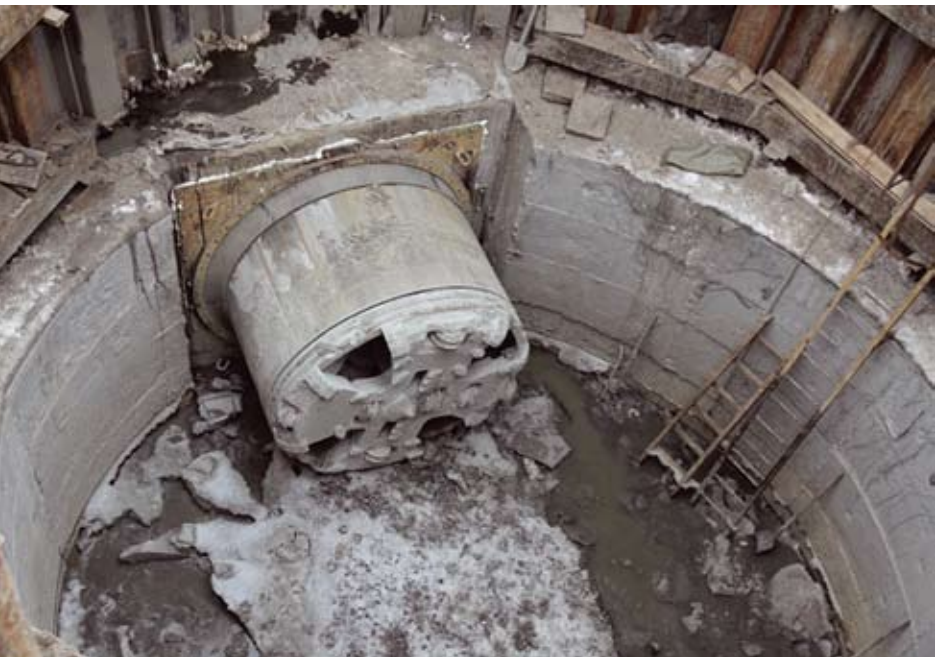
СМУ-13. Натяжная камера станции метро «Спасская»
