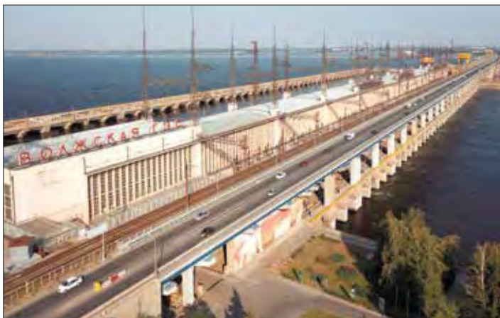
Мостовой комплекс в составе Волжской ГЭС
