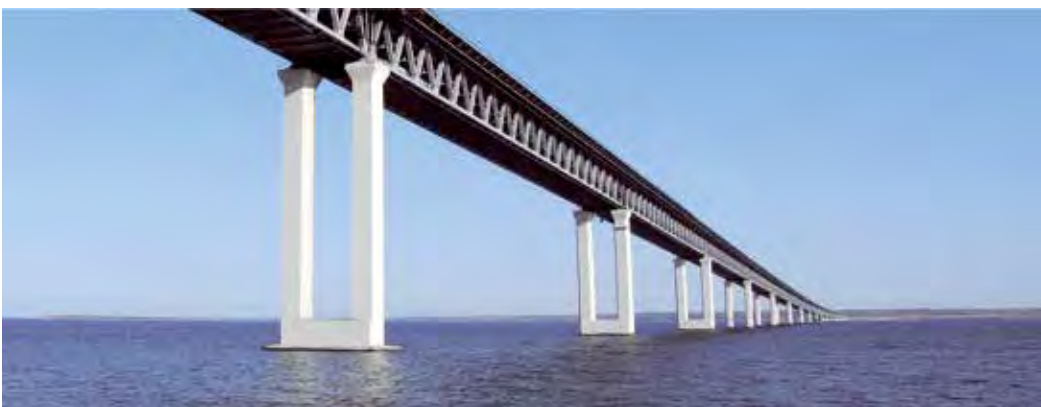
Мостовой переход через реку Волга, г. Ульяновск Покрытие: ЦИНОТАН® + ПОЛИТОН®-УР + ПОЛИТОН®-УР(УФ)
