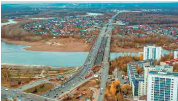
Мост через реку Белую (Уфа)
