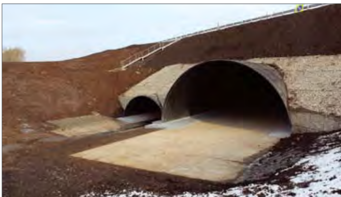
Водопропускное сооружение на 105 км автомобильной дороги Р-240 «Уфа — Оренбург»
