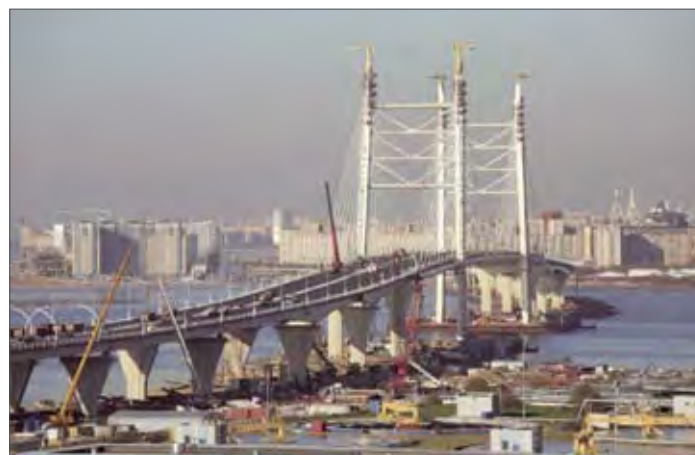
Вантовый мост через Корабельный фарватер
