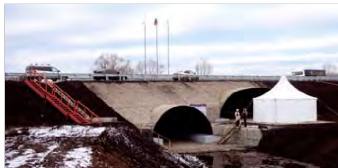
Рис. 4. Водопропускное сооружение на 1418 км автомобильной дороги М-5 «Урал»
