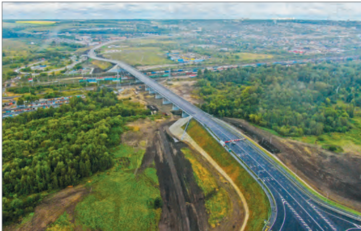
Путепровод на улице 40 лет Октября
