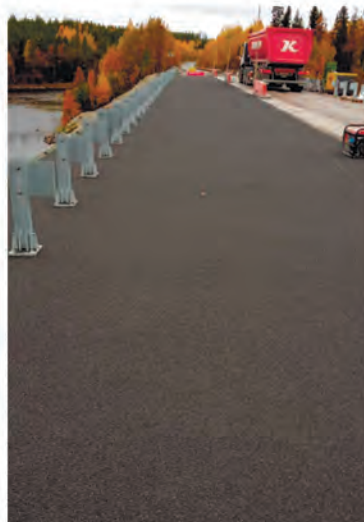
Мост через реку Умба. Тонкослойное покрытие АСТРАММА 18 мм
