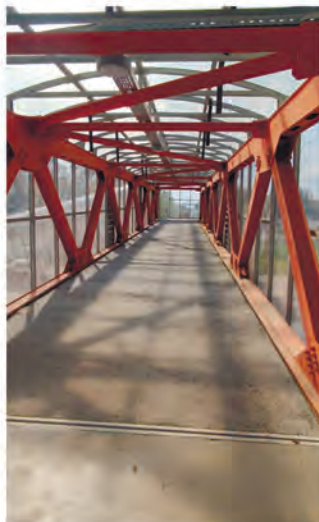
Пешеходный переход в районе аэропорта Шереметьево. Тонкослойное покрытие АСТРАММА 6 мм
