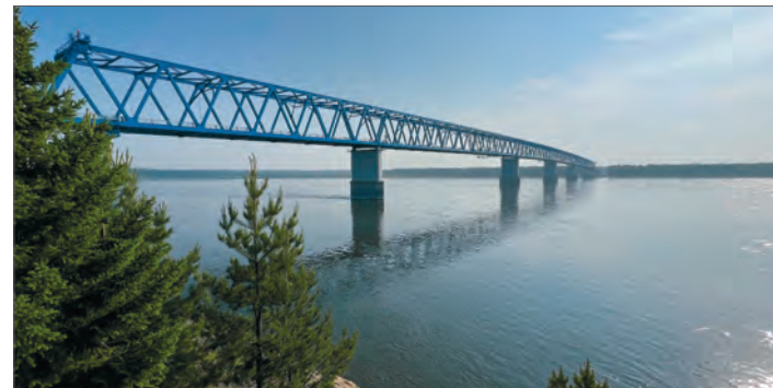
Высокогорский мост. Фото: «ВМП-Инжиниринг»
