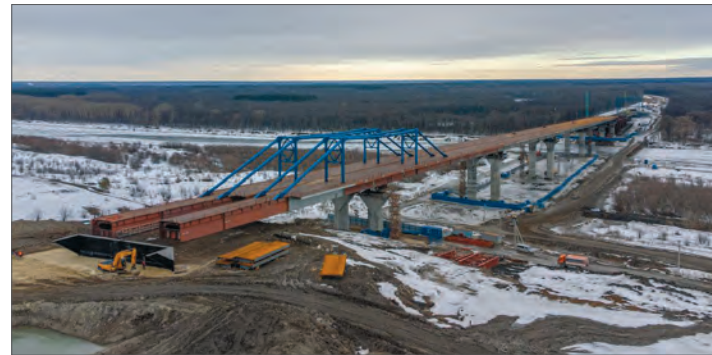
Мост через Суру. Фото: ГК «Автодор»
