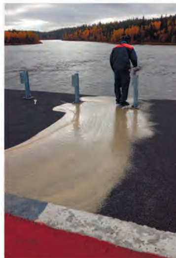
Мост через реку Умба. Тонкослойное покрытие АСТРАММА 18 мм
