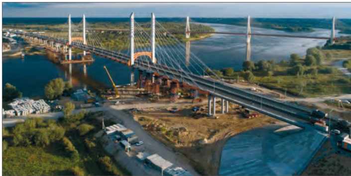
Мост через Оку. Фото: ГК «Автодор»
