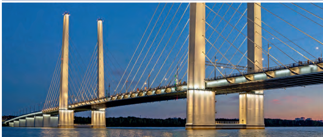
Мостовой переход «Архангельский» через р.Шексна, г.Череповец Металлические конструкции: ЦИНОТАН + ПОЛИТОН-УР + ПОЛИТОН-УР (УФ) Железобетонные опоры и пилоны: ФЕРРОТАН-про + ФЕРРОТАН + ПОЛИТОН-УР (УФ)
