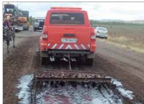
Рис. 5. Перемешивание суспензии с ПГС боронной
