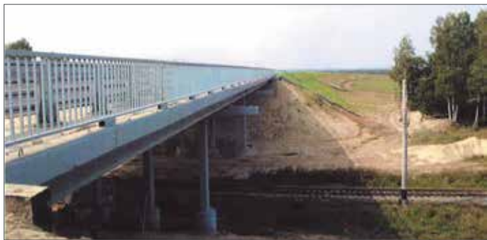
Рис. 2. Путепровод через железную дорогу у станции «Металлист» (Нижегородская обл.)
