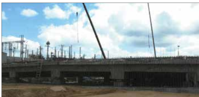
Рис. 6. Участок сопряжения насыпи с эстакадой №1
