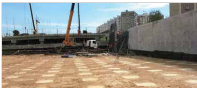
Рис. 7. Усиление слабого основания с помощью свайного поля
