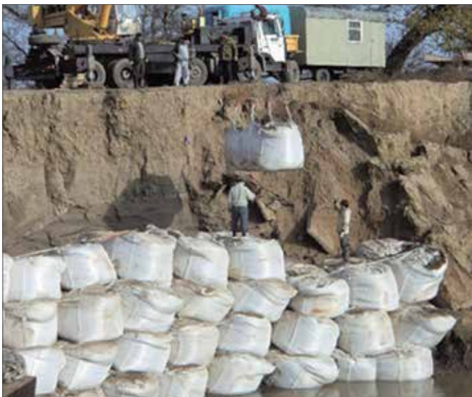
Рис. 2. Укрепление размываемого берега при помощи геоконтейнеров «ГеоБЭГ»
