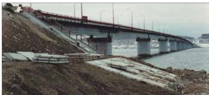
Рис. 3. Мост через р. Чусовую на автодороге Пермь – Березняки после восстановления насыпи и устройства противооползневой армогрунтовой системы
