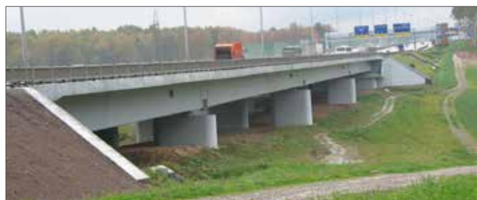
Рис. 5. Общий вид моста через р. Ликову на Киевском шоссе в Московской области (2006 г.)
