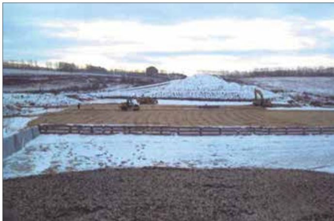
Рис. 6. Щебеночная обойма, объединяющая ростверк из георешетки Fortrac и прочного геотекстиля, наполненная щебнем фракции свыше 20 мм (до 40 мм) М 1200
