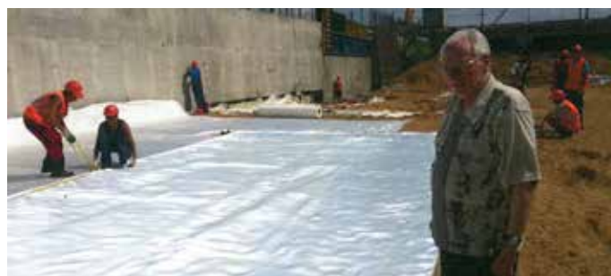
Рис. 8. Укладка геосинтетики; научное руководство строительства – НИЦ «Мосты» АО «ЦНИИС» (Соколов А.Д.)
