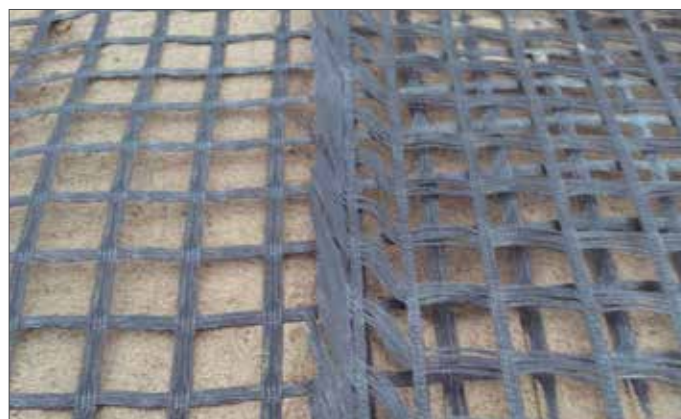
Рис. 2. Армирующий слой георешетки
