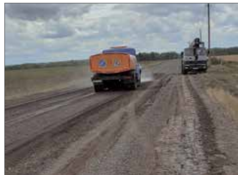
Рис. 4. Распределение битумной суспензии
