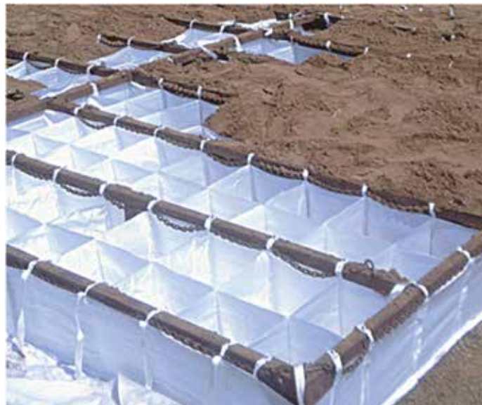
Рис. 3. Геооболочка «ГеоФРАМ», растянутая на жестком каркасе
