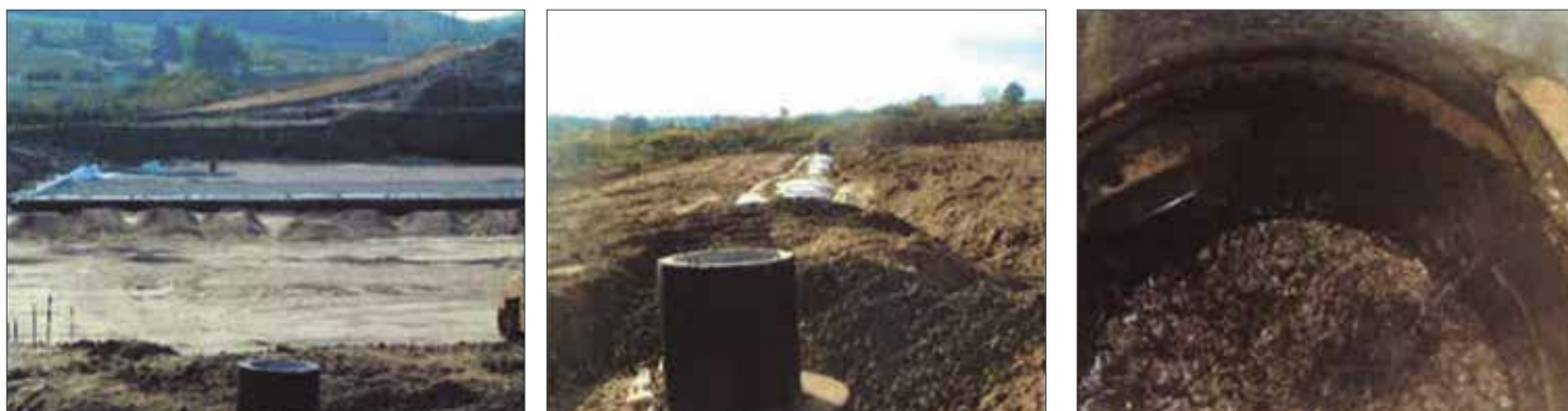
Рис. 4. Устройство продольных глубоких подкюветных и поперечных дренажей
