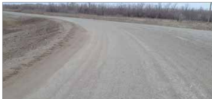
Рис. 7. После открытия движения: деформаций от колес не наблюдалось
