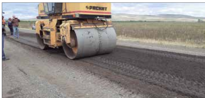
Рис. 6. Уплотнение смеси с битумной суспензией катком
