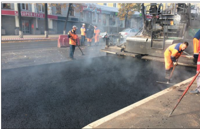
Процесс укладки асфальтобетонной смеси ЦМА-15 с применением модификатора PROpolymer MA 123
