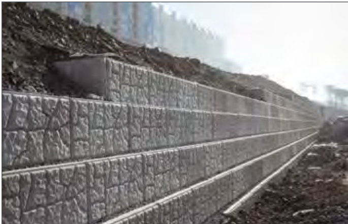
Рис. 1. Подпорная стена из пустотелых железобетонных блоков во Владивостоке
