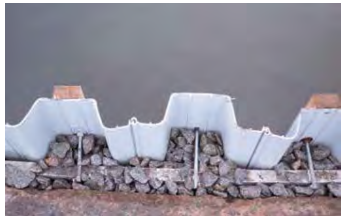
Рис. 2. Берегозащитное сооружение с применением полимерной шпунт-сваи
