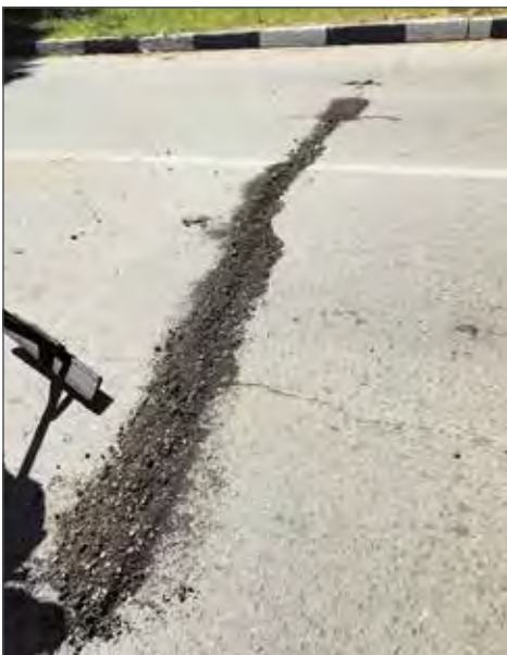
Рис. 5. Распределение ремонтной смеси в раскрытой трещине
