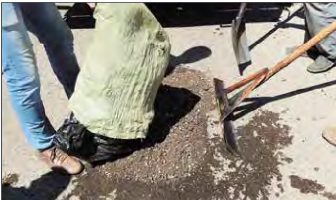
Рис. 4. Распределение ремонтной смеси в карте (подготовка к ремонту картами проезжей части на ул. Клочкова, г. Саратов)
