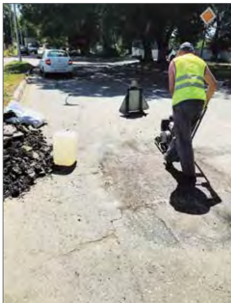
Рис. 6. Уплотнение ремонтной смеси
