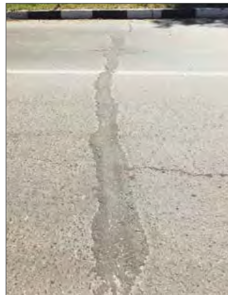
Рис. 5. Распределение ремонтной смеси в раскрытой трещине
