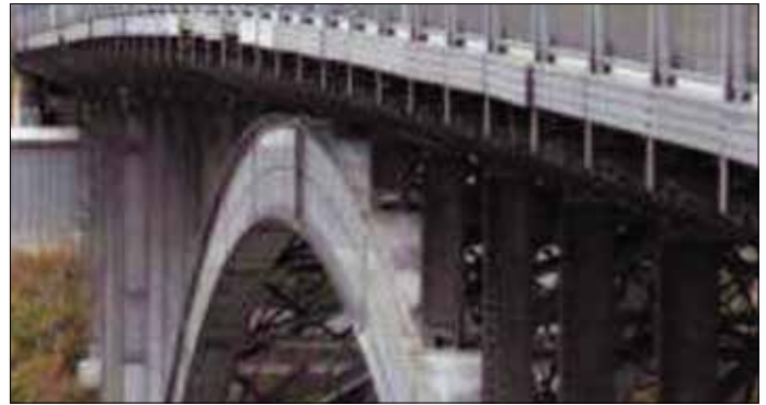
Мост через реку Сагены
