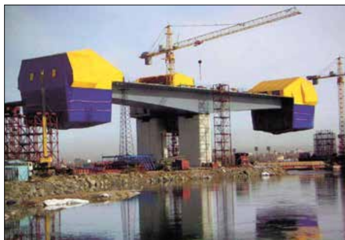
Рис. 3. Навесное бетонирование пролетного строения коробчатого сечения (gamtakaz.kz)
