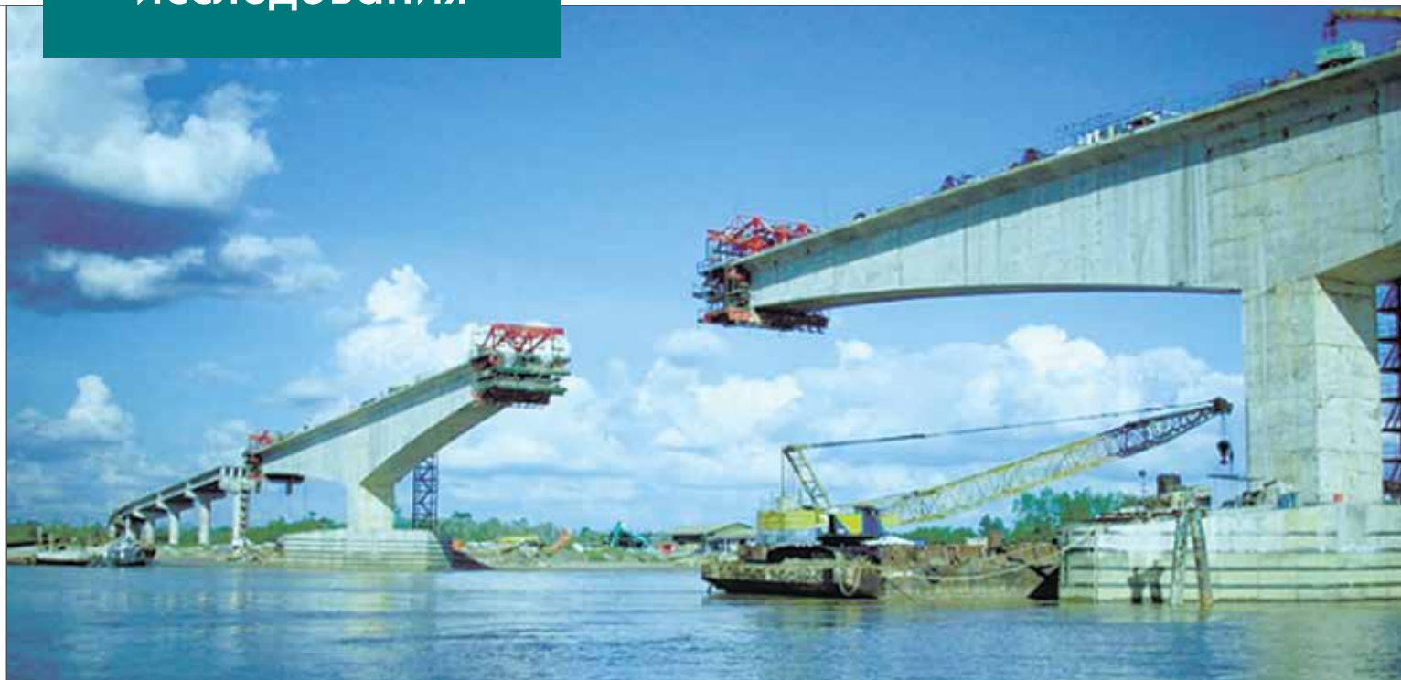
Рис. 1. Уравновешенная навесная сборка железобетонного пролетного строения коробчатого сечения (stroyone.com)
