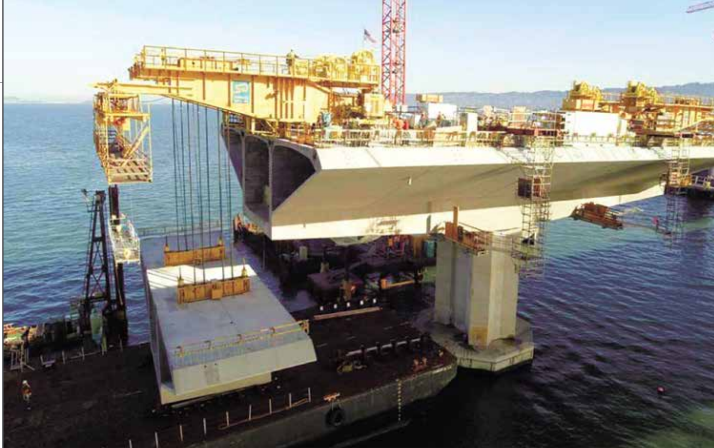
Рис. 2. Этап навесной сборки железобетонного пролетного строения коробчатого сечения (baybridgtinfo.org)
