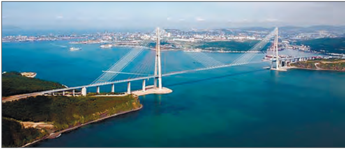
Рис. 1. Общий вид моста на о. Русский через пролив Босфор Восточный
