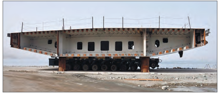
Рис. 2. Монтажный блок балки жесткости руслового пролетного строения моста на о. Русский через пролив Босфор Восточный
