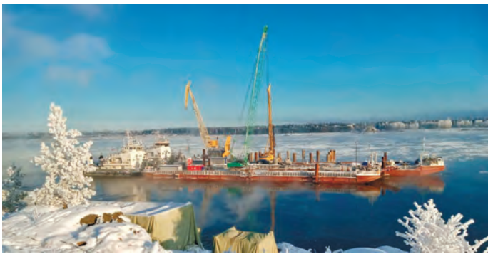
Устройство фундамента опоры № 4
