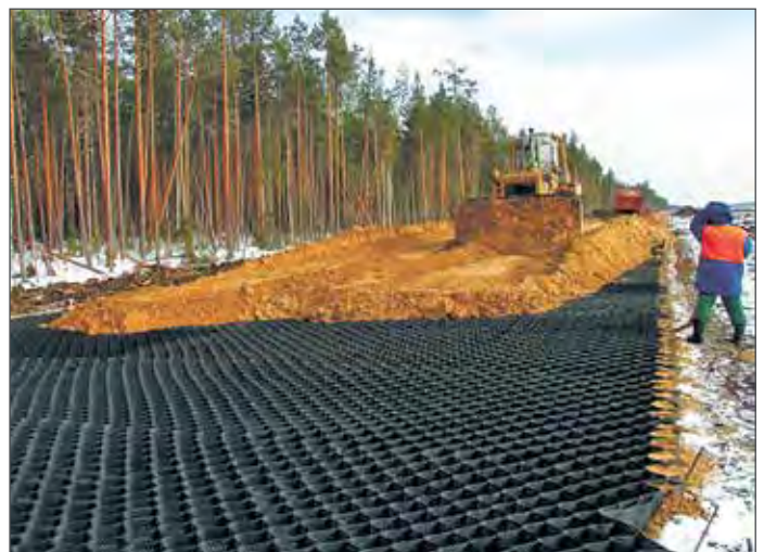
Рис. 2. Строительство автомобильной дороги с применением пространственной пластиковой георешетки с заполнителем в качестве дорожной одежды
