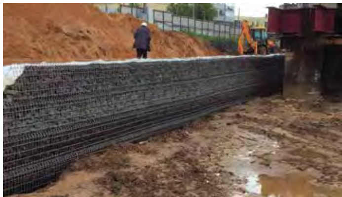
Устройство временных мостов через р. Сходня. Волоколамское шоссе, Москва
