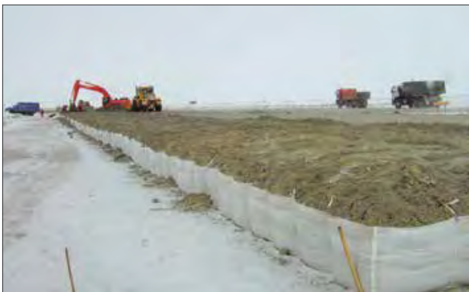
Рис. 3 – Строительство автомобильной дороги с использованием геоболочки с наполнителем в качестве земляного полотна
