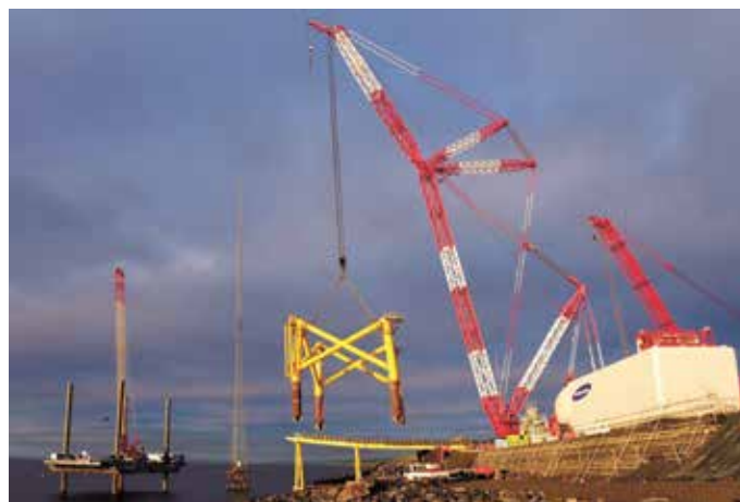
Временные армогрунтовые конструкции для обеспечения доступа сверхтяжелых кранов. Ветропарк Fife Energy Park, Великобритания
