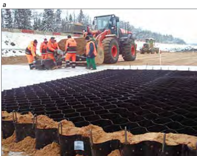
Рис. 2. Укрепление основания автомобильных дорог геоячейками «Прудон-494»: а – строительство М-1 «Беларусь»; б – строительство ЦКАД
