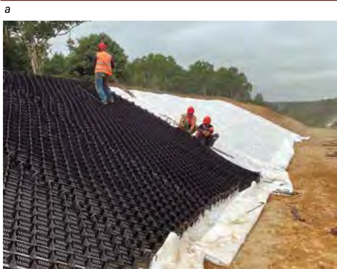
Рис. 3. Защита от эрозии объемными геоячейками «Прудон-494» откосов дорог: а – строительство автодорожного обхода г. Сосновый Бор на А-121 в Ленинградской обл.; б – «Реконструкция автомобильной дороги Южно-Курильск – Головнино, о. Кунашир»
