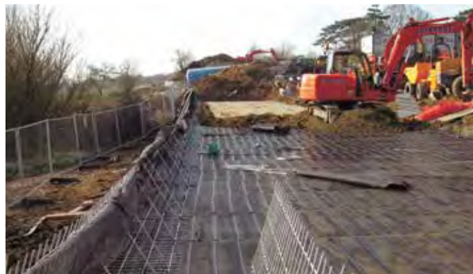
Уложенный участок грунта при возведении временной армогрунтовой стены
