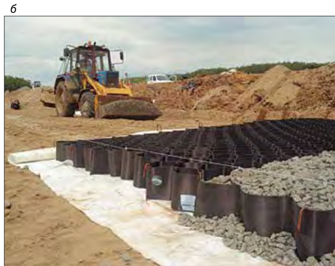
Рис. 2. Укрепление основания автомобильных дорог геоячейками «Прудон-494»: а – строительство М-1 «Беларусь»; б – строительство ЦКАД
