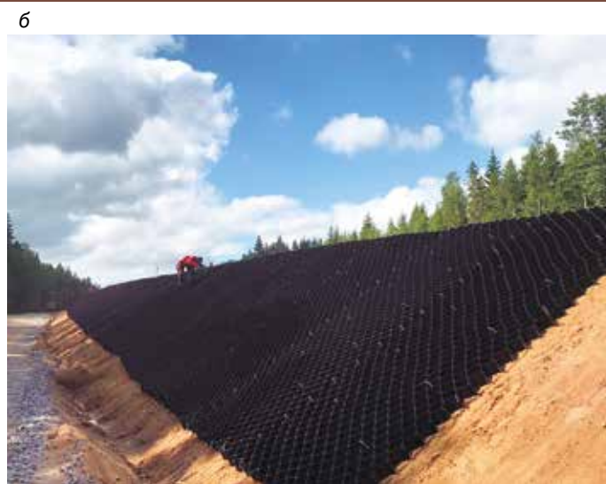
Рис. 3. Защита от эрозии объемными геоячейками «Прудон-494» откосов дорог: а – строительство автодорожного обхода г. Сосновый Бор на А-121 в Ленинградской обл.; б – «Реконструкция автомобильной дороги Южно-Курильск – Головнино, о. Кунашир»
