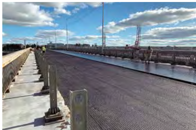
Рис.3. Приклеенная георешётка HaTelit C40/17 (с ячейками 40x40мм) к гидроизоляции моста с частично устроенной по ней литой асфальтобетонной смесью, тип 1.
