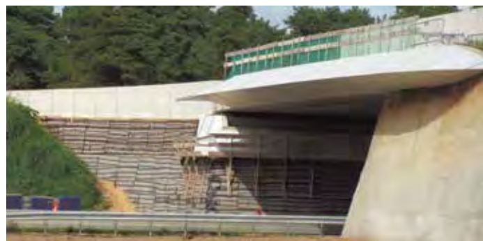
Мостовой переход с облицовкой, выполненной методом оборачивания
