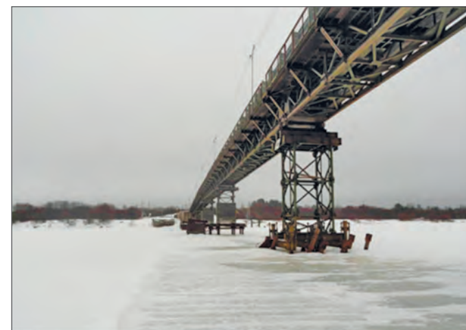
Рис. 1. Временный мост на основе САРМ, который эксплуатируется более 5 лет. Требуется замена на постоянную конструкцию. ЦНИИТС выполнял работы по диагностике и динамические испытания моста.
