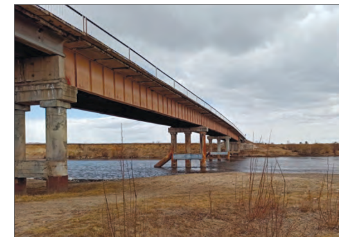
Рис. 2. Сталежелезобетонный мост у г. Чита. Постройка середины 80-х годов. Состояние работоспособное. ЦНИИТС выполнял диагностику моста, статические и динамические испытания в 2021 году.
