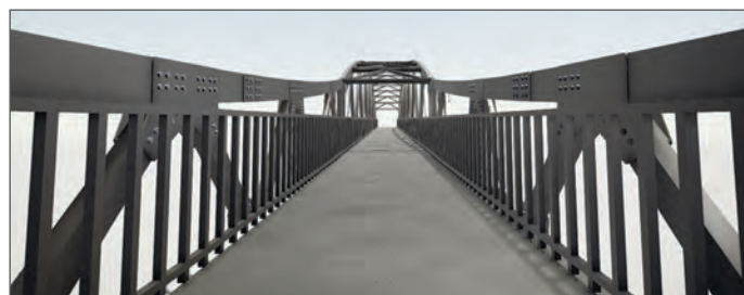
Пешеходный мост в г. Козьмодемьянск, 14+35 м, 5+13 т — основные конструкции
