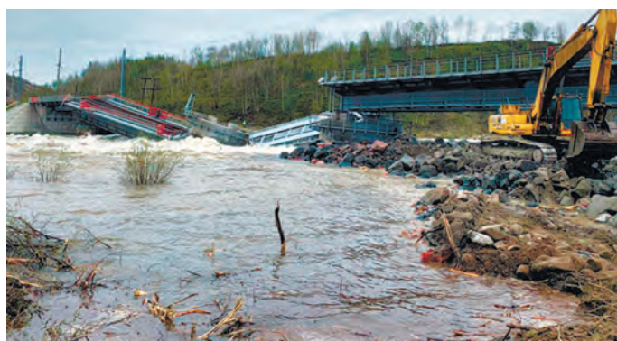
Рис. 3. Разрушение нового железнодорожного моста после реконструкции (г. Мурманск). ЦНИИС проводил экспертизу.
