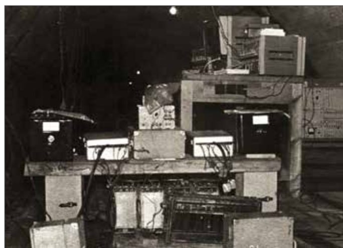
Рис. 6. Аппаратура подземной сейсмической станции во вспомогательной (дренажной) штольне со стороны западного портала в зоне Ангараканской депрессии
