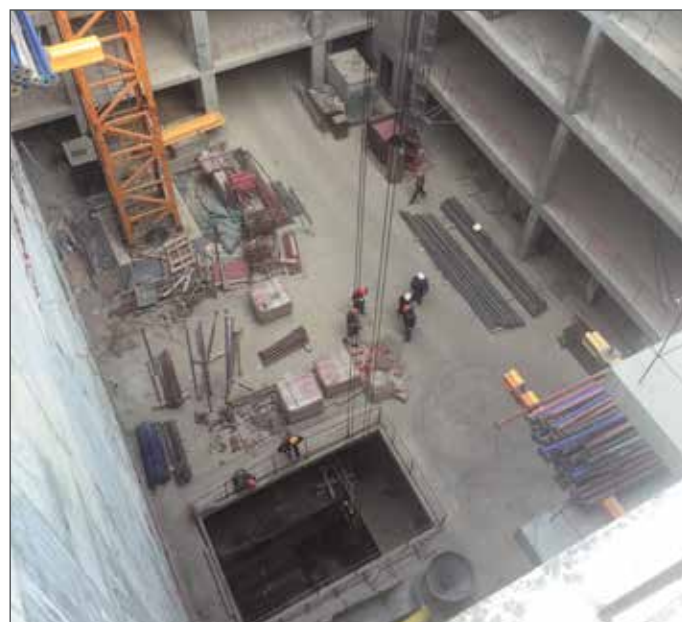
Фото 3. Возведен каркас и монтируется подземная часть здания
