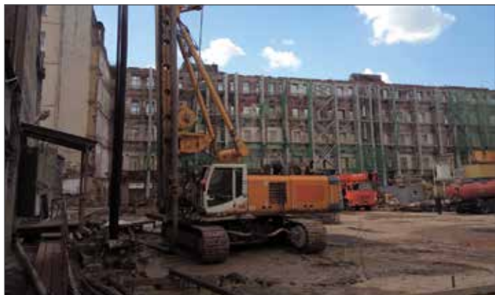
Фото 2. Устройство траншейной стены ограждения подземной части методом «стена в грунте»
