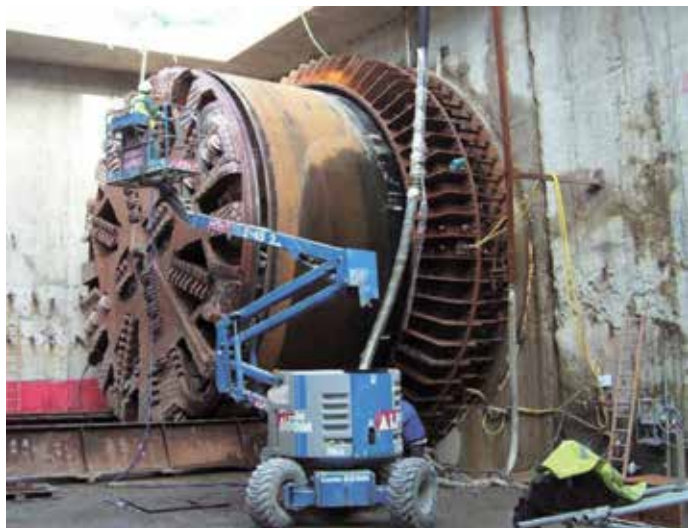
Рис. 3. Ввод ТПМК в котлован через инвентарную металлическую камеру с ниппельным кольцом
