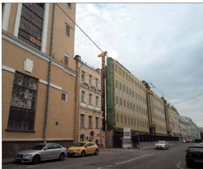
Фото 1. Вид стройплощадки со стороны ул. Садовническая
