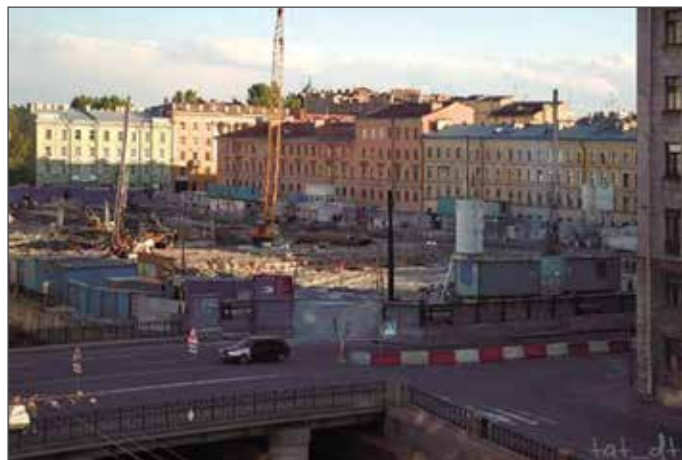
Строительство подземной части комплекса в Санкт-Петербурге
