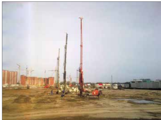
Устройство грунтобетонных элементов (г. Краснодар)
