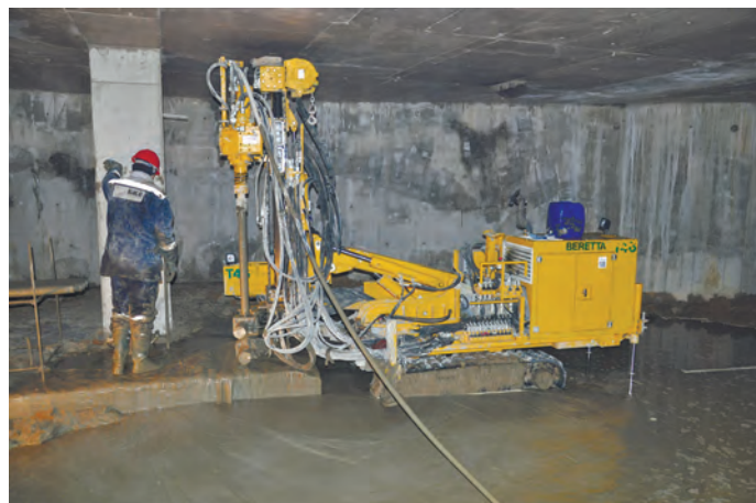
Рис. 5. Выполнение грунтобетонной сваи
