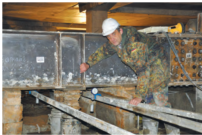
Рис. 9. Проведение статических испытаний
