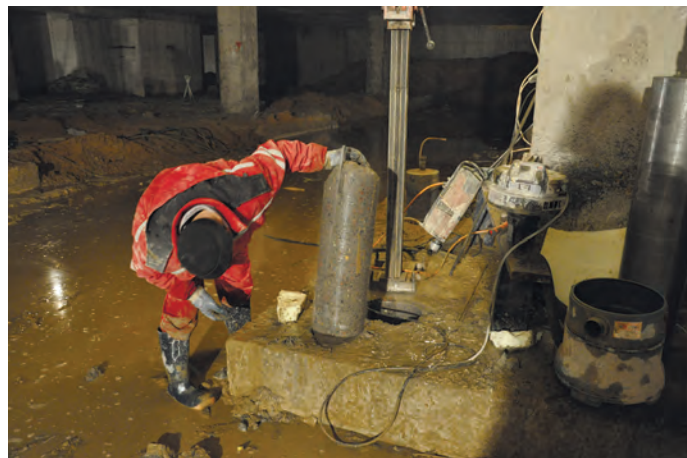
Рис. 4. Проходка технологического отверстия
