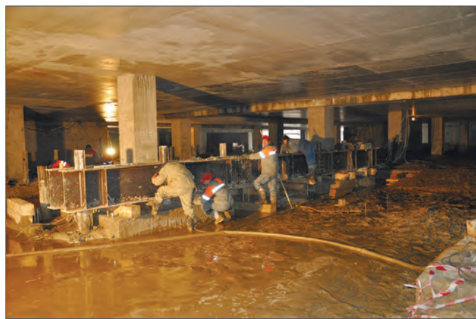
Рис. 8. Монтаж нагружающей системы
